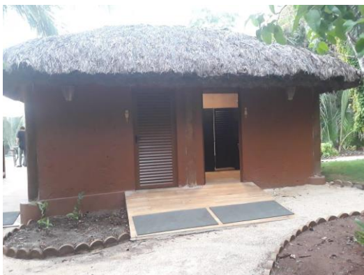
Banheiro com rampa Fonte: Patrícia Rodrigues
