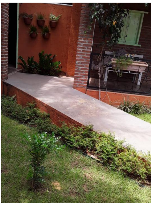
Rampa de acesso Fonte: Patrícia Rodrigues
