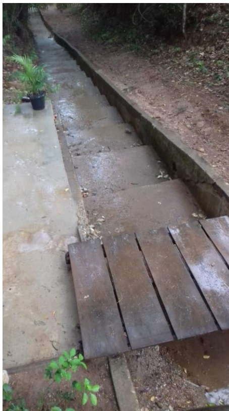
Escada sem acessibilidade Fonte: Patrícia Rodrigues
