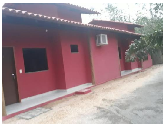
Entrada dos quartos sem acessibilidade Fonte: Patrícia Rodrigues
