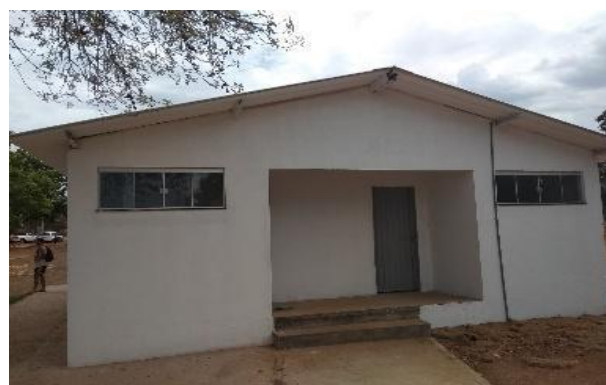
Figura 30: Estrutura dos bombeiros
