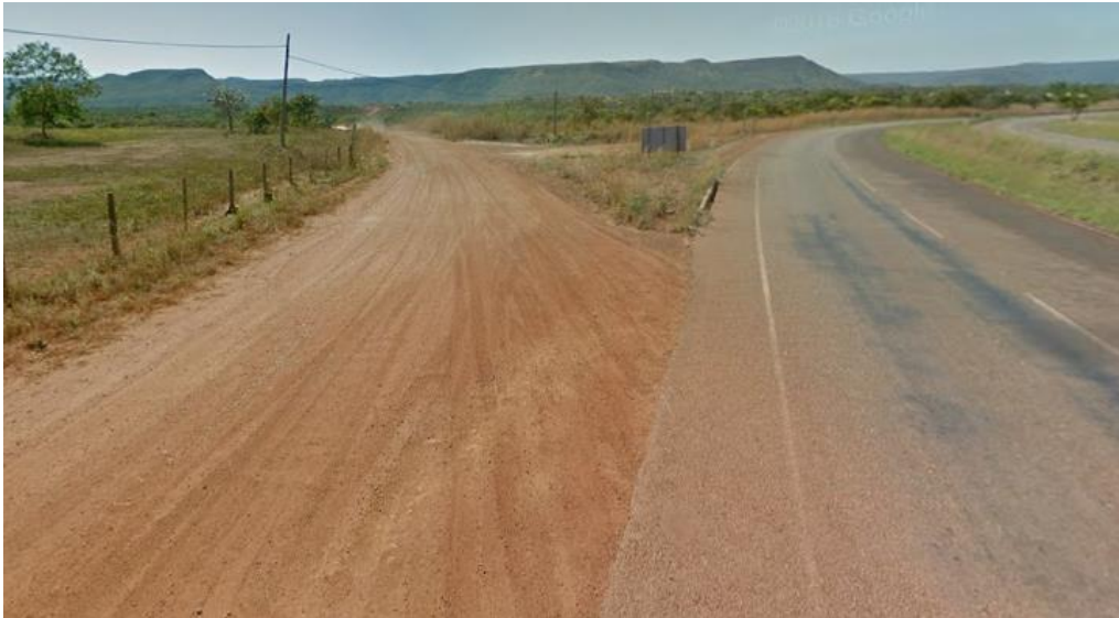
Figura 3 - Acesso principal, sem qualquer sinalização
