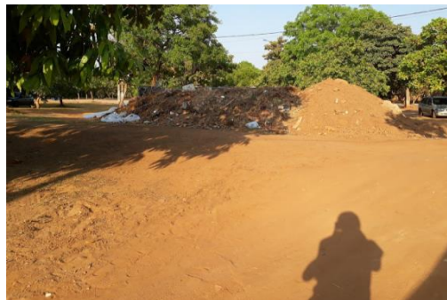
FIGURA 3: Entulhos da reforma.
