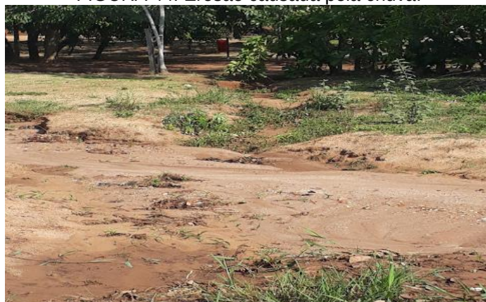
FIGURA 44: Erosão causada pela chuva.
