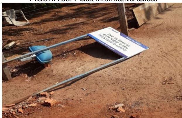
FIGURA 38: Placa informativa caída.
