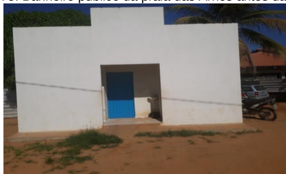
FIGURA 5: Banheiro público da praia das Arnos antes da reforma.
