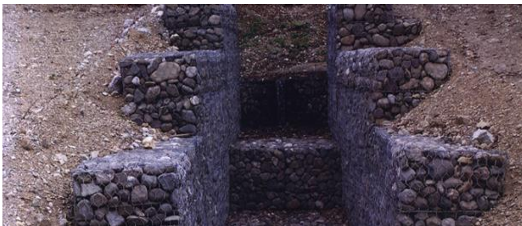
Figura 39 - Revestimento Simples de malha.
