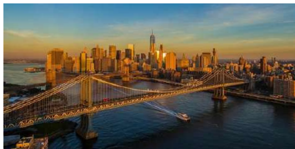
Figura 60: Ponte de Manhattan - Estados Unidos
