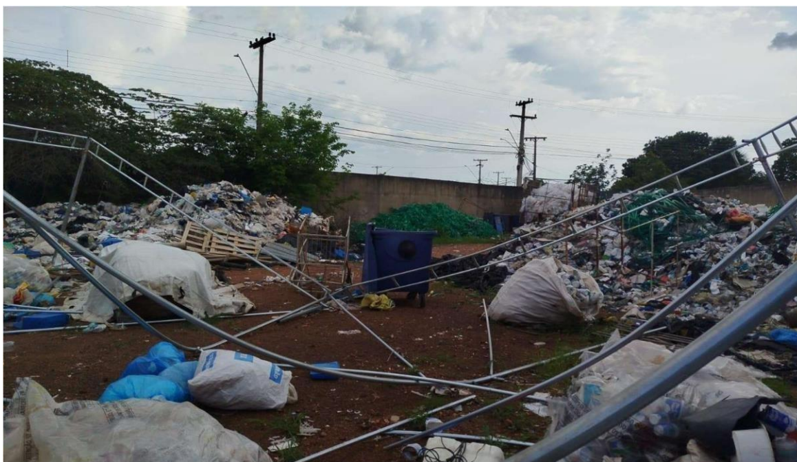
Imagem 8 - Estrutura da antiga cobertura.
