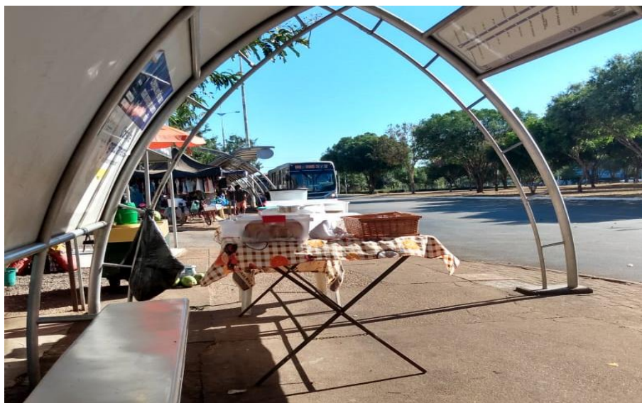
Figura 2 – Estrutura física da estação Apinajé – Palmas TO
