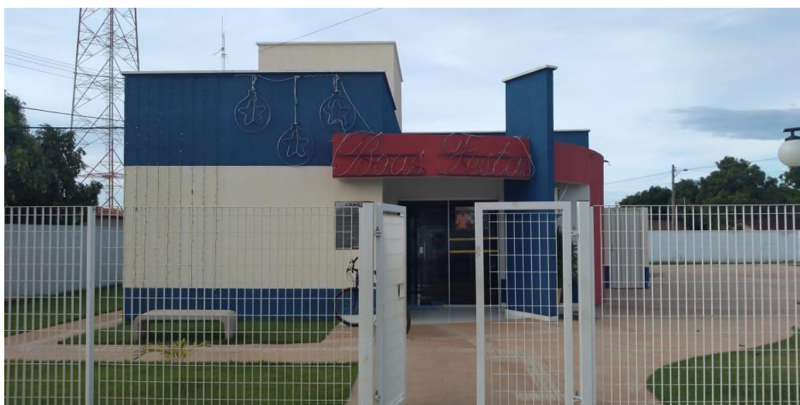
Figura 5: Nova sede do CRAS no Município de Conceição do Tocantins
