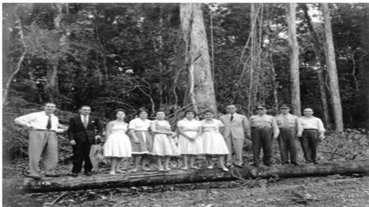
FIGURA 02- - Imagem documental 1 Juscelino Kubitschek (4º da dir.) e a Senhora Sara (ao centro das senhoras) em visita às obras da rodovia Belém-Brasília. (CPDOC/FGV/Arquivo Nelson de Melo/2ª rem.). Fonte: Vinhal, 2009, p.31
