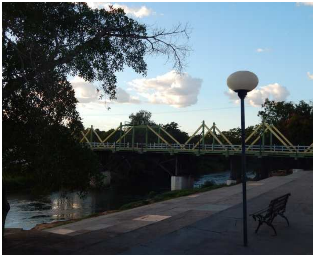
Figura 4 -Ponte sobre o Rio Ponte alta do Tocantins
