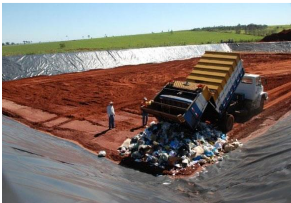
Figura 4.3.1- Caminhão despejando o lixo no aterro sanitário
