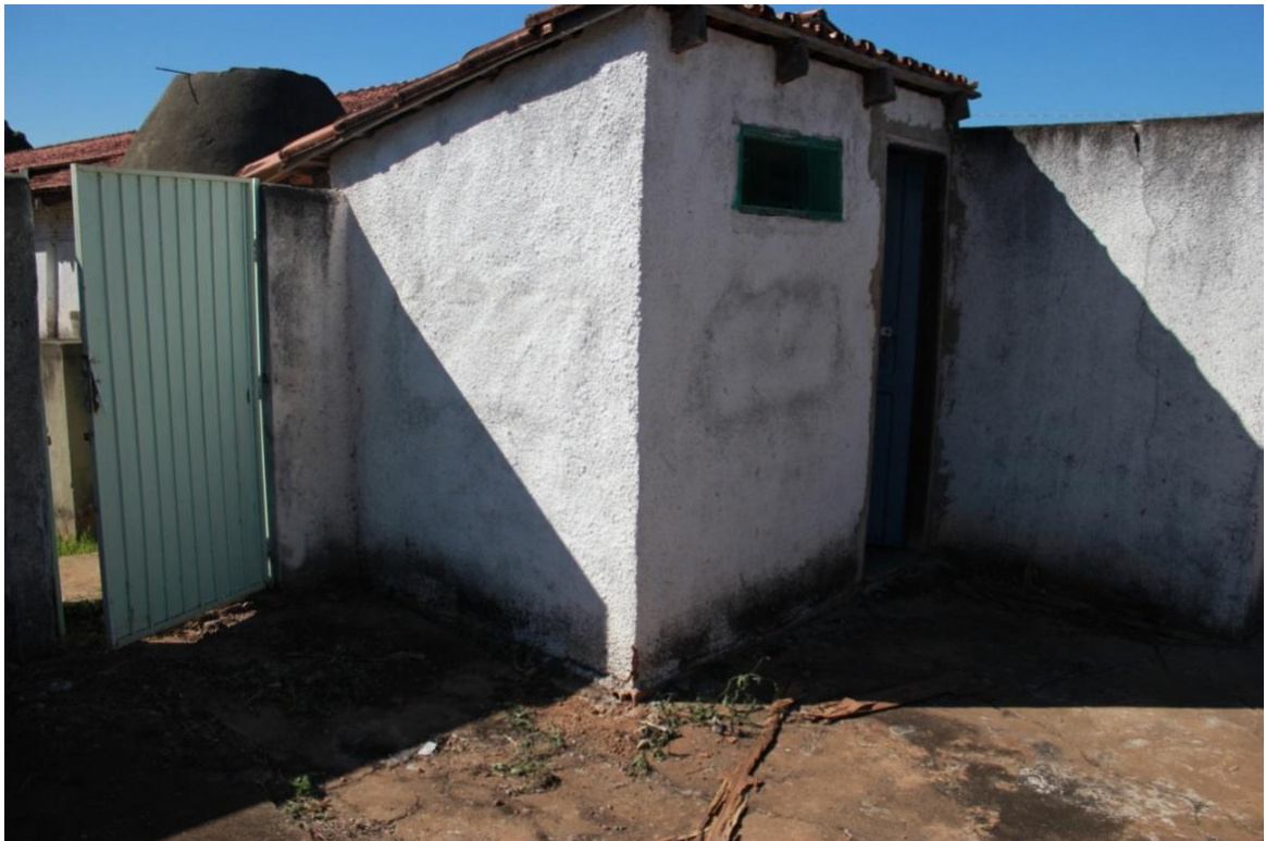
Figura 7 – Local de Armazenamento externo
