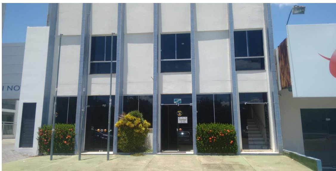
Figura 03 - Fachada do prédio da Junta de Serviço Militar Palmas - TO
