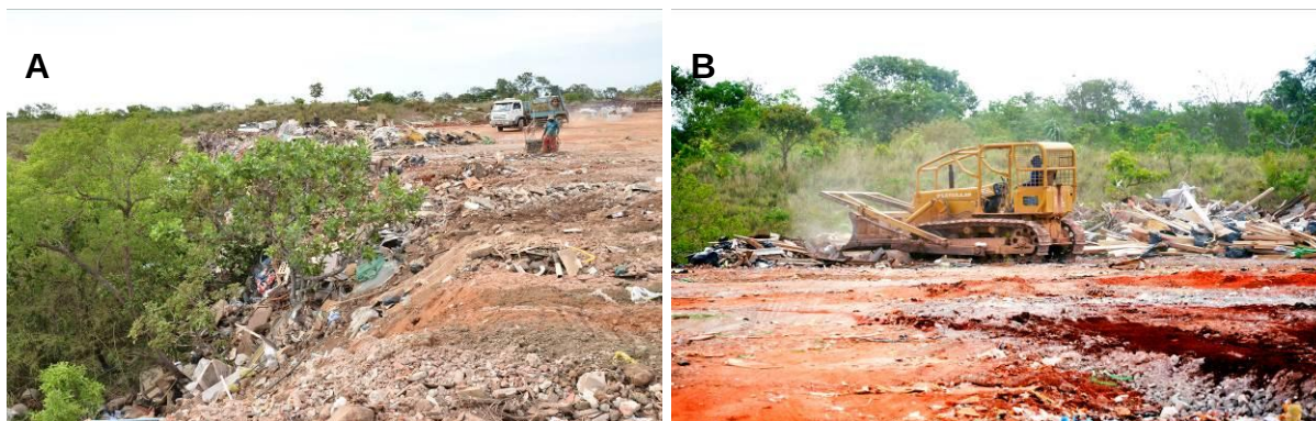
Figura 4. Disposição em voçoroca e compactação de entulho com trator
