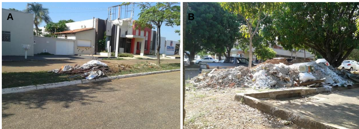
Figura 5. Disposição de entulho em canteiro
