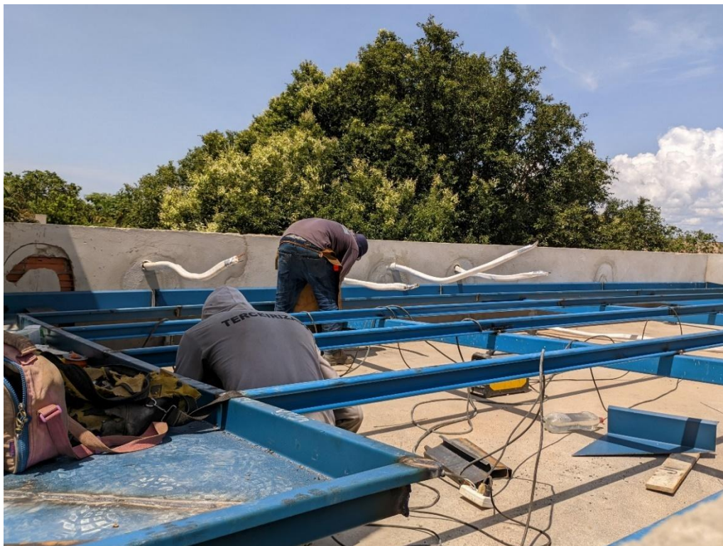
Figura A7 - Execução de corte e dobra de estrutura p/cobertura
