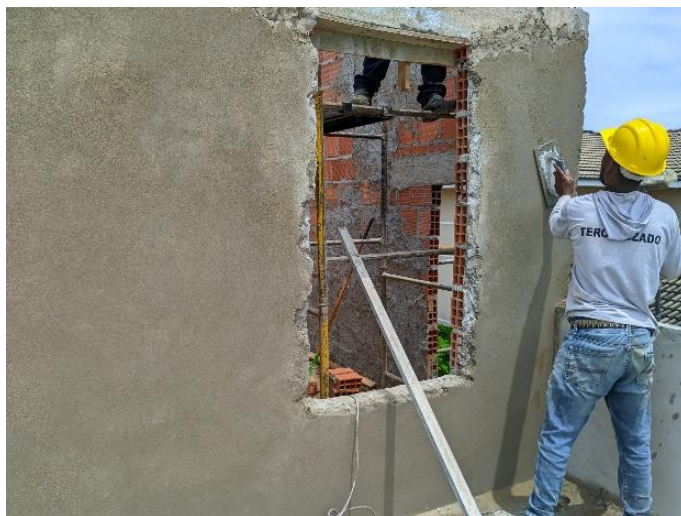
Figura 12 – Execução requadro de vão de portinhola
