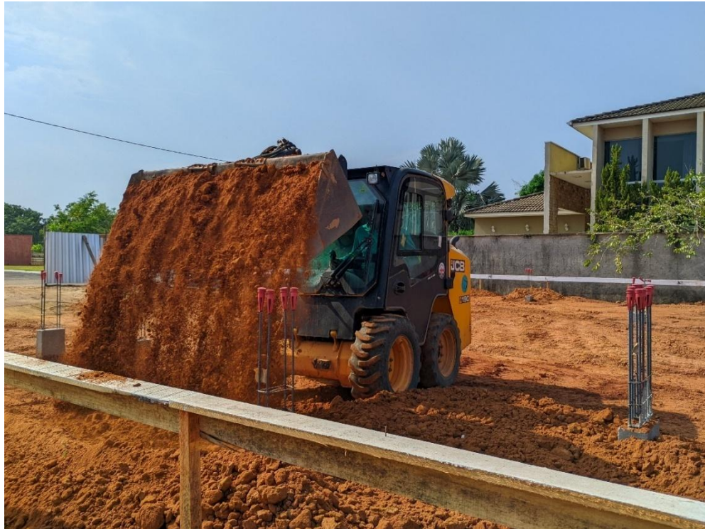
Figura A3 - Movimentação mecanizada de solo para aterro das sapatas
