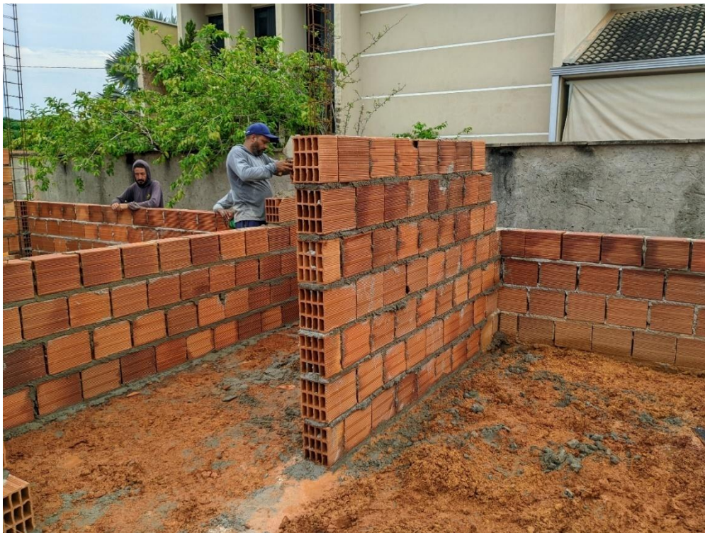
Figura A4 - Execução de levante de alvenaria
