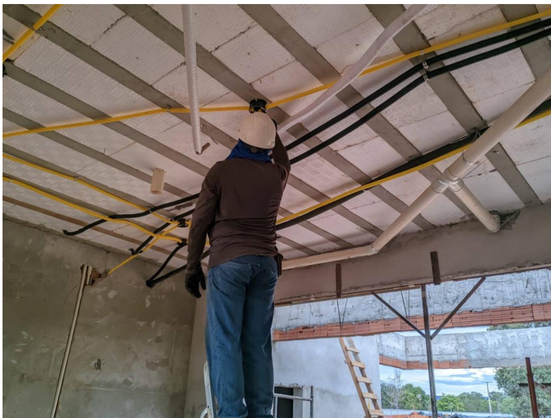
Figura A9 - Execução de instalações elétricas
