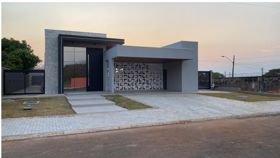
Figura A10 - Imagem da obra finalizada
