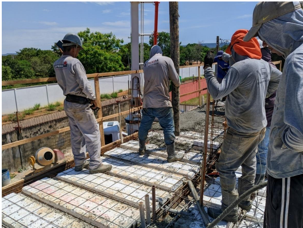
Figura A5 - Execução de concretagem da laje
