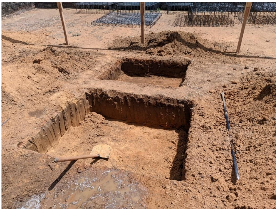
Figura A1 - Escavação manual fundação do tipo sapata isolada
