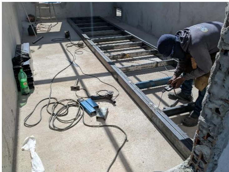
Figura 11 - Fabricação e colocação de base em estrutura metálica para caixa d'água
