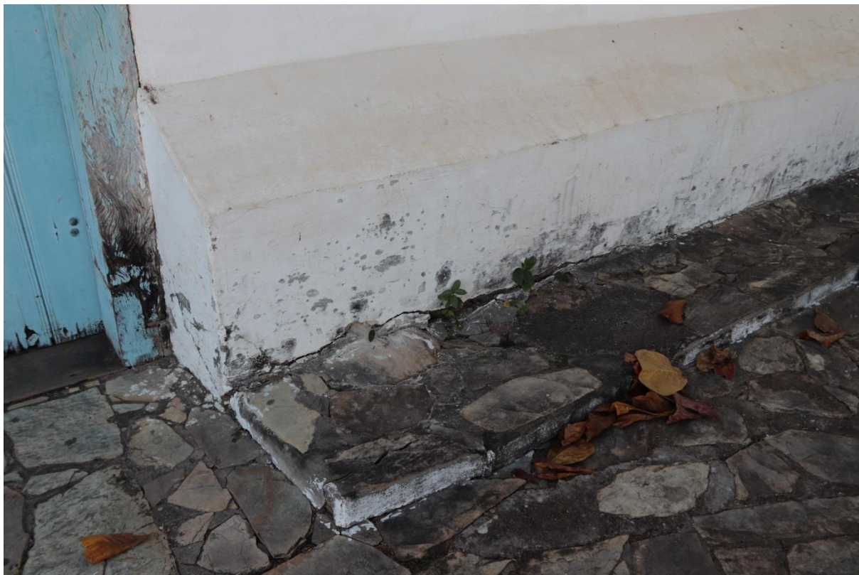
Figura 3 - Umidade nos alicerces
