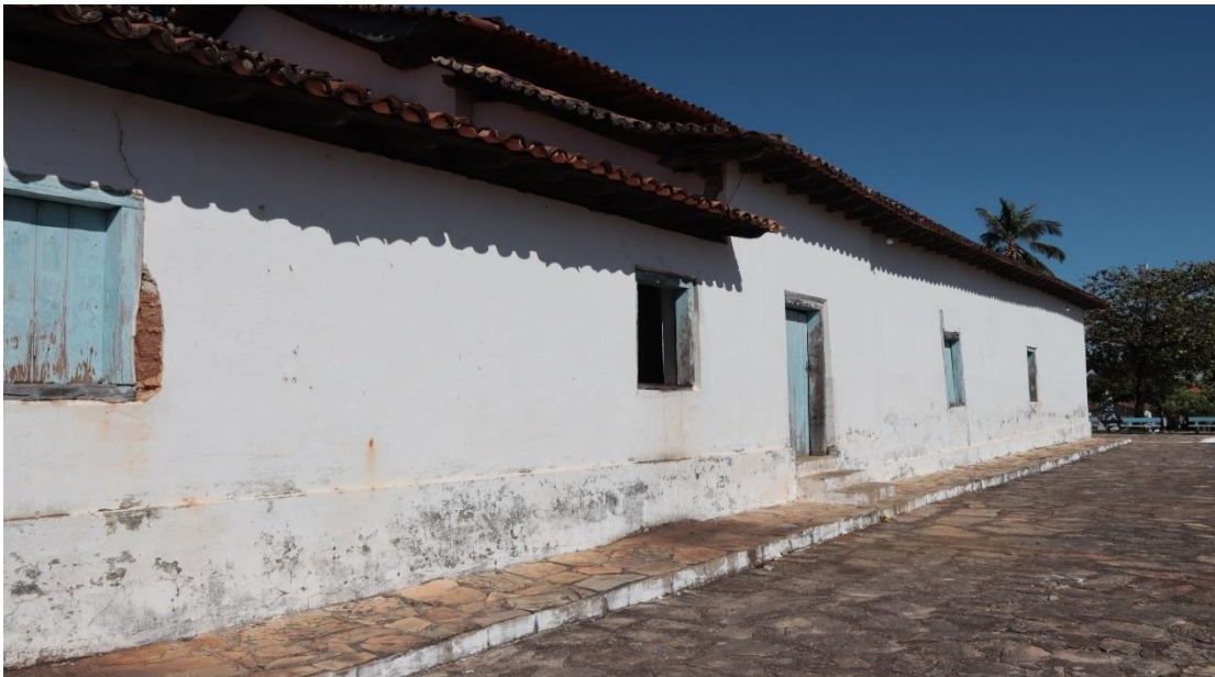
Figura 23 – Fachada esquerda da Igreja
