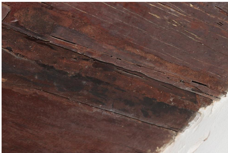
Figura 16 - Degradação no revestimento
