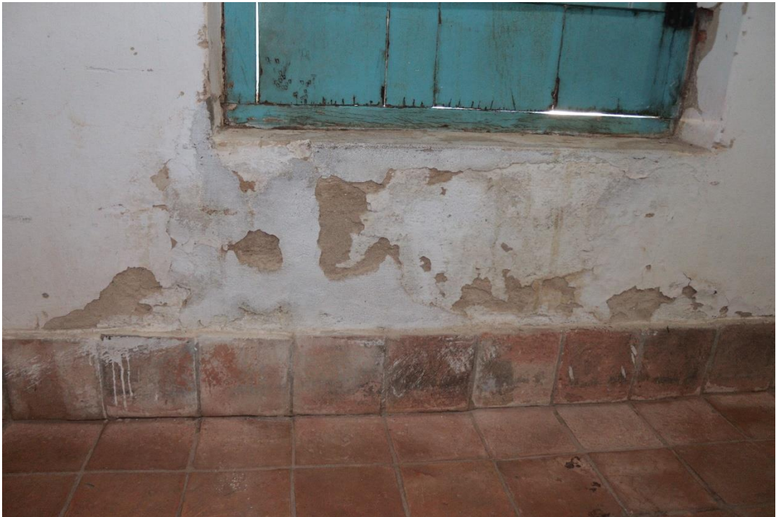
Figura 16 - Degradação no revestimento
