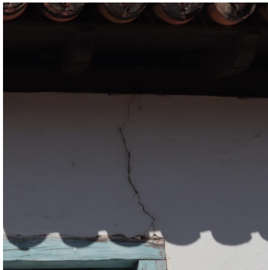
Figura 28 - Fissuras
