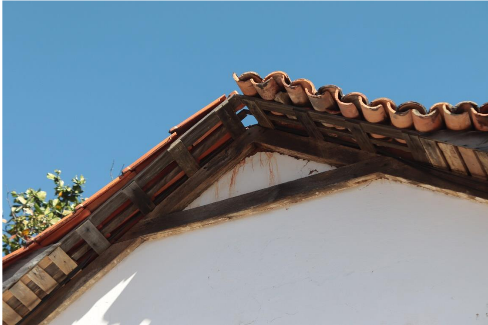
Figura 45 - Telhado danificado
