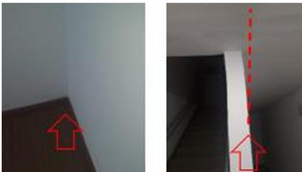
Figura 2 – Alinhamento dos pilares
