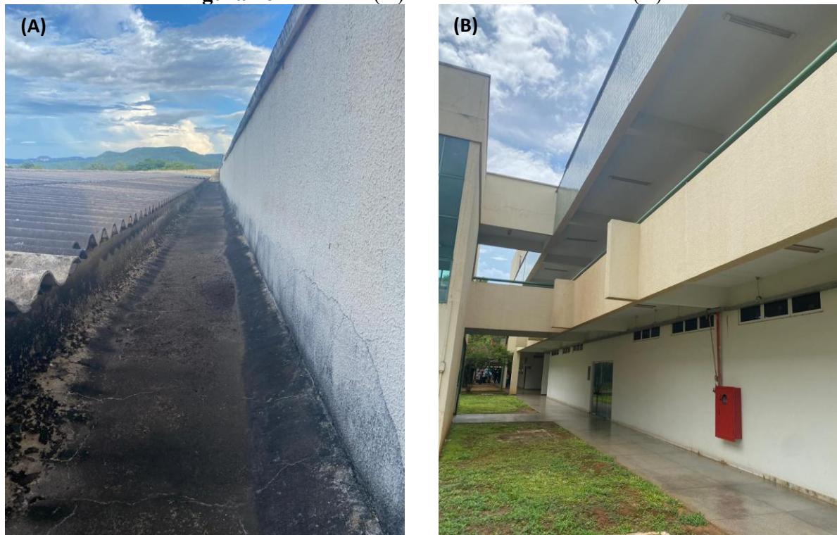
Figura 16 - Telhado (A) e Vista Lateral do bloco (B)
