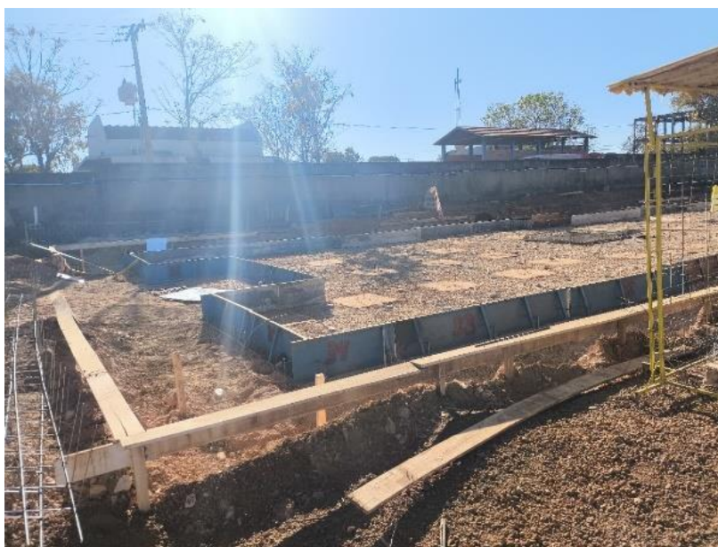
Figura 6 – Fôrma do radier.
