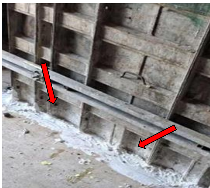
Figura 48 – Calafete no “pé” da fôrma
