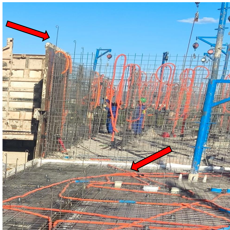
Figura 13 – Esperas para pavimentos adjacentes.
