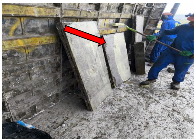
Figura 35 – Aplicação de desmoldante.
