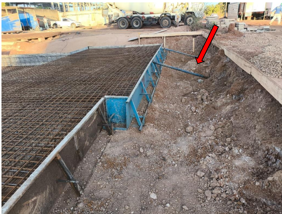
Figura 9 – Escoramento de fôrma de radier.
