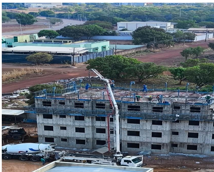
Figura 18 – Concretagem com “bomba lança”.
