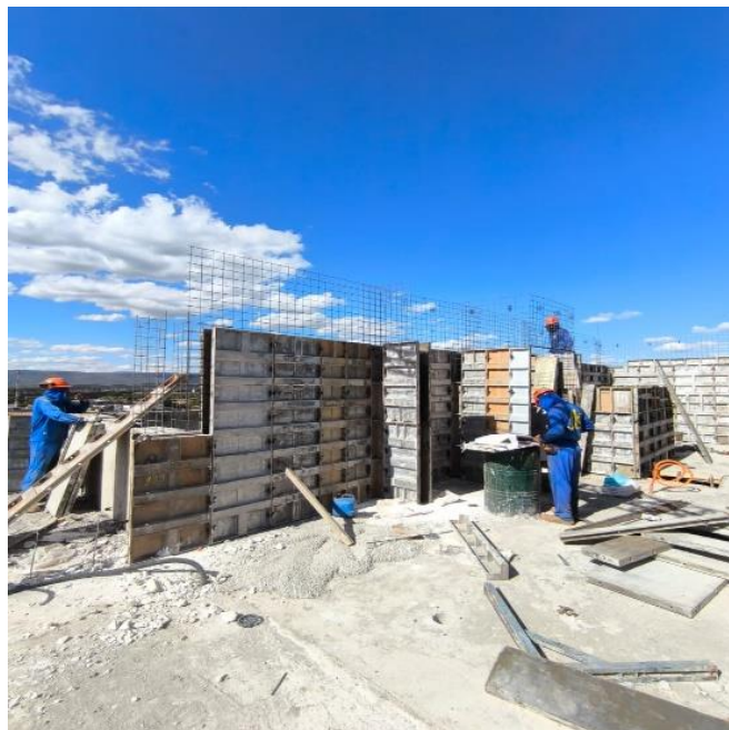
Figura 17 – Fechamento da fôrma.
