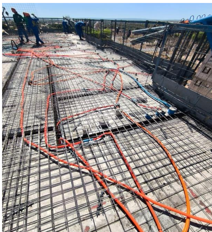
Figura 16 – Instalações horizontais embutidas.
