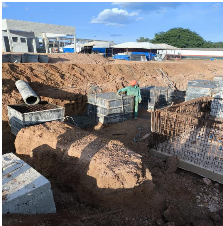
Figura 5 – Concretagem de bloco de coroamento.
