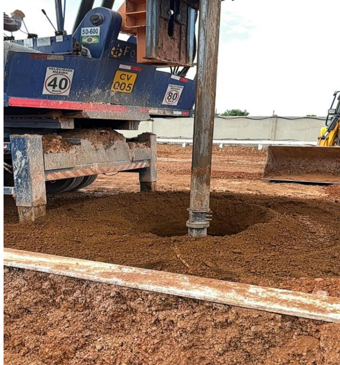
Figura 2 – Penetração do trado.
