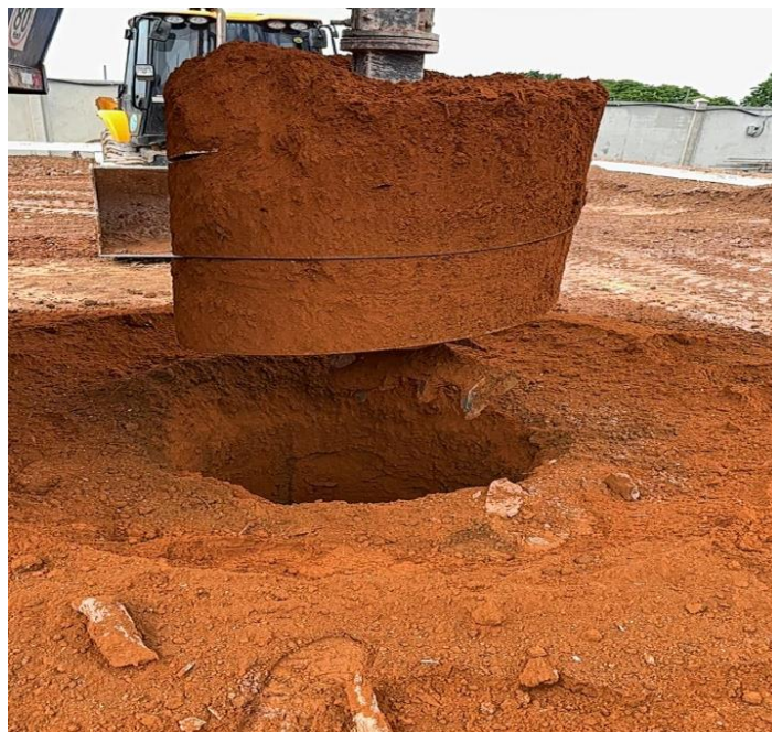
Figura 3 – Retirada do trado.
