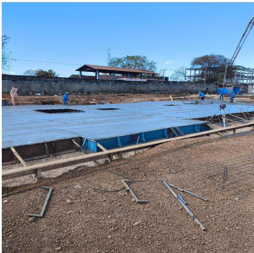
Figura 10 – Concretagem de radier.
