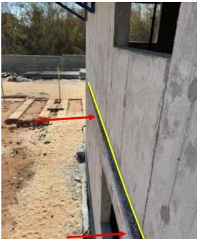
Figura 52 – “dentes” entre pavimentos.
