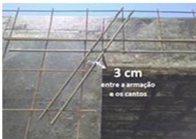
Figura 34 – Reforços de verga e contraverga.
