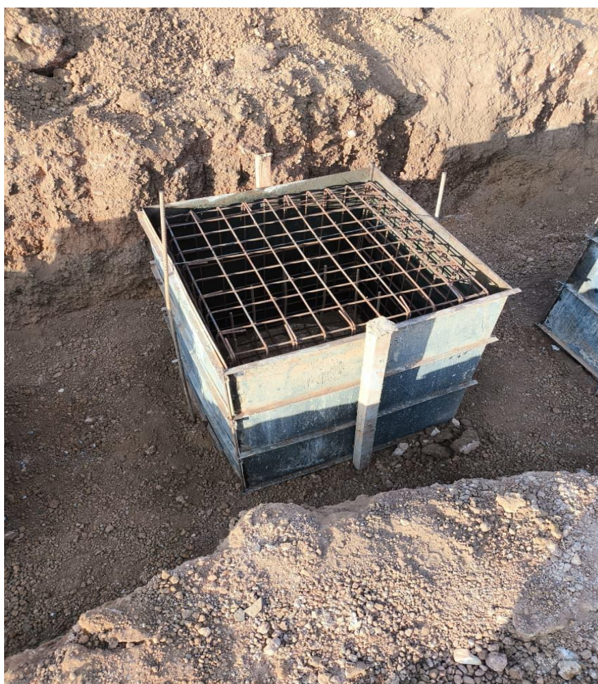
Figura 4 – Fôrma de bloco de coroamento.
