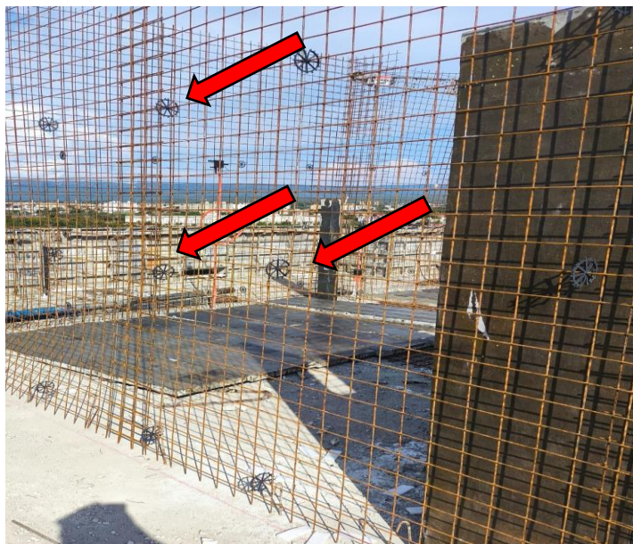
Figura 29 – espaçador de parede posicionado.
