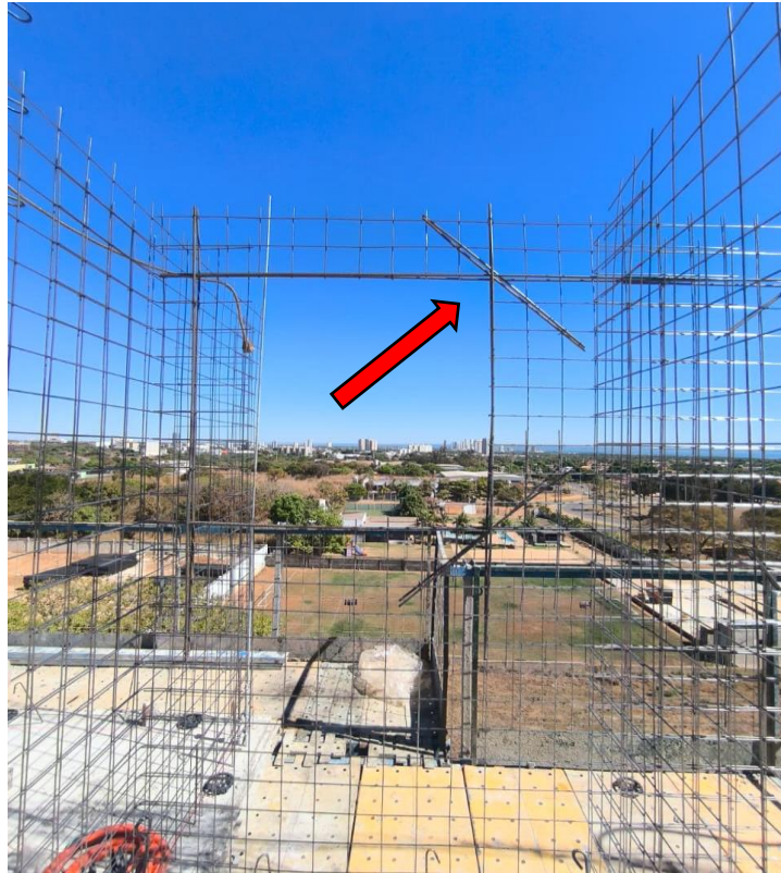
Figura 12 – Armação vertical de parede.
