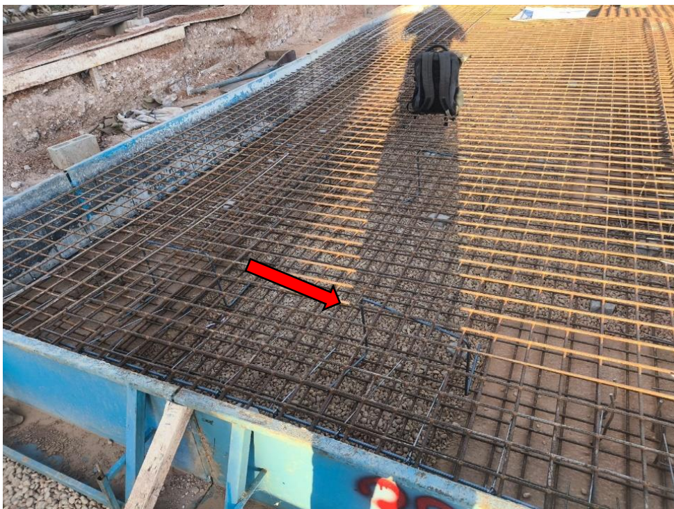
Figura 8 – Espaçadores de armadura.
