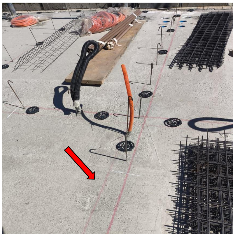
Figura 11 – Marcação das paredes.
