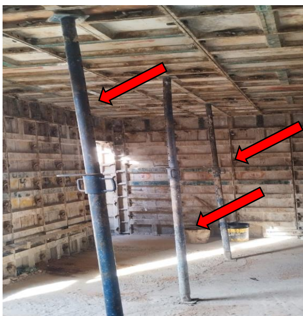
Figura 44 – Escoramento de laje.
