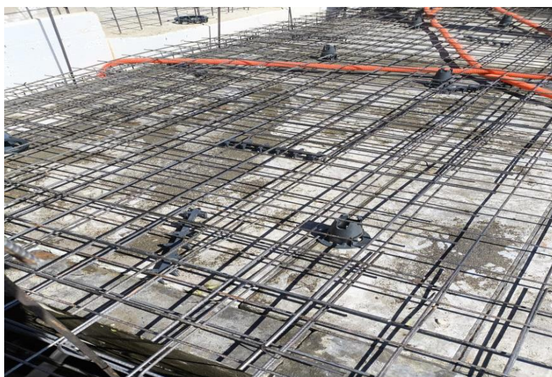
Figura 33 – Espaçadores posicionados na laje.
