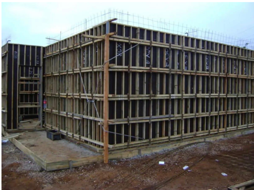
Figura 20 – Fôrma de madeira.
