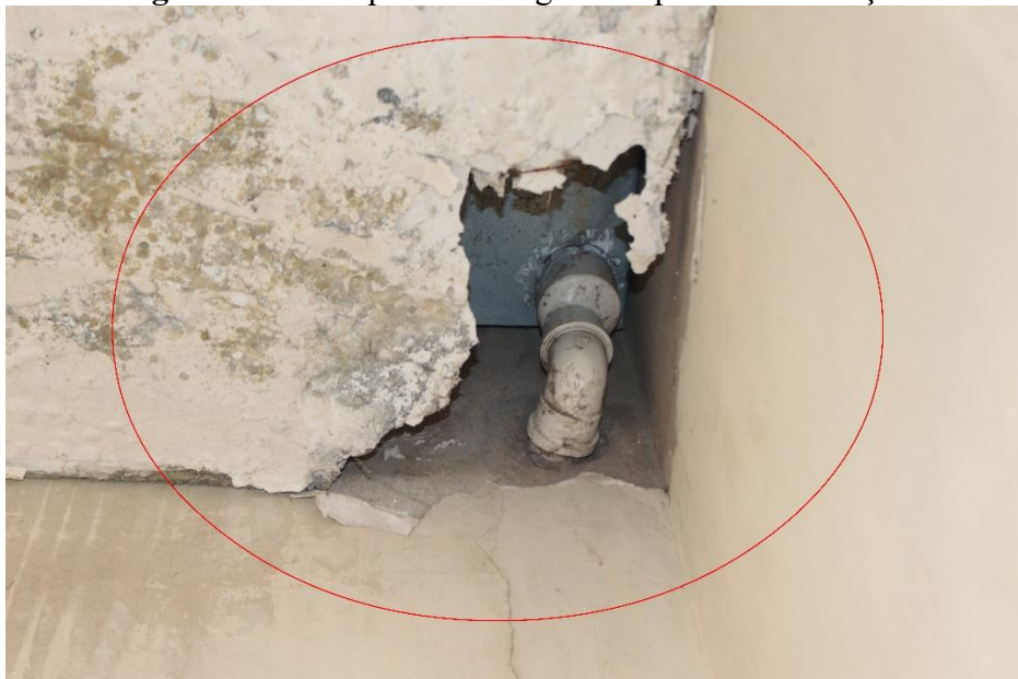
Figura 44 – Rompimento do gesso expondo a tubulação
