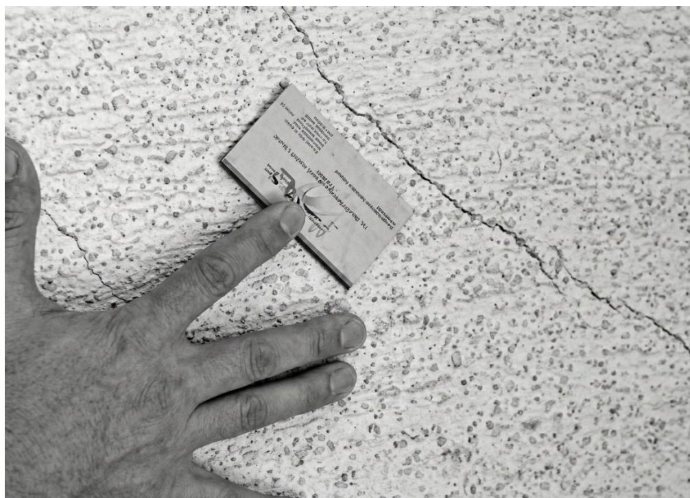
Figura 7 – Representação de Fissura em um revestimento argamassado
