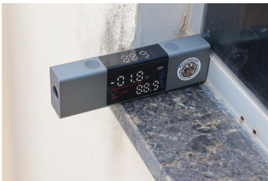
Figura 51 – Inclínômetro digital medindo a declividade do peitoril da janela
