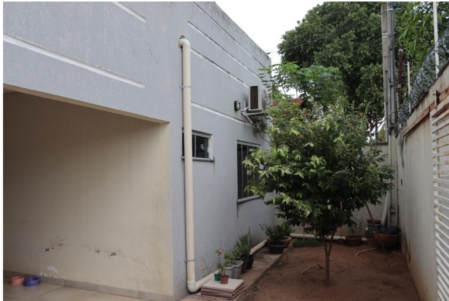
Figura 54 – Tubulações de PVC expostas na fachada
