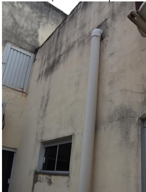
Figura 55 – Tubulações de PVC expostas na fachada
