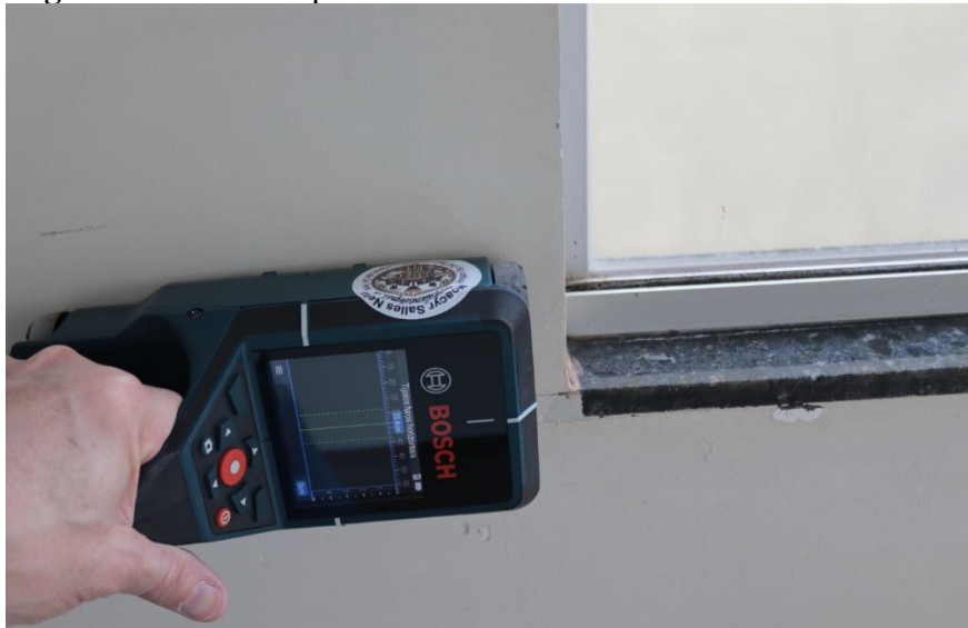
Figura 48 – Tela do pacômetro confirmando ausência de armadura
