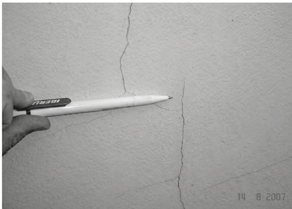
Figura 6 – Representação de Fissura em um revestimento argamassado
