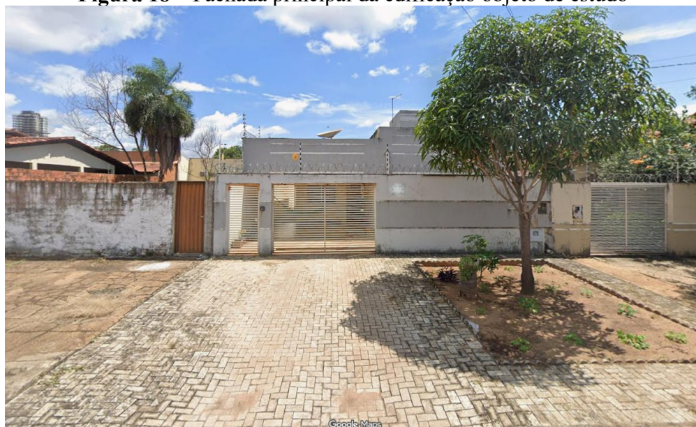
Figura 18 – Fachada principal da edificação objeto de estudo
