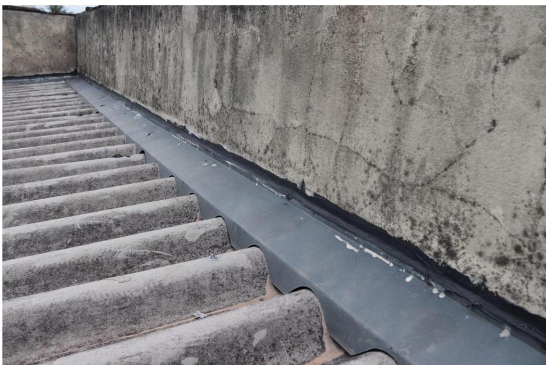
Figura 26 – Rufo do sistema de cobertura
