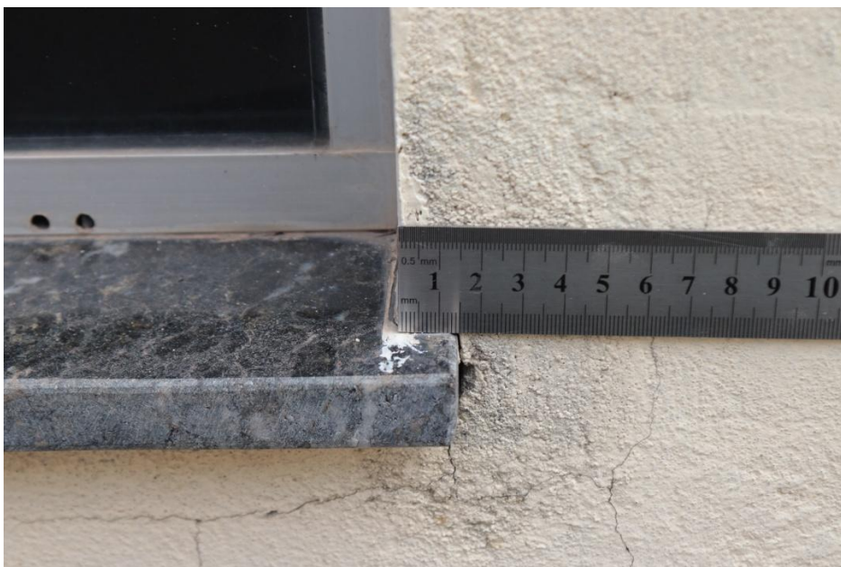
Figura 50 – Trespasse lateral do peitoril inferior ao padrão de 2,5cm
