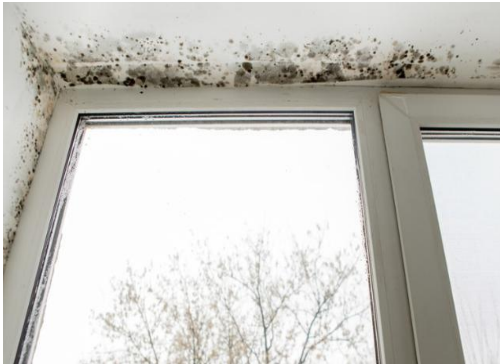
Figura 13 – Manifestação de bolores no sistema de vedações interno
