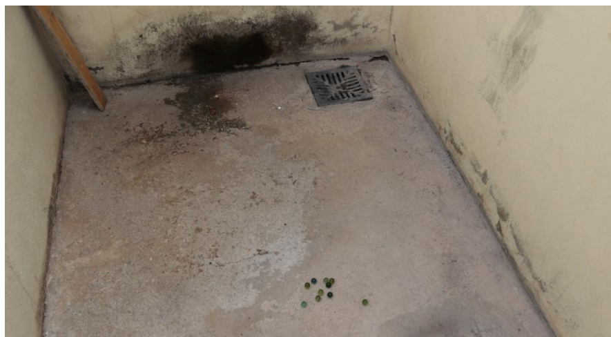
Figura 53 – Esferas de vidro estáticas sobre o piso sem caimento
