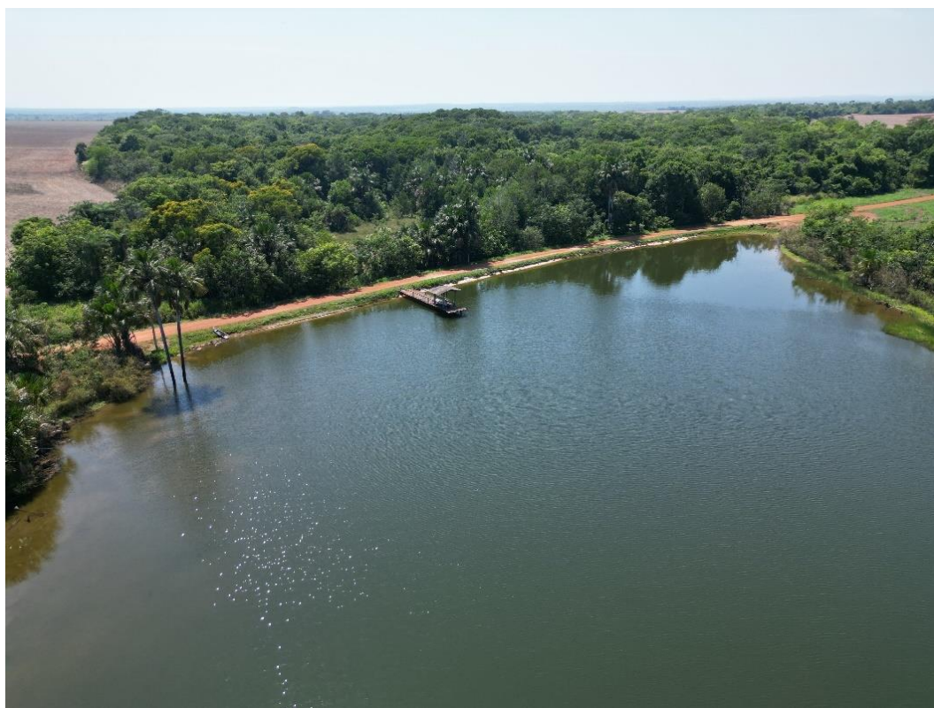
Figura 24 – Vista aérea da barragem obtida por drone
