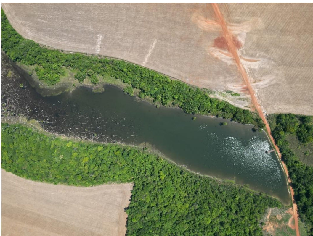
Figura 26 – Visão aérea do reservatório
