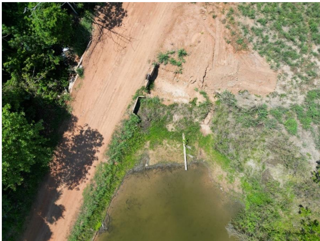
Figura 21 – Vista superior dos extravasores
