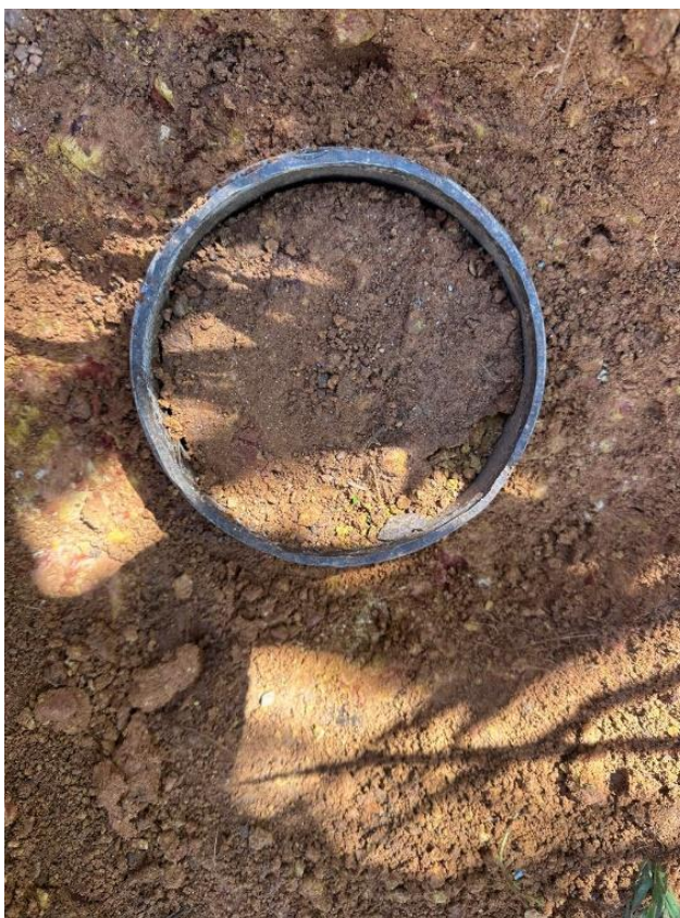
Figura 28 – Cravação do cilindro metálico
