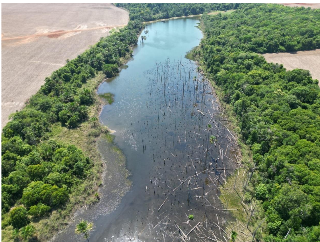
Figura 16 – Imagem completa reservatório e ao fundo a barragem.
