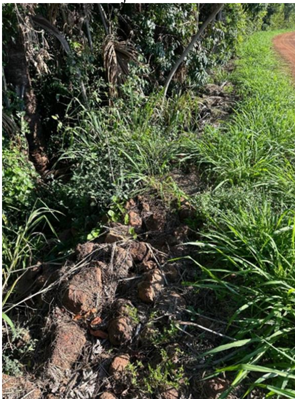
Figura 22 – Vista do talude de jusante evidenciando a densa vegetação.
