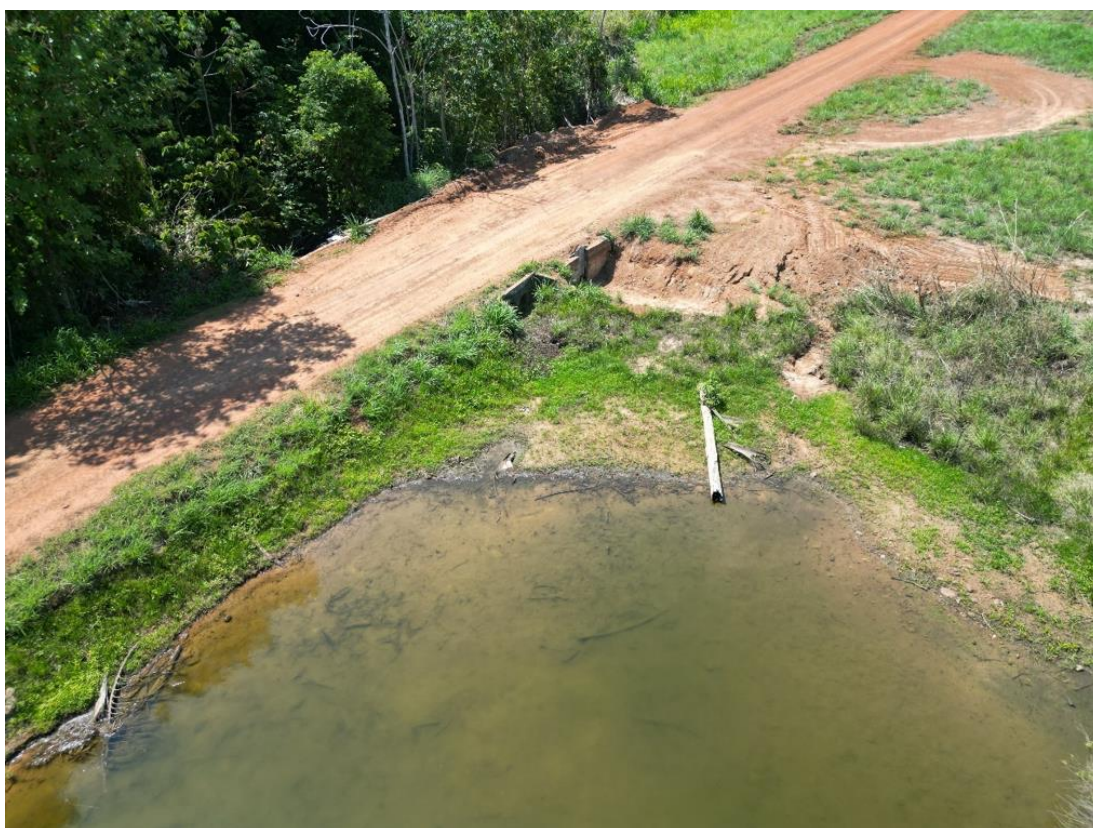
Figura 20 – Estrutura dos extravasores.
