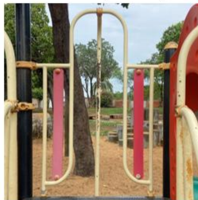
Corrosão de guarda corpo
