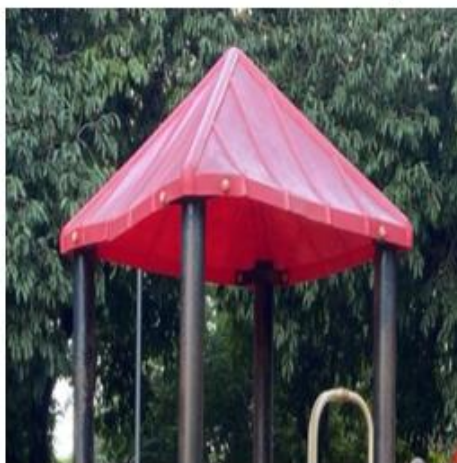
Desbotamento de elemento superior
