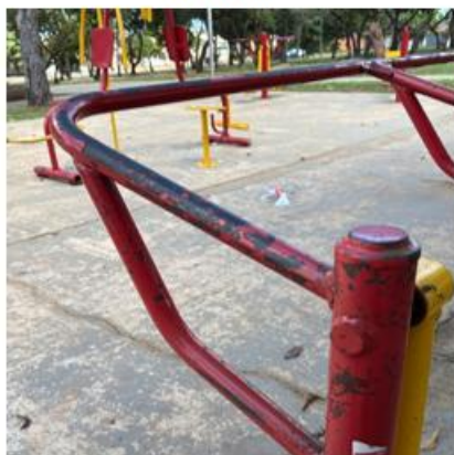
Descascamento de pintura e corrosão
