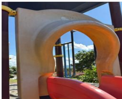
Desbotamento de peça
