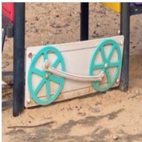
Desbotamento de elemento inferior
