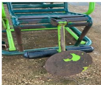
Corrosão generalizada
