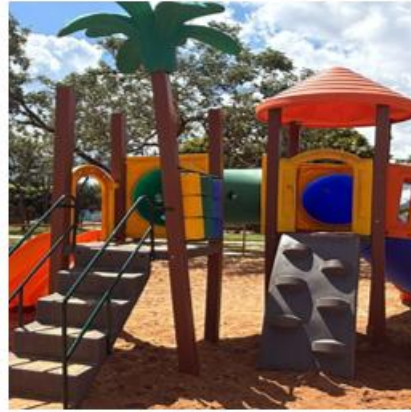
Deformação no elemento estrutural
