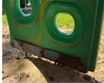
Corrosão da base de fixação
