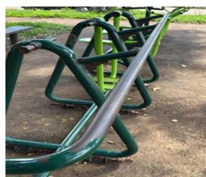
Corrosão elemento tubular
