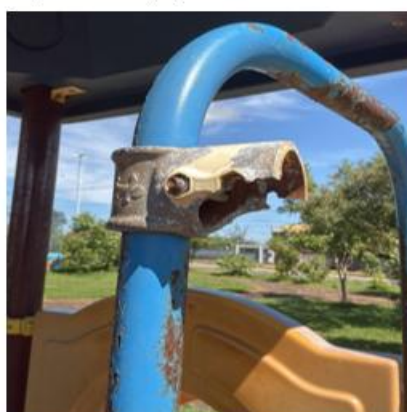
Quebra de peça e aresta cortante
