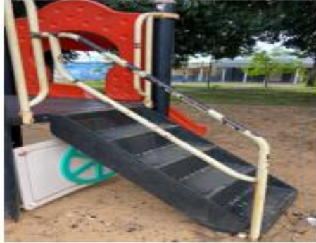
Descascamento de pintura em corrimão
