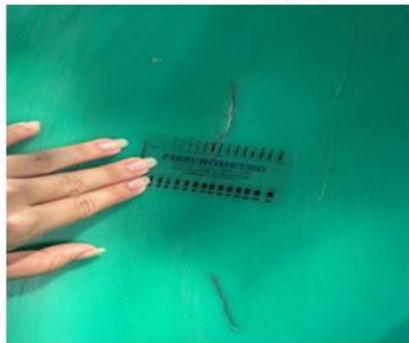
Fissura no escorregador
