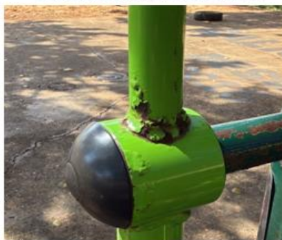
Corrosão na ligação da solda
