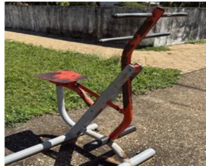
Corrosão de elemento
