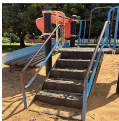
Corrosão de corrimão
