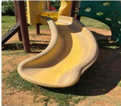
Desbotamento do escorregador
