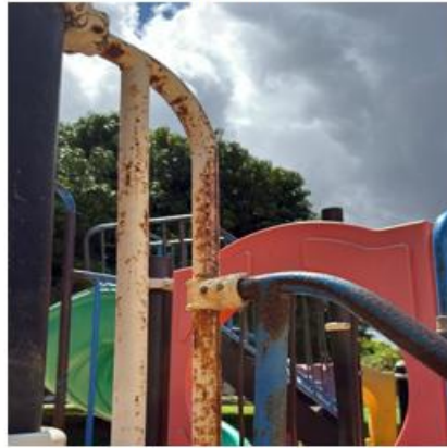
Corrosão de guarda corpo
