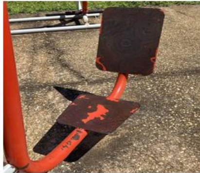
Corrosão de assento e encosto
