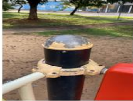
Descascamento de pintura
