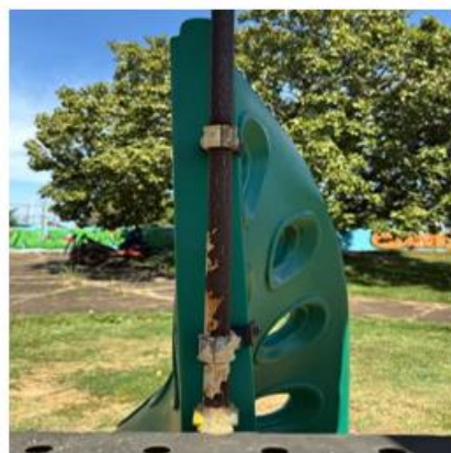
Corrosão de elemento estrutural
