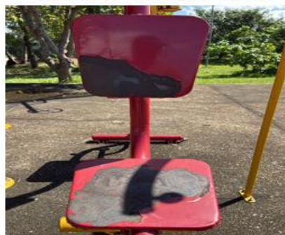
Corrosão de assento e encosto
