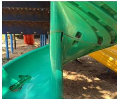
Quebra e trinca no escorregador
