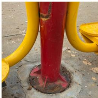
Corrosão da base de fixação
