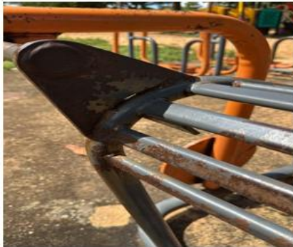
Corrosão de equipamento
