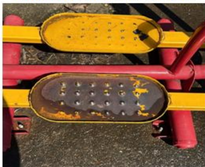
Corrosão de elemento de apoio
