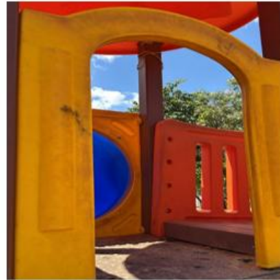
Machas de umidade
