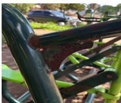
Corrosão peça de ligação
