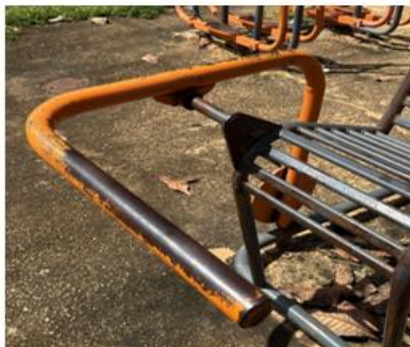
Descascamento de pintura
