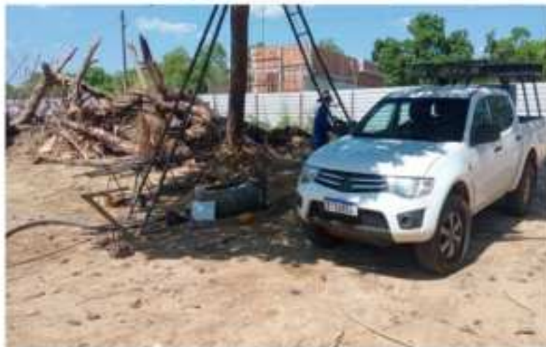
Imagem 05 – Execução do SP3
