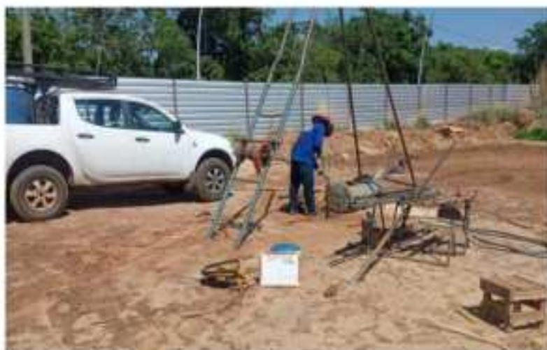
Imagem 01 – Execução do SP1
