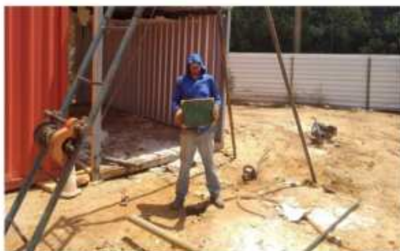
Imagem 04 – Execução do SP2
