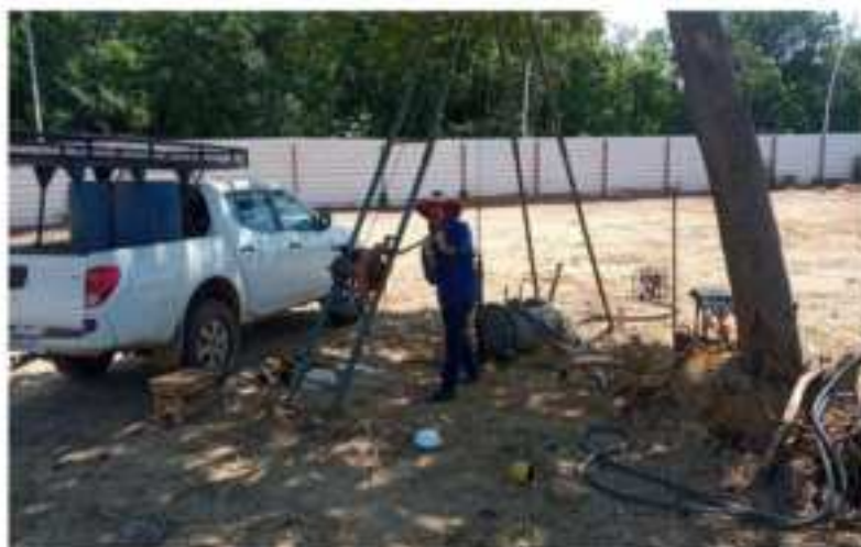
Imagem 06 – Execução do SP3
