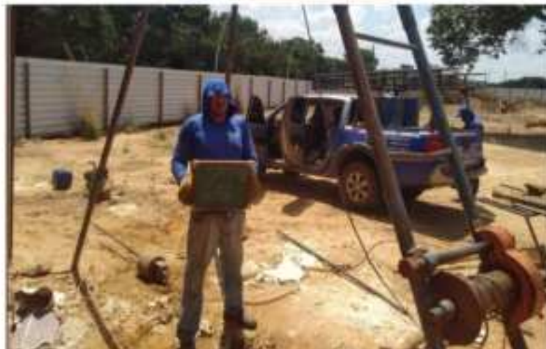
Imagem 03 – Execução do SP2
