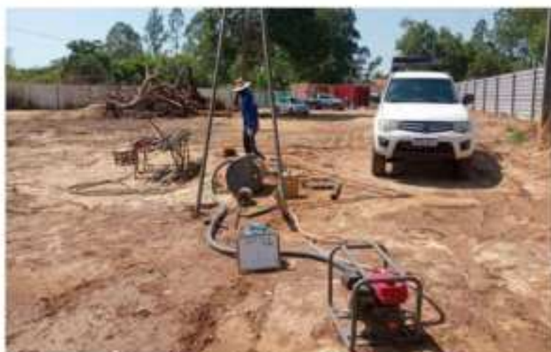
Imagem 02 – Execução do SP1
