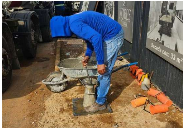
Figura 15: Teste de slump do concreto.
