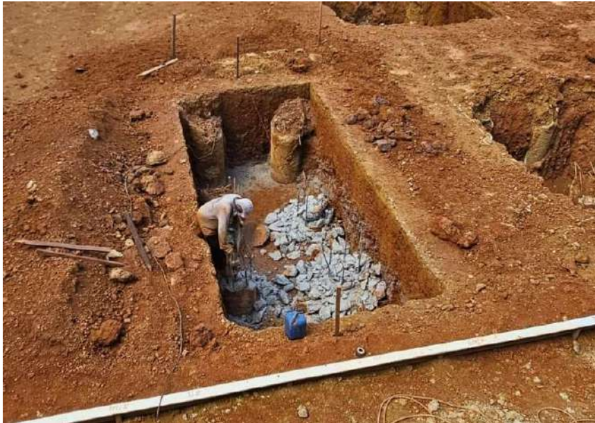
Figura 09: Arrasamento das estacas.
