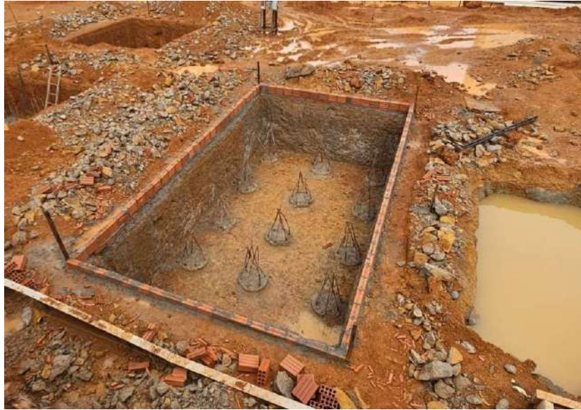
Figura 11: Assentamento de tijolos ao redor do bloco.
