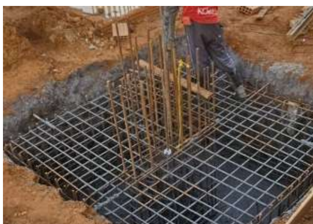
Figura 13: Termopar fixado no bloco.
