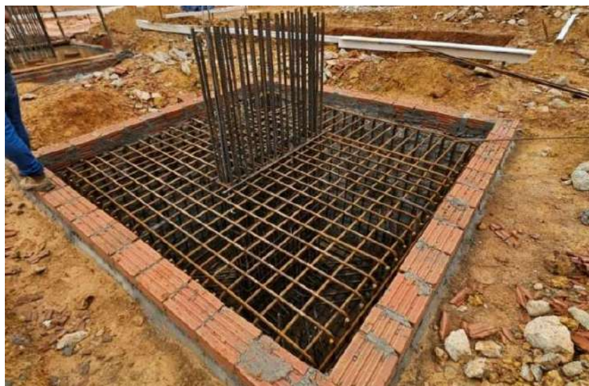
Figura 12: Armação dos blocos.
