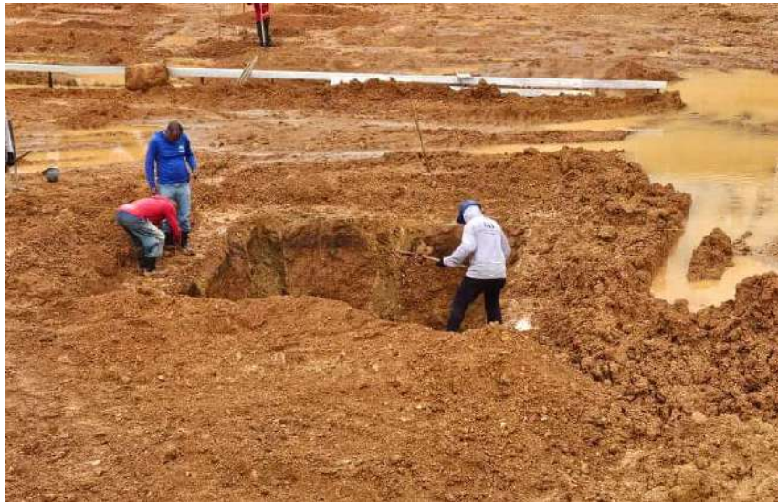
Figura 07: Escavação do bloco.
