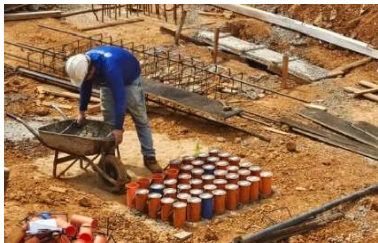
Figura 16: Corpos de prova moldado na obra.
