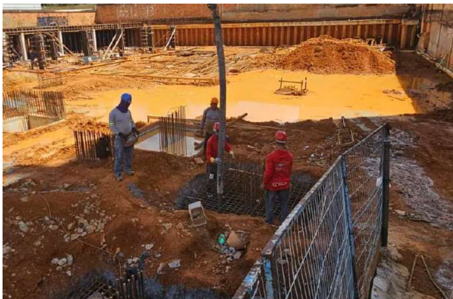
Figura 18: Concretagem do bloco da fundação.
