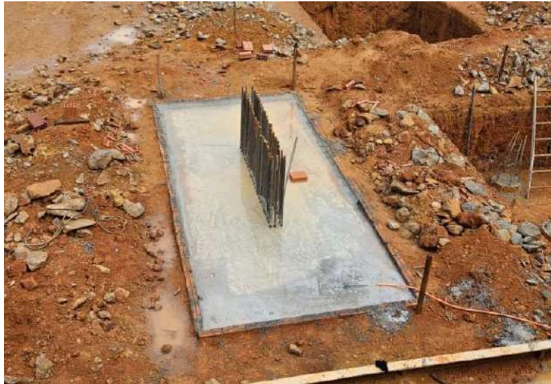
Figura 19: Cura úmida do concreto.
