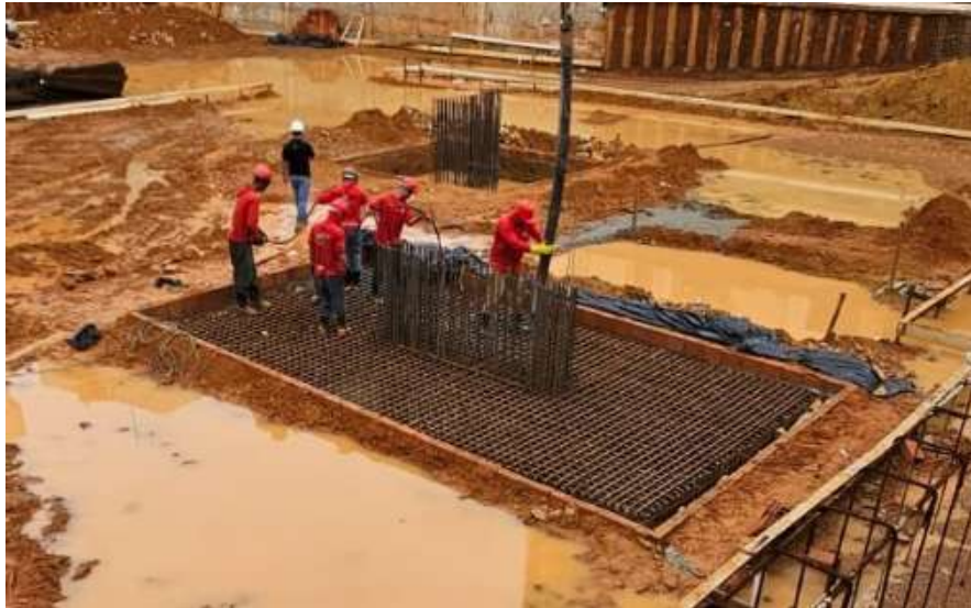
Figura 17: Concretagem do bloco da fundação.
