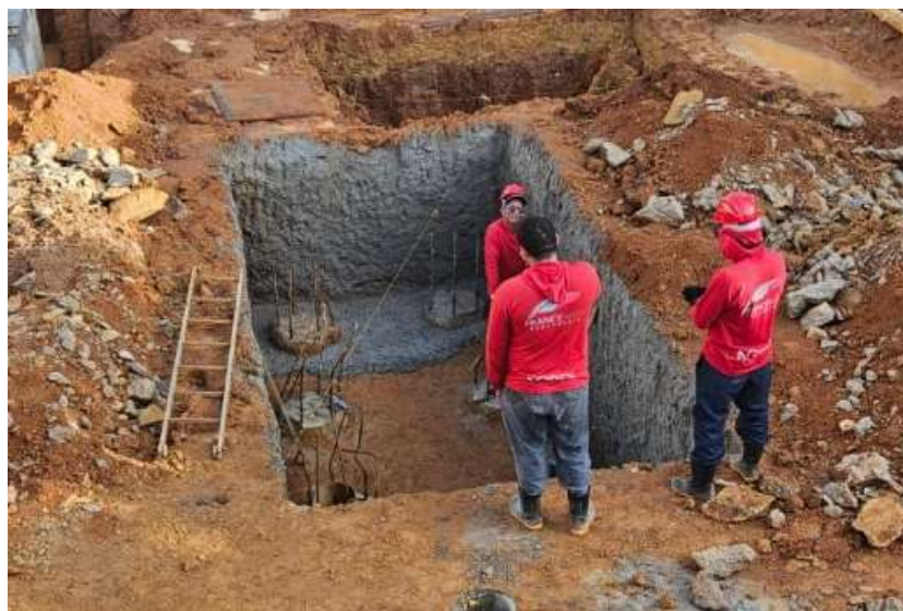
Figura 10: Chapisco nas laterais e concreto magro no fundo do bloco.
