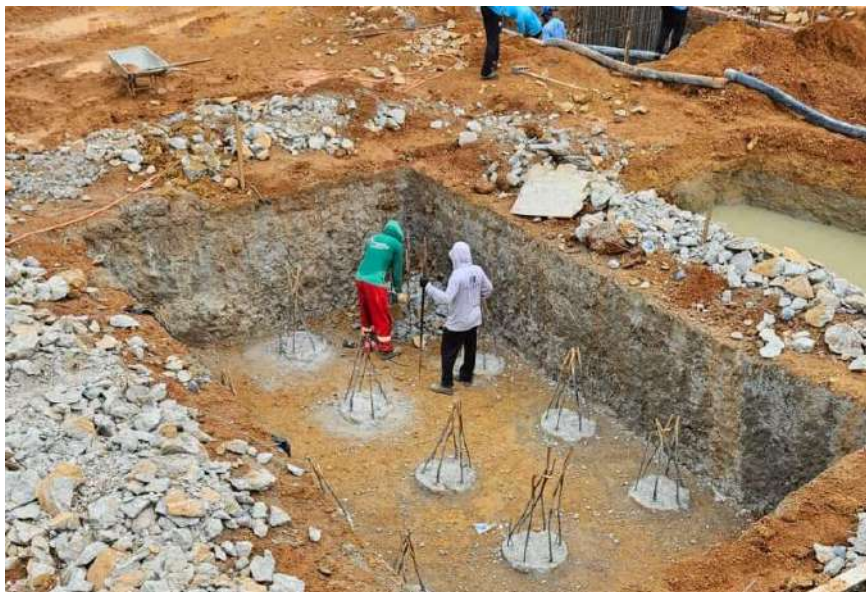
Figura 08: Arrasamento das estacas.
