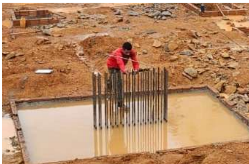
Figura 20: Aferição da temperatura do concreto no interior do bloco.
