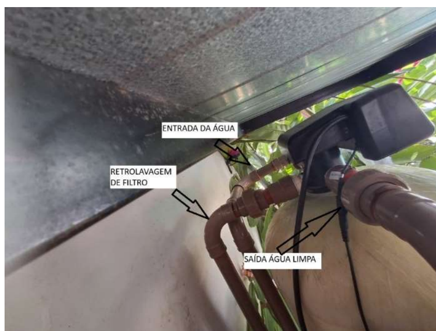
Figura 09 - Distribuição de água na válvula do filtro
