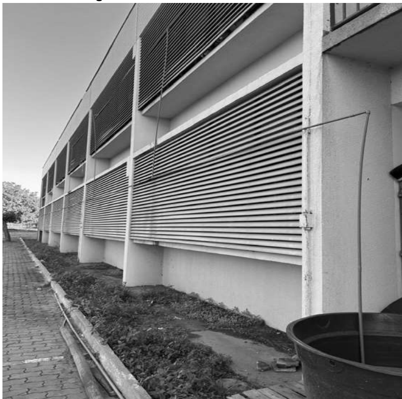
Figura 04 – Fachada lateral do bloco 14 do IFTO.
