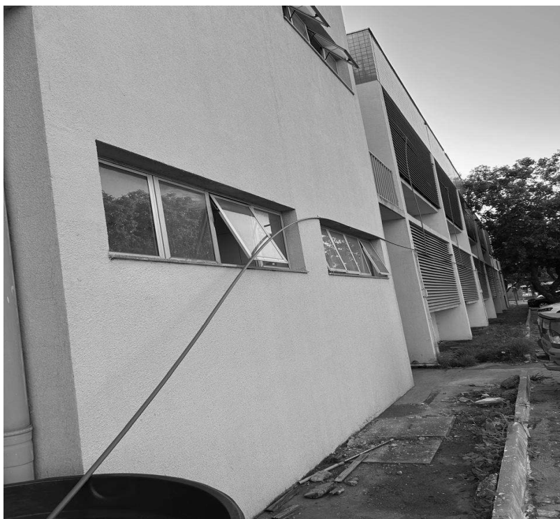
Figura 05 – Instalação da tubulação no bloco 14
