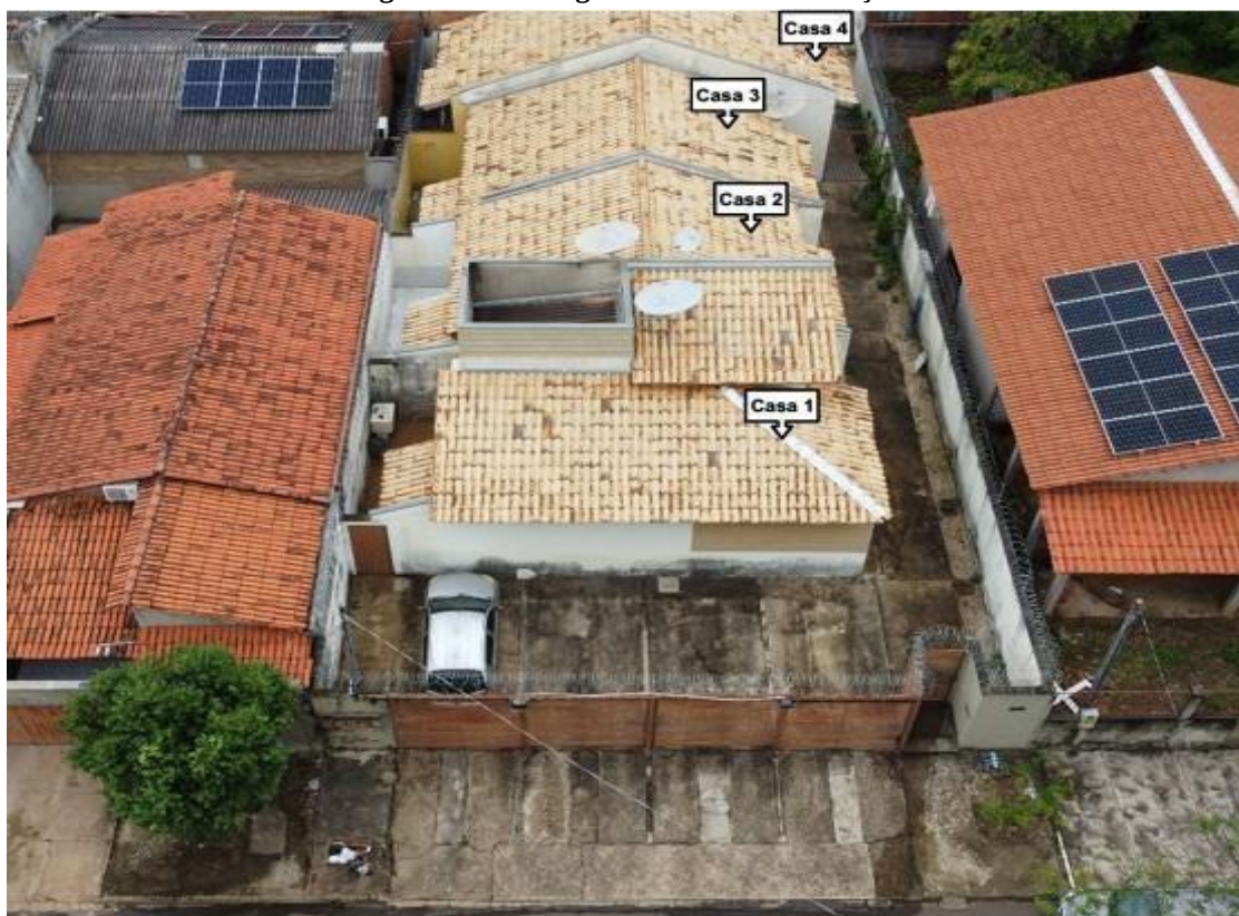
Figura 13 – Vista geral frontal da edificação
