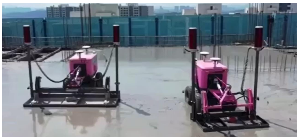
Figura 12 - Nivelamento da laje automatizada
