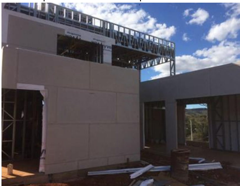
Figura 117 - Plaqueamento externo em painel cimentício em execução
