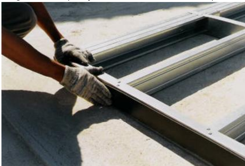
Figura 104 - Aplicação de fita selante na base do painel
