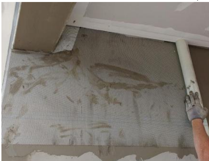
Figura 90 - Placas cimentícias com tratamento de superfície
