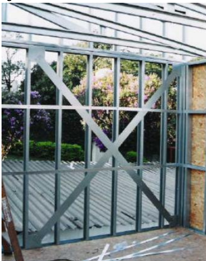
Figura 44 - Painel com contraventamento em “X”
