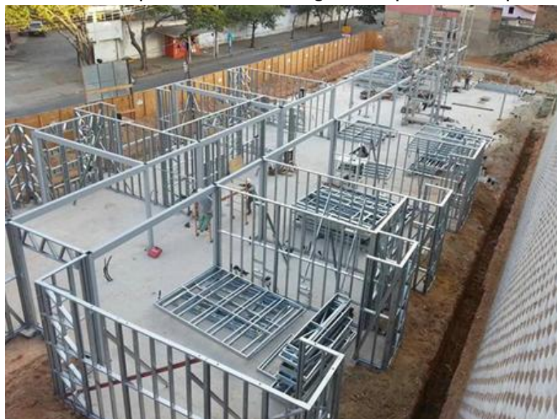
Figura 109 - Sequência de montagem de painéis de paredes
