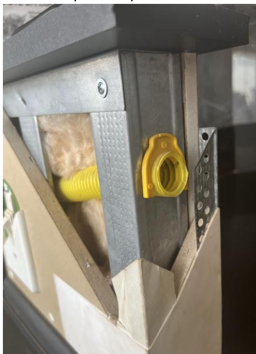
Figura 98 - Trava plástica para eletroduto corrugado
