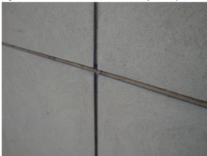
Figura 88 - Placas cimentícias com junta aparente
