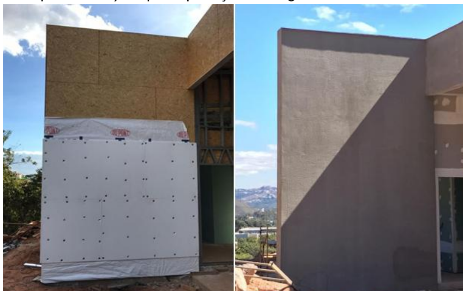
Figura 84 - Trecho de fachada em EIFS, durante a execução (OSB, barreira de vapor e EPS) e após aplicação da argamassa elastomérica
