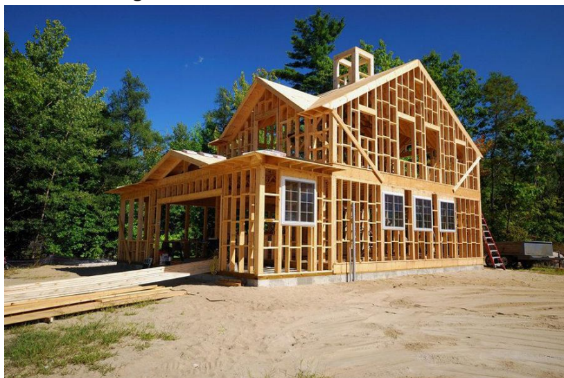
Figura 2 - Sistema Wood Frame
