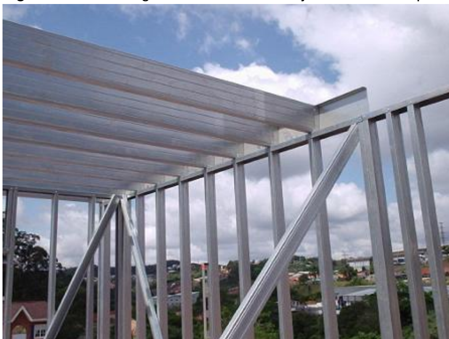
Figura 111 - Montagem de estrutura de laje seca de entepiso
