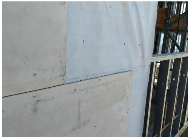
Figura 87 - Placa cimentícia instalada sobre barreira de vapor
