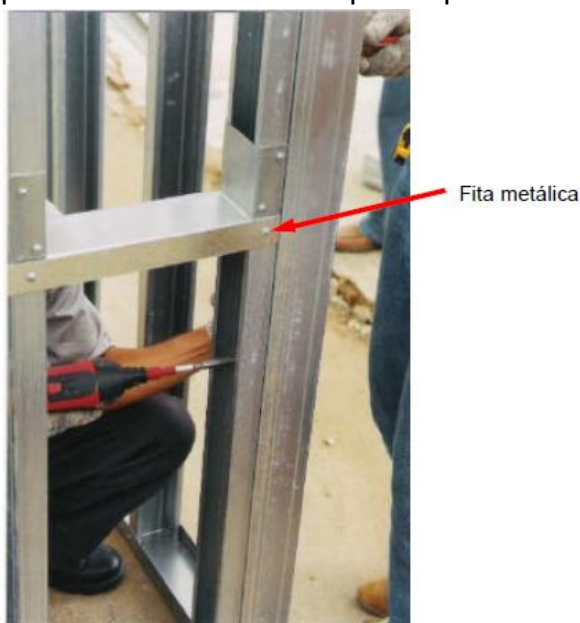
Figura 50 - Bloqueador e fita fixados ao painel para travamento horizontal
