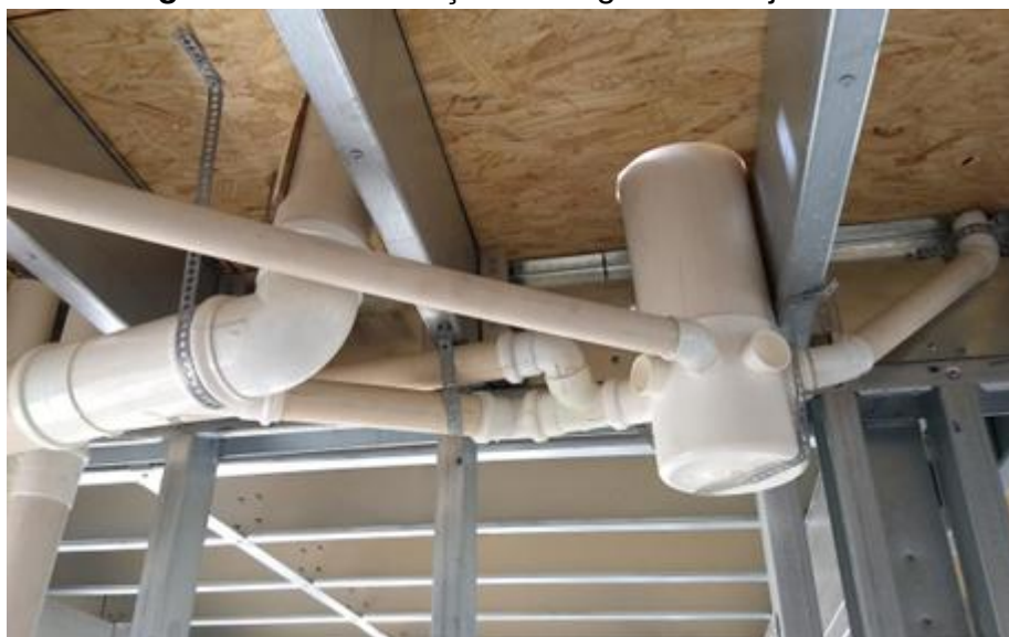
Figura 102 - Tubulação de esgoto sob laje seca
