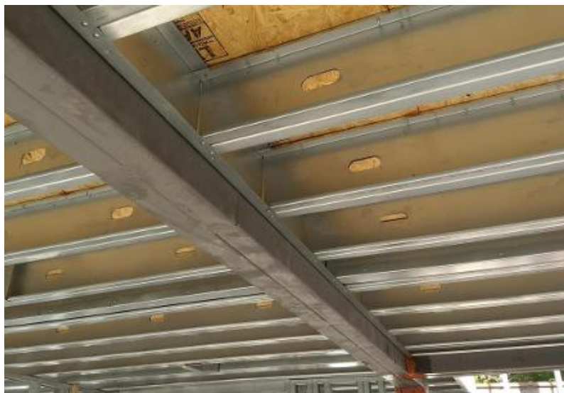
Figura 12 - Viga em aço convencional para estruturação de vão sem apoio em laje de LSF
