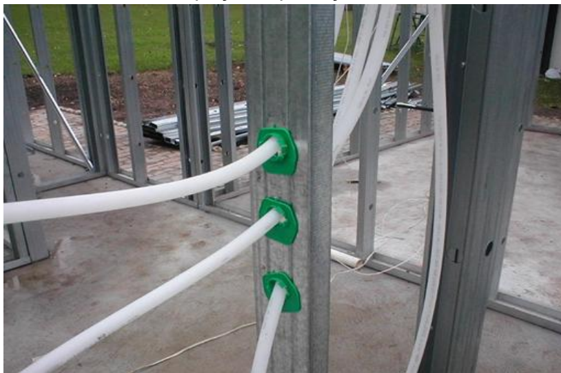
Figura 101 - Passagem de tubulação PEX por furos de serviço em montantes com peça de proteção
