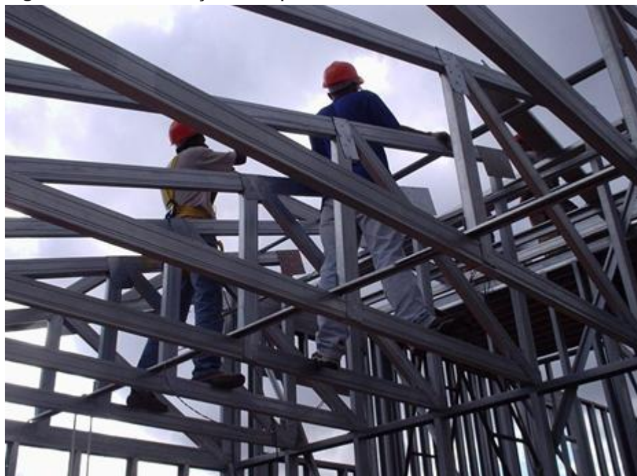
Figura 116 - Instalação de ripas e contraventamentos de telhado
