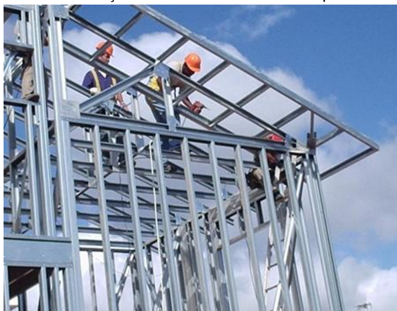
Figura 115 - Instalação de tesouras de telhado e painel de beiral
