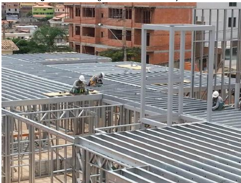
Figura 60 - Montagem de estrutura de laje em LSF
