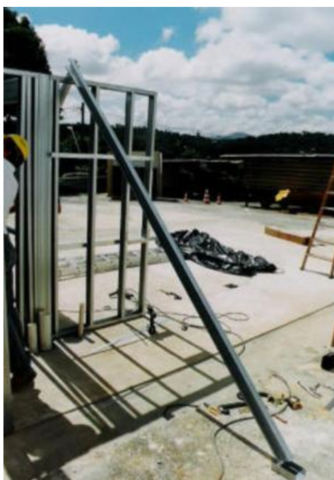
Figura 107 - Painel com mão-francesa de escoramento provisório
