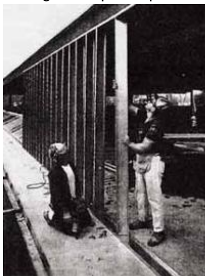
Figura 14 - Montagem do painel pelo método Stick
