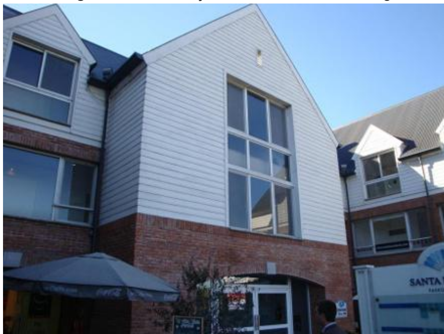
Figura 81 - Edificação com fachada em siding
