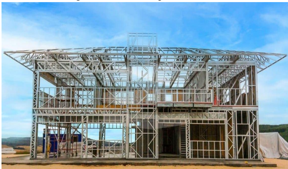
Figura 1 - Sistema Light Steel Frame
