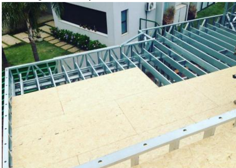
Figura 67 - Laje de cobertura em residência
