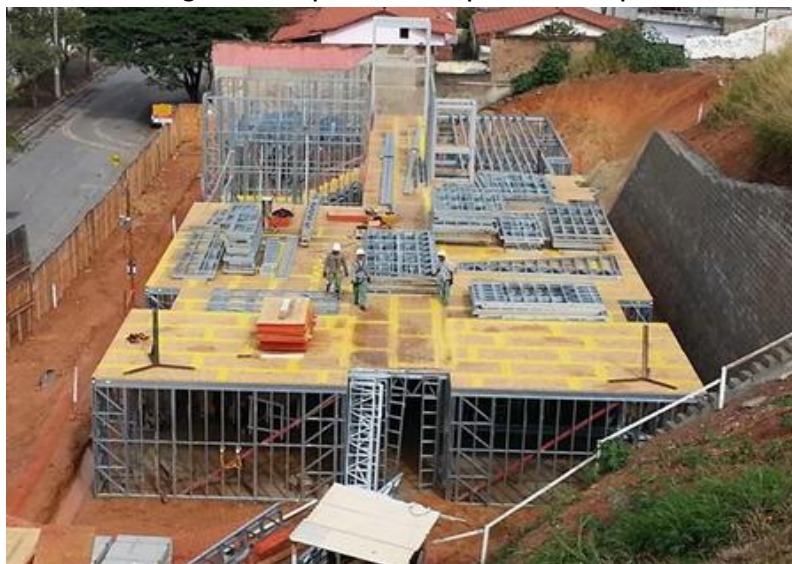
Figura 114 - Montagem dos painéis de parede no pavimento superior
