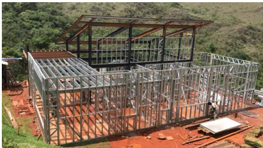
Figura 20 - Residência com estrutura híbrida LSF e aço convencional, Nova Lima, MG
