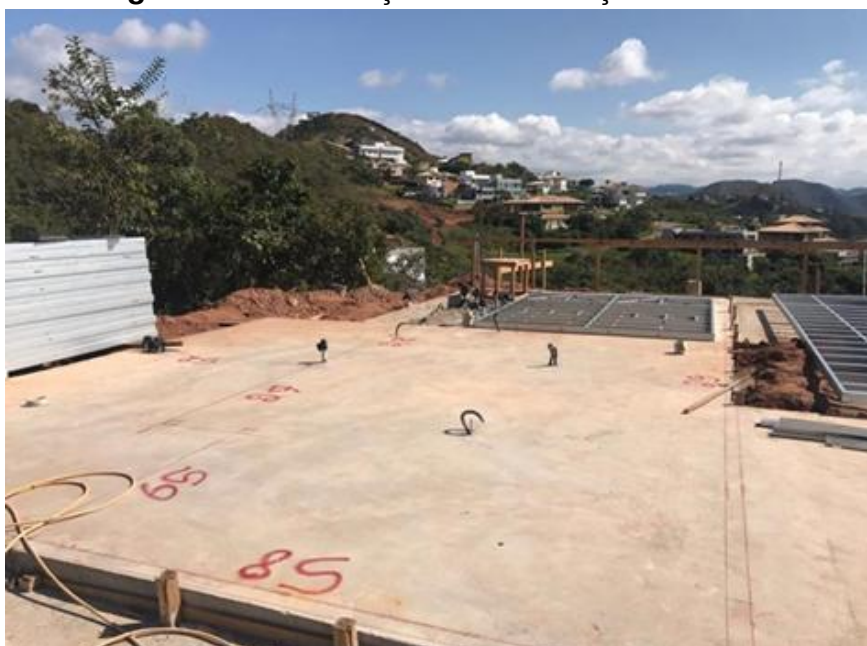
Figura 105 - Fundação com marcação da obra
