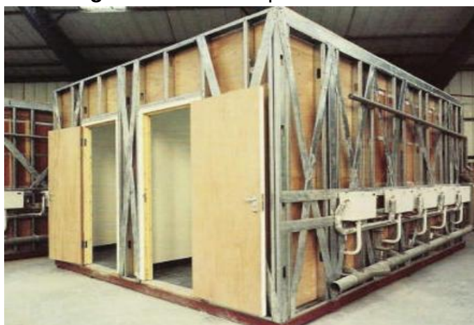
Figura 18 - Módulo para banheiros
