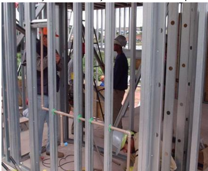
Figura 120 - Execução de instalações hidráulicas em painéis prontos
