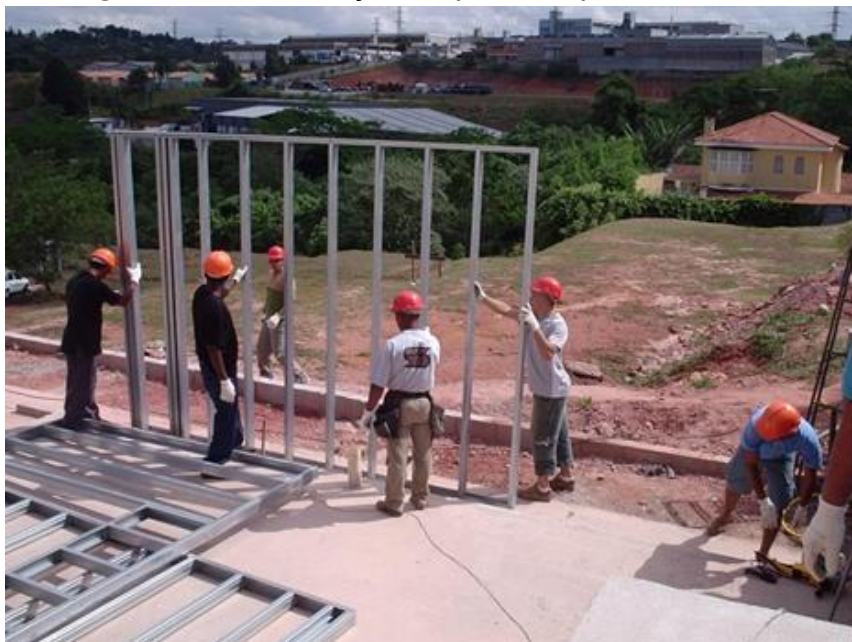
Figura 106 - Instalação do primeiro painel da obra
