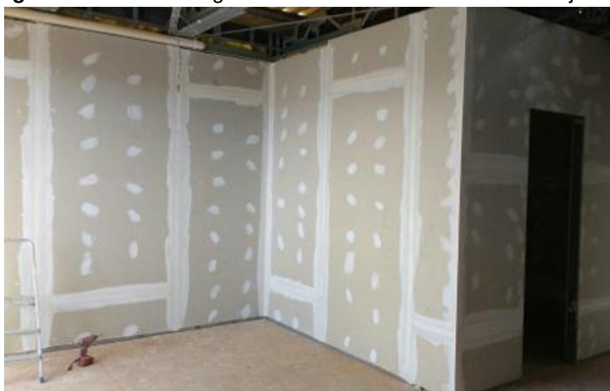
Figura 77 - Placas de gesso cartonado com tratamento de juntas
