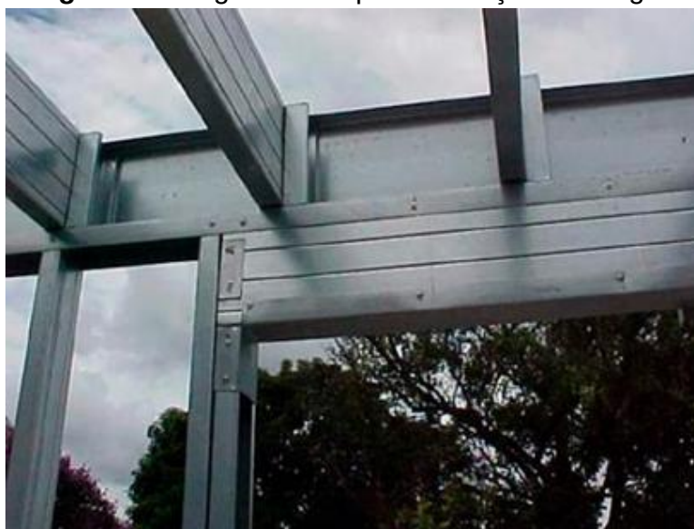
Figura 11 - Viga de LSF para transição de cargas
