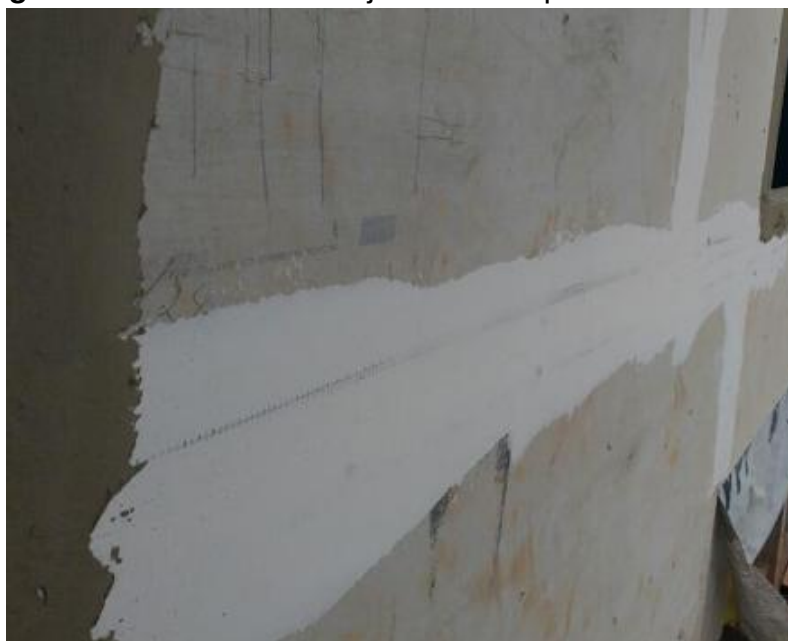
Figura 89 - Tratamento de juntas entre placas cimentícias
