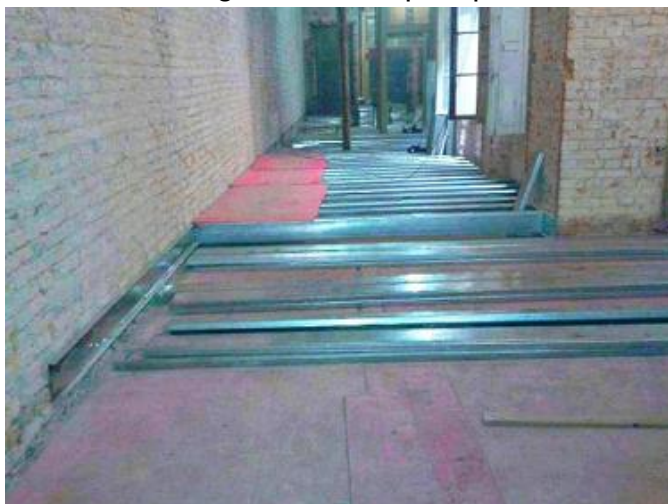
Figura 15 - Montagem de entrepiso pelo método Stick
