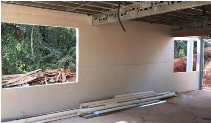
Figura 73 - Parede interna revestida com gesso acartonado
