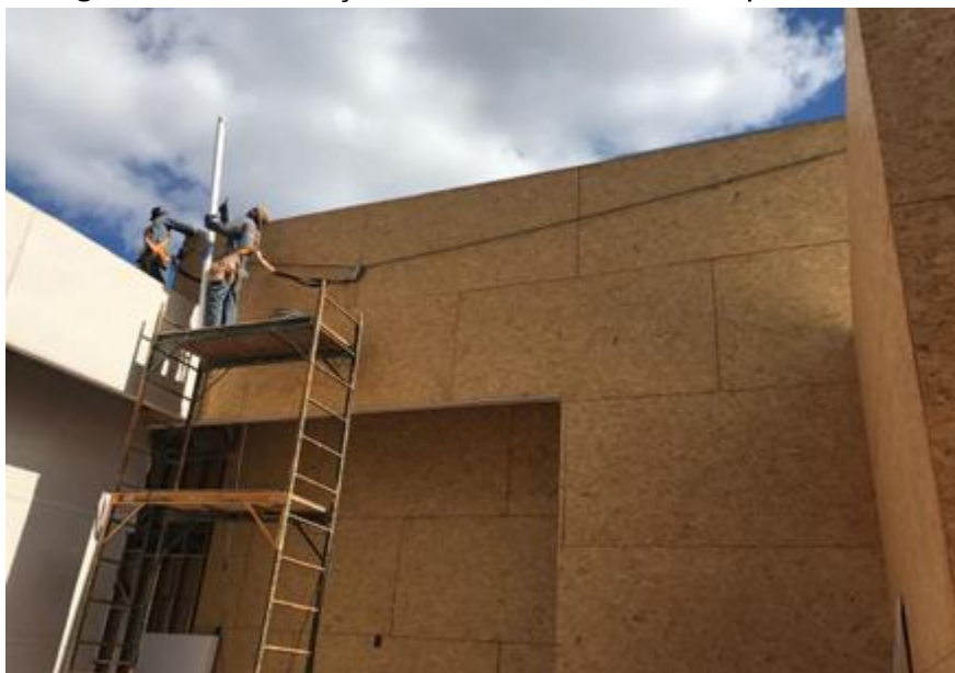
Figura 78 - Edificação com revestimento em placas OSB
