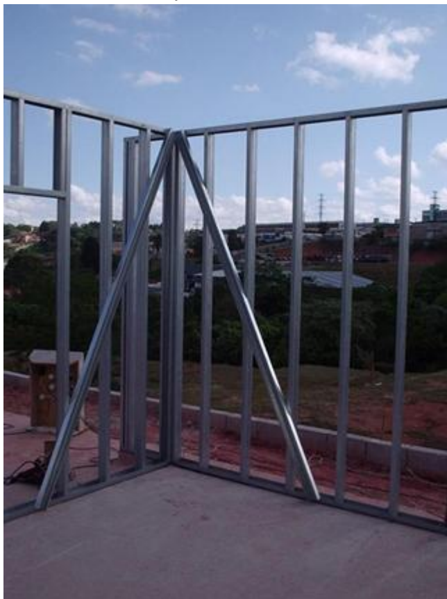
Figura 108 - Painéis de quina fixados entre si e com mão-francesa de escoramento provisório
