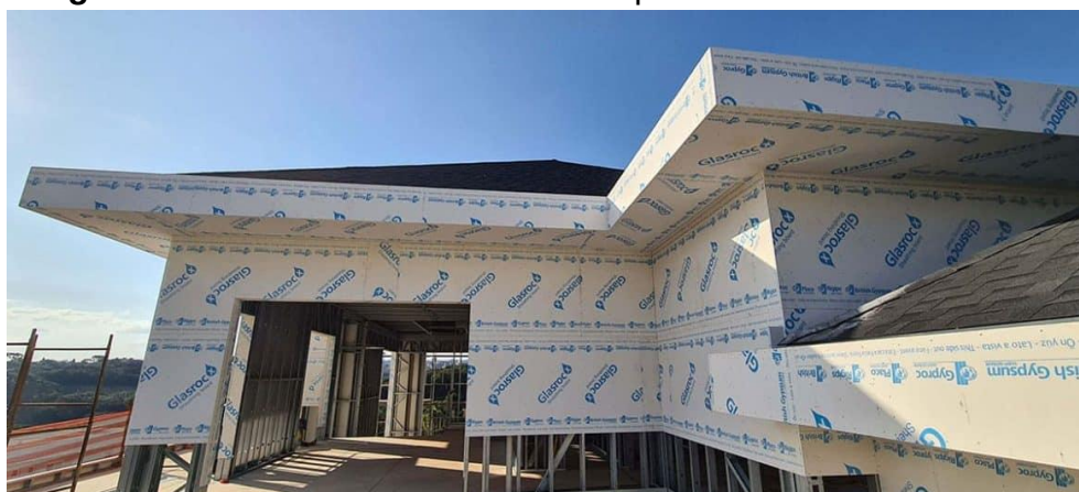
Figura 92 - Fechamento externo com placa GlassMat - Glasroc X
