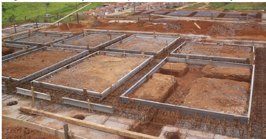
Figura 28 - Fundação com sapatas corridas em execução
