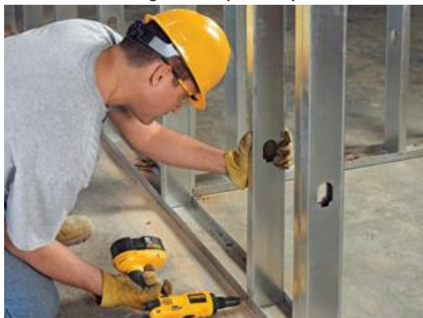
Figura 13 - Montagem de painel pelo método Stick
