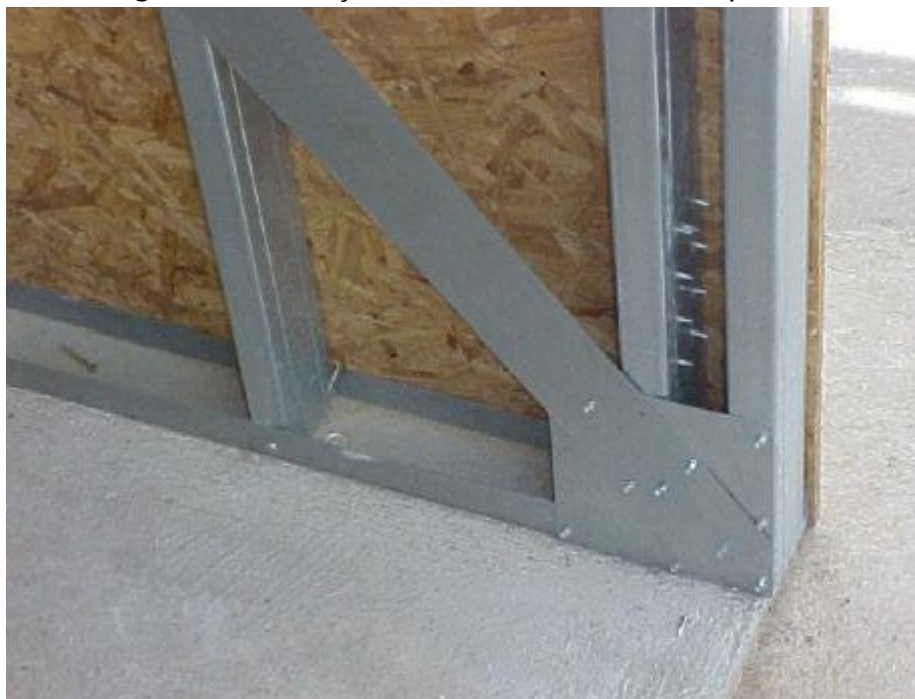
Figura 47 - Fixação das fitas metálicas aos painéis
