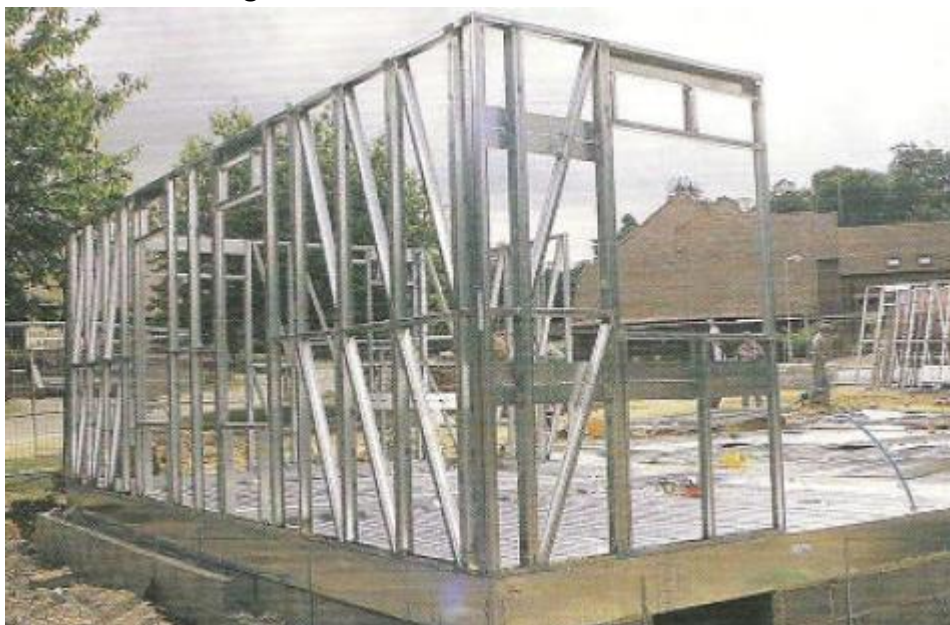
Figura 49 - Contraventamento em "K"
