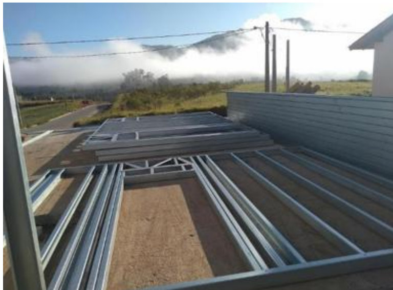
Figura 16 - Painéis prontos para montagem
