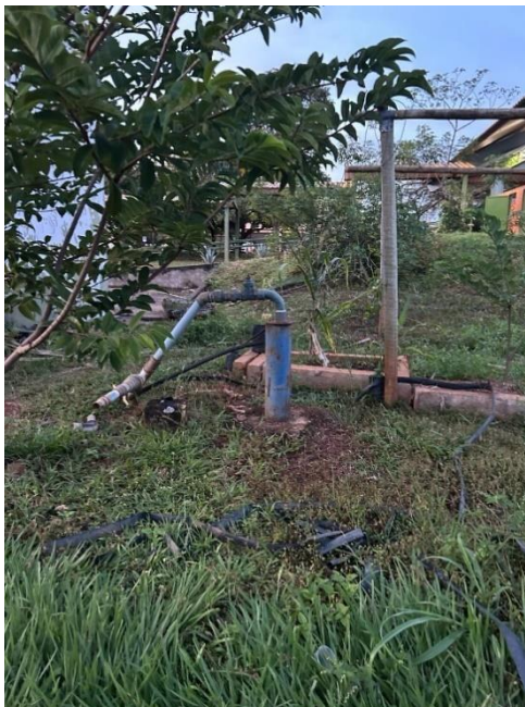
Figura 2 - Poço existente no IFTO- Campus Palmas.
