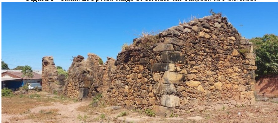
Figura 3 - Ruína EM pedra canga do Rosário em Chapada da Natividade
