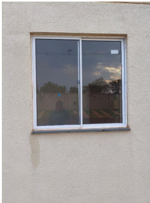
Figura 29 – Assentamento da pingadeira
