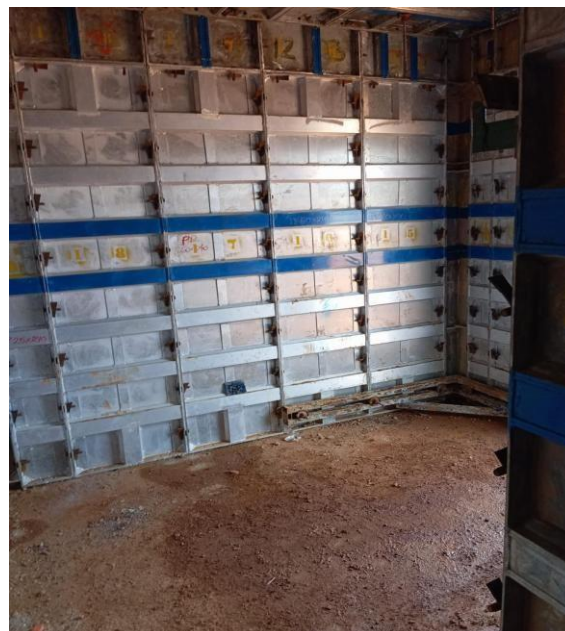
Figura 8 – Fôrma metálica (Tipo FORSA 3)
