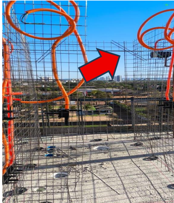
Figura 14 – Reforços em vãos de janelas
