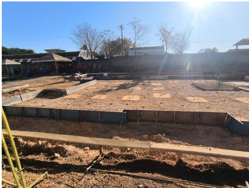
Figura 3 – Fôrmas do radier montadas
