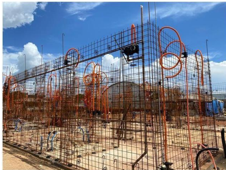
Figura 13 – Montagem de telas e armações
