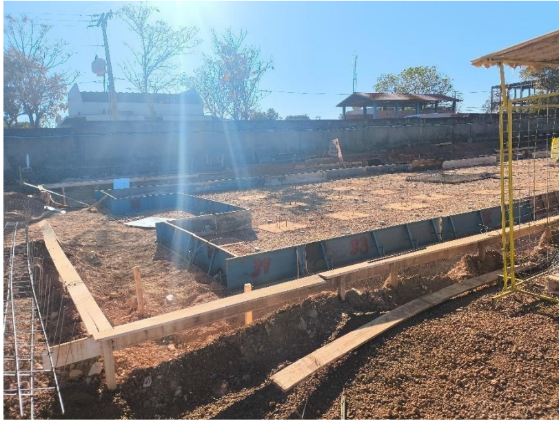
Figura 2 – Montagem de fôrmas do radier
