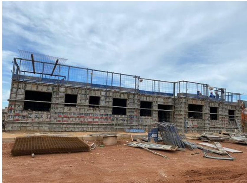
Figura 18 – Fôrmas montadas
