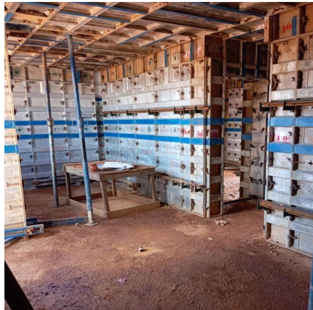
Figura 7 – Fôrma metálica (Tipo FORSA 2)
