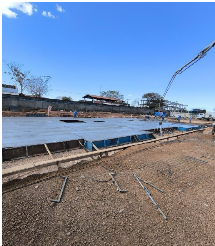
Figura 5 – Concretagem do radier
