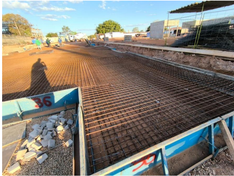
Figura 4 – Instalação de malha no radier
