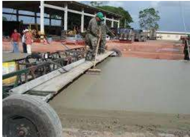
Figura 101 - Ponte de serviço sobre pavimento de concreto em acabamento
