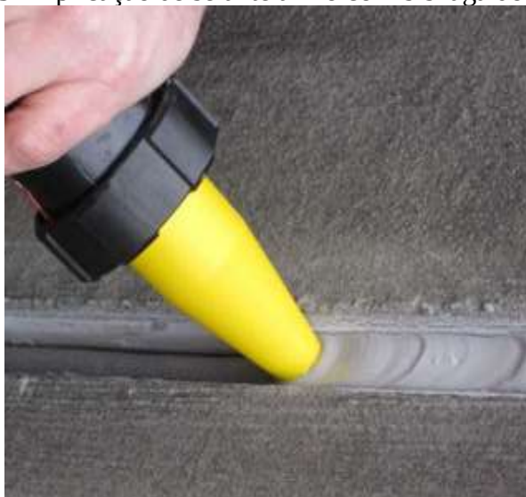
Figura 133 - Aplicação de selante a frio com bisnaga do fabricante
