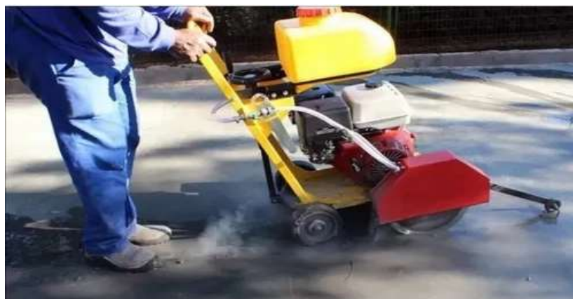
Figura 126 - Corte de juntas longitudinais
