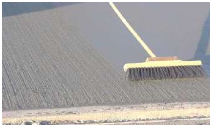
Figura 115 - Detalhe da texturização com vassoura de fios de nylon
