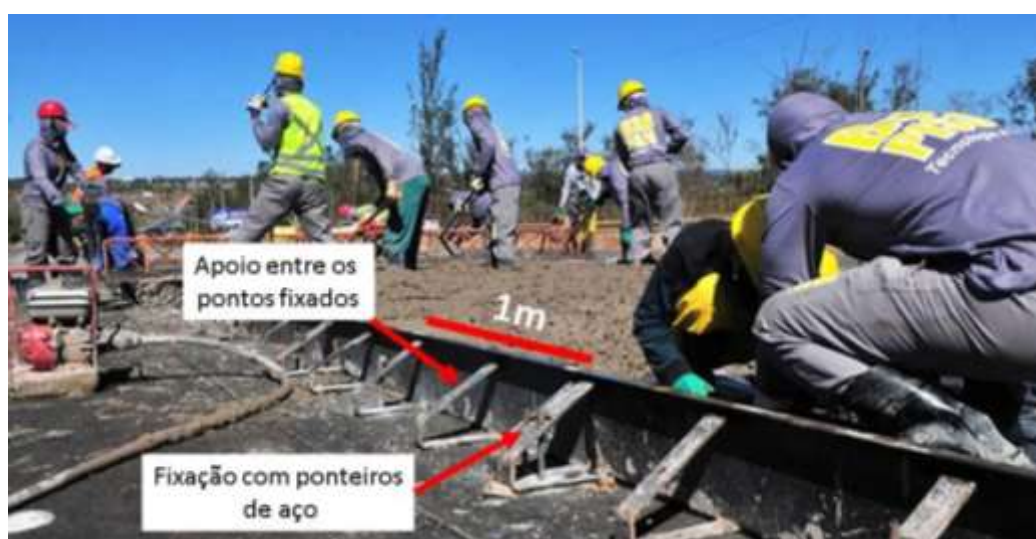
Figura 57 - Fôrmas longitudinais apoiadas e fixadas em toda sua extensão
