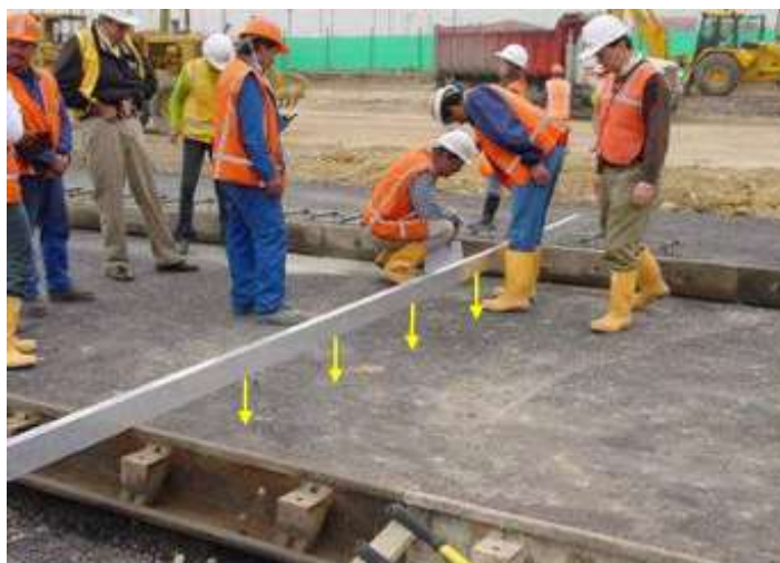
Figura 62 - Verificação do fundo de caixa na execução de pavimento de concreto
