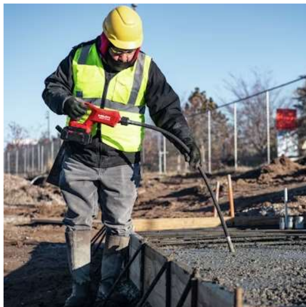
Figura 98 - Adensamento do concreto com vibrador de imersão
