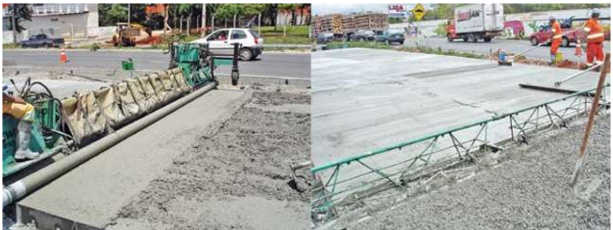
Figura 104 - Regularização da superfície longitudinal com régua vibratória
