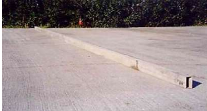
Figura 105 - Conferência da regularidade longitudinal com régua de 3 m
