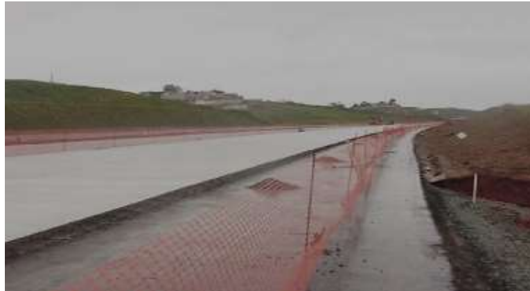
Figura 125 - Pista interditada cercada com telas
