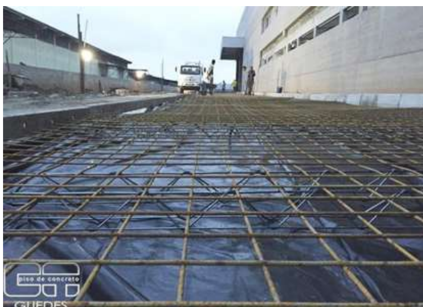
Figura 23 - Armadura de pavimento estruturalmente armado
