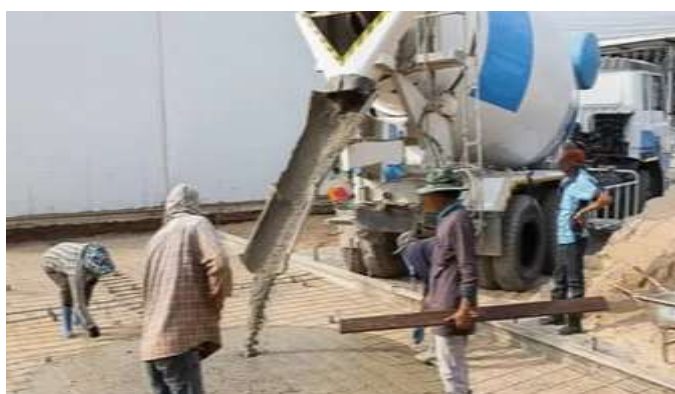
Figura 90 - Lançamento do concreto sobre base prepara com tela soldada.
