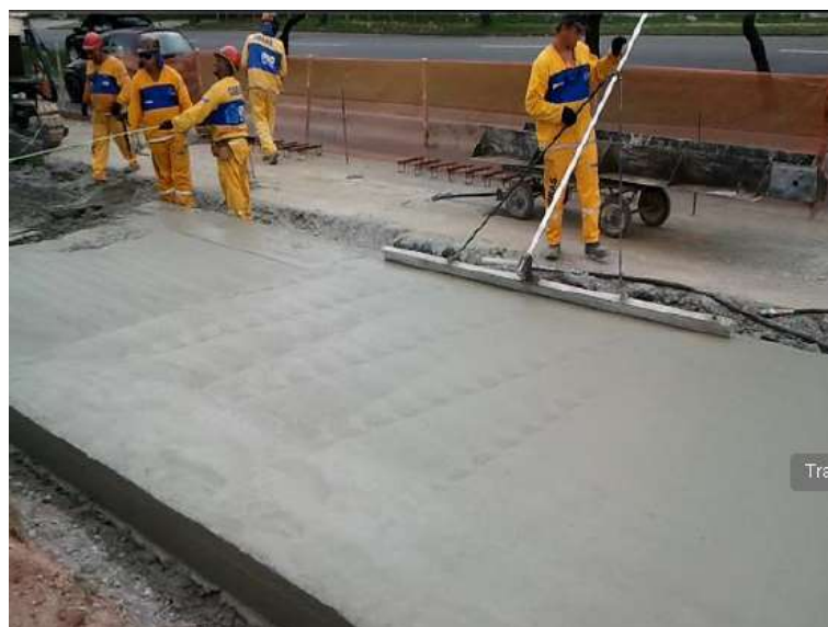
Figura 108 - Correção das saliências com rodo de corte
