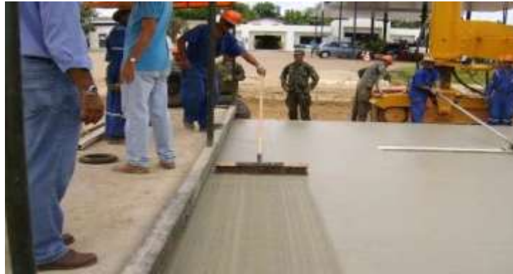
Figura 114 - Texturização com vassoura de fio de nylon sobre plataforma de apoio
