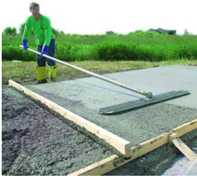
Figura 109 - Aplicação do float para corrigir a porosidade do concreto
