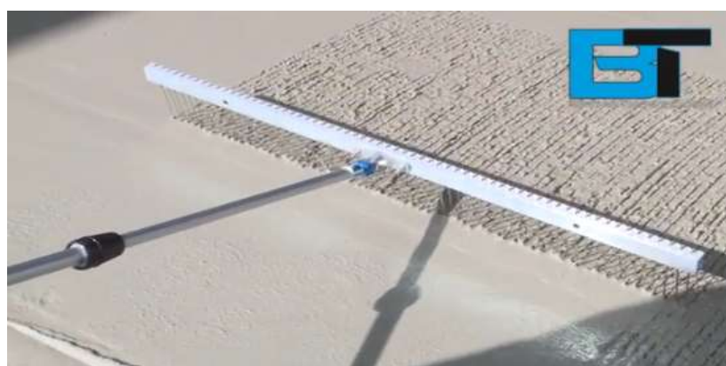
Figura 116 - Acabamento do pavimento com pente metálico
