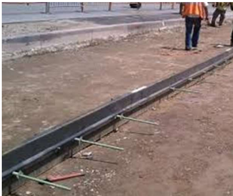
Figura 37 - Fôrmas metálicas longitudinais com barras de ligação
