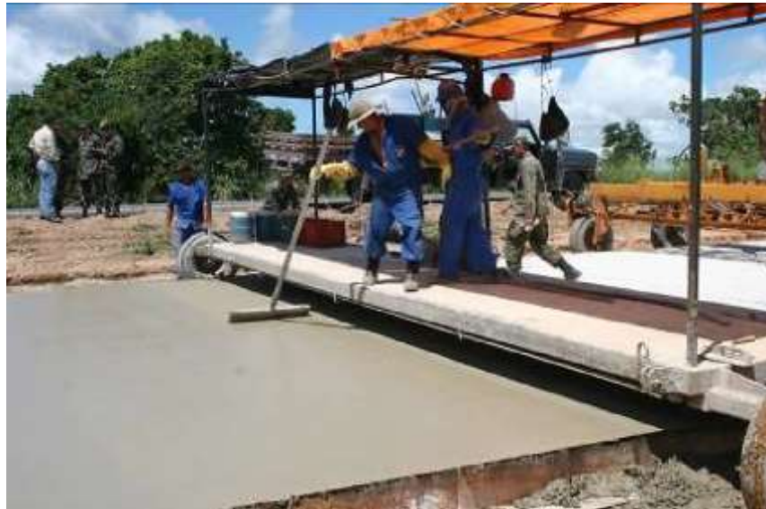
Figura 46 - Ponte de serviço para pavimentação
