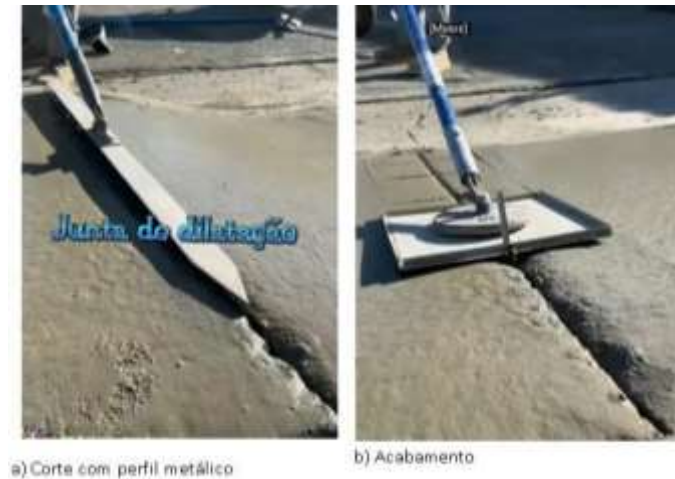
Figura 103 - Execução e acabamento da junta moldada com perfil
