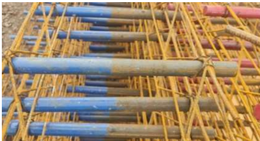
Figura 82 - Barras de transferência dispostas em espaçador treliçado
