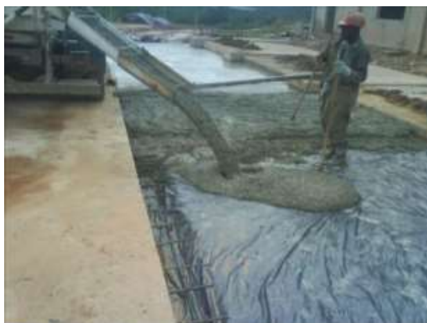
Figura 89 - Lançamento do concreto lateralmente à faixa
