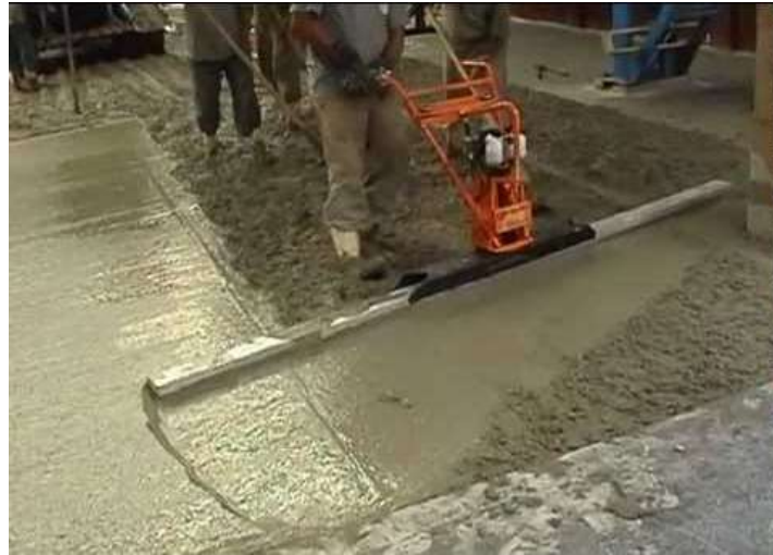
Figura 99 - Adensamento do concreto com régua vibratória
