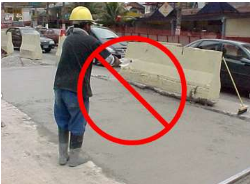
Figura 117 - Prática proibida durante o acabamento do concreto
