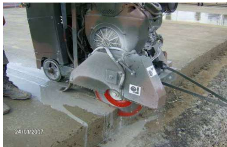
Figura 129 - Corte de junta com serra de disco diamantado
