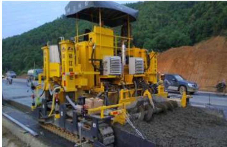
Figura 97 - Espalhamento de concreto pelo equipamento de fôrmas deslizantes
