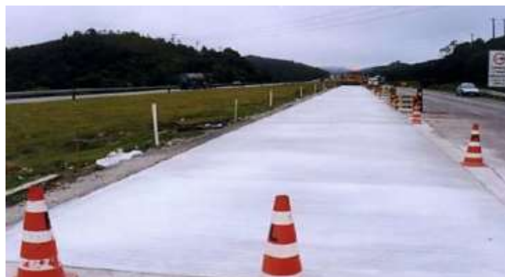
Figura 124 - Trânsito impedido sinalizado com cones
