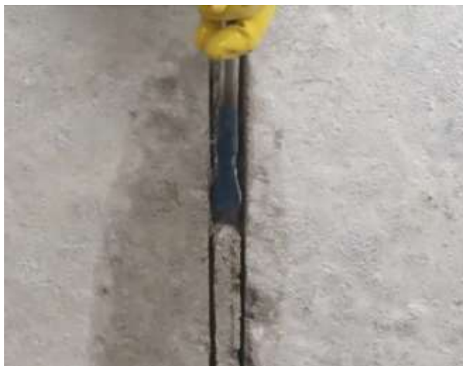
Figura 131 - Limpeza de junta com ferramenta de ponta de cinzel
