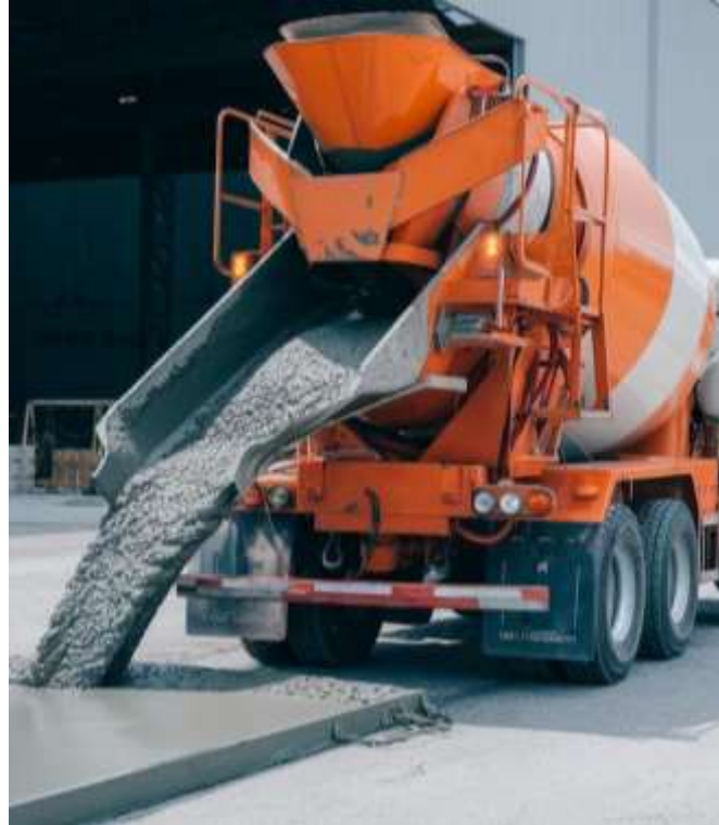
Figura 91- Lançamento de concreto com o veículo de ré
