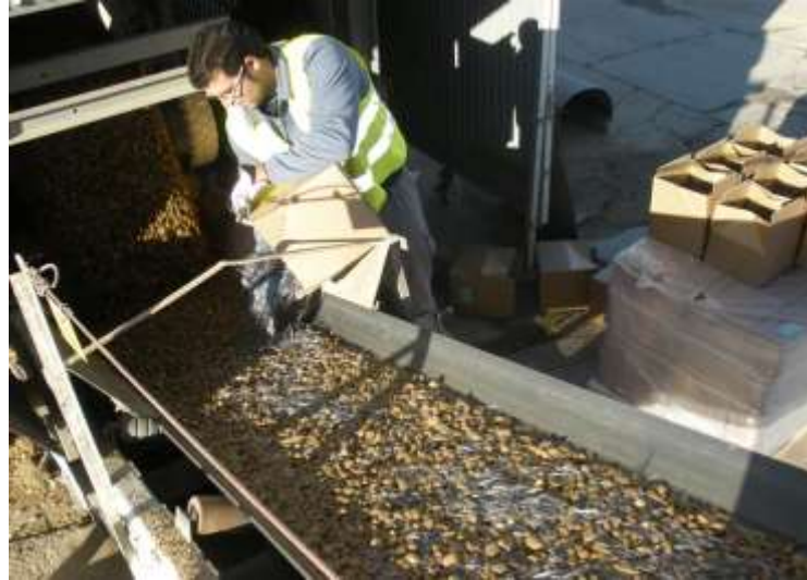
Figura 68 - Adição de macrofibras na esteira junto aos agregados
