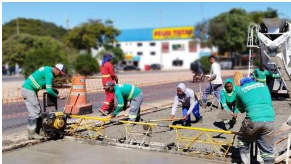
Figura 96 - Espalhamento do concreto utilizando enxadadas, compactação
