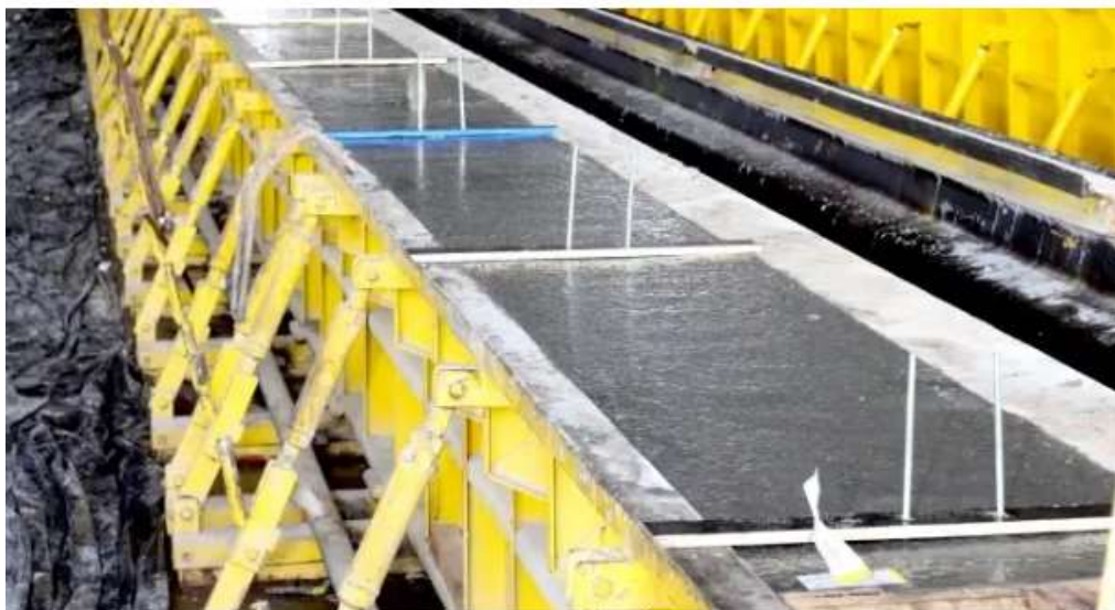
Figura 9 - Fabricação de placas de concreto pré-moldadas
