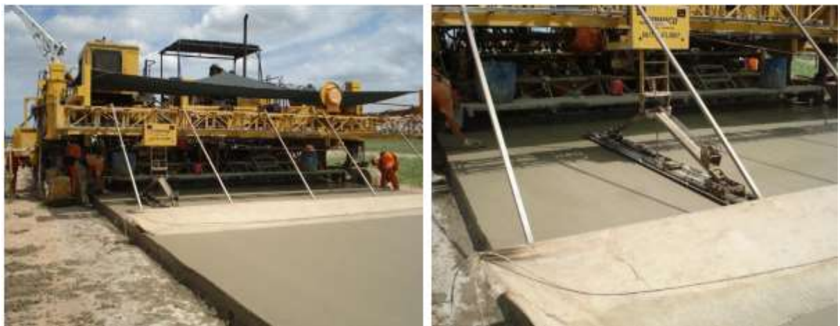
Figura 113 - Aplicação da faixa de lona no sentido longitudinal do pavimento
