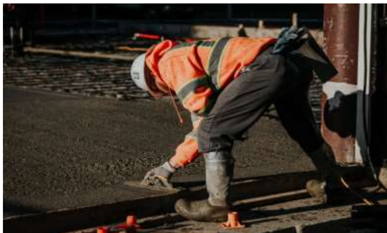
Figura 111 - Acabamento na superfície próxima às fôrmas com desempenadeira de cabo curto
