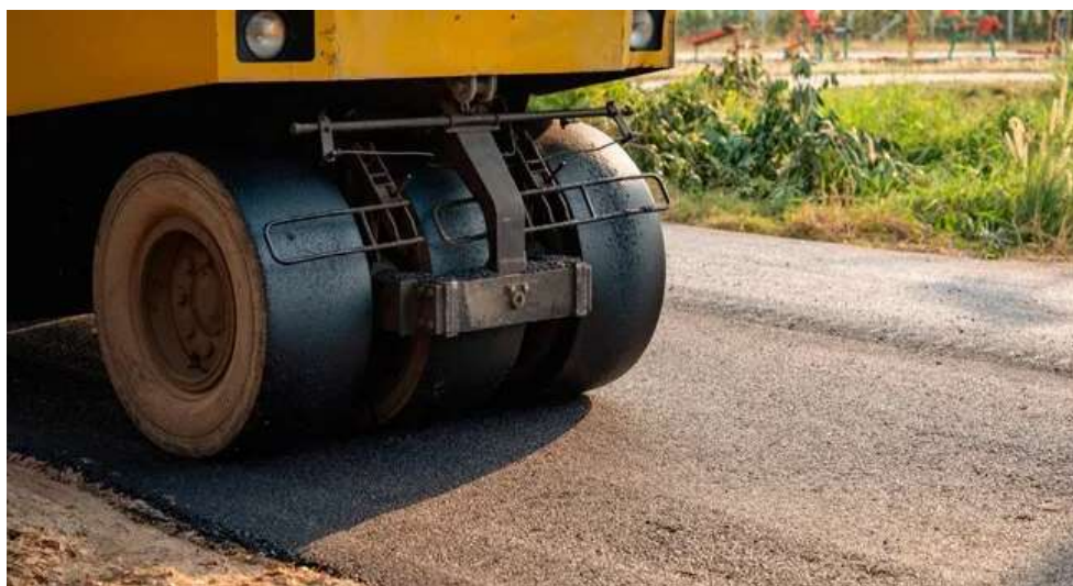
Figura 13 - Compactação do concreto com rolo
