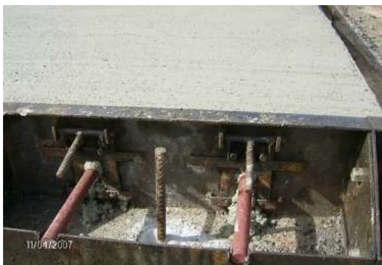
Figura 80 - Detalhe da instalação da fôrma metálica na junta de construção transversal
