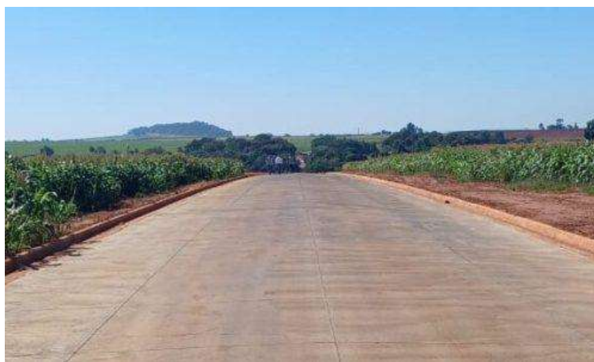
Figura 32 - Vias rurais em pavimento de concreto.
