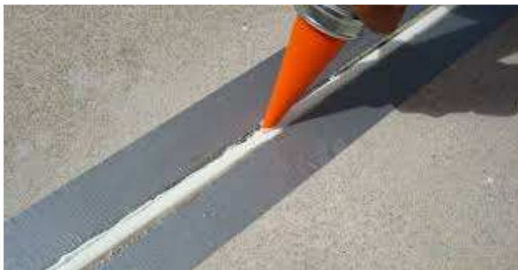
Figura 134 - Utilização de fita crepe de ambos os lados da junta
