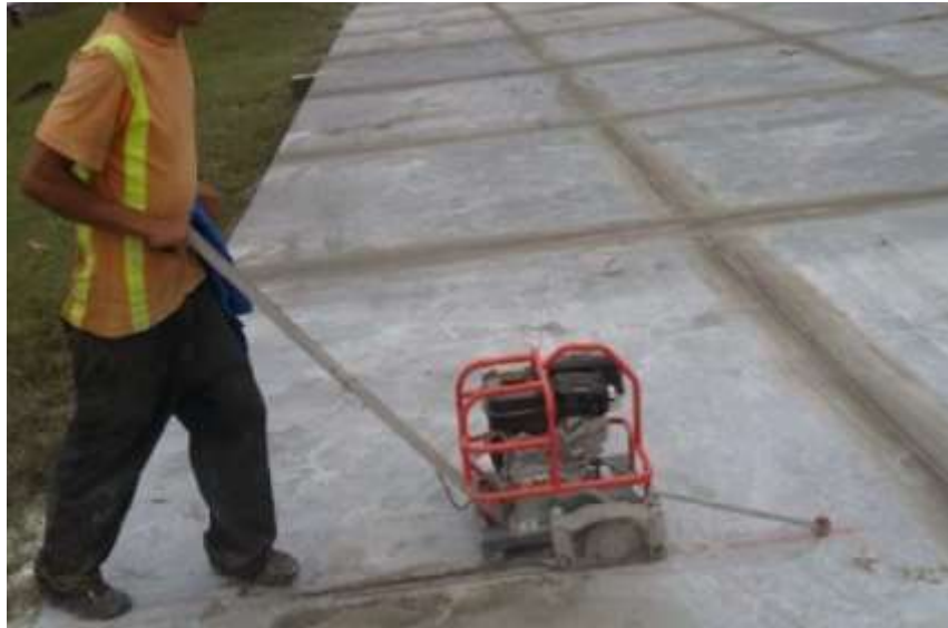
Figura 128 - Corte de junta no sentido transversal à pista
