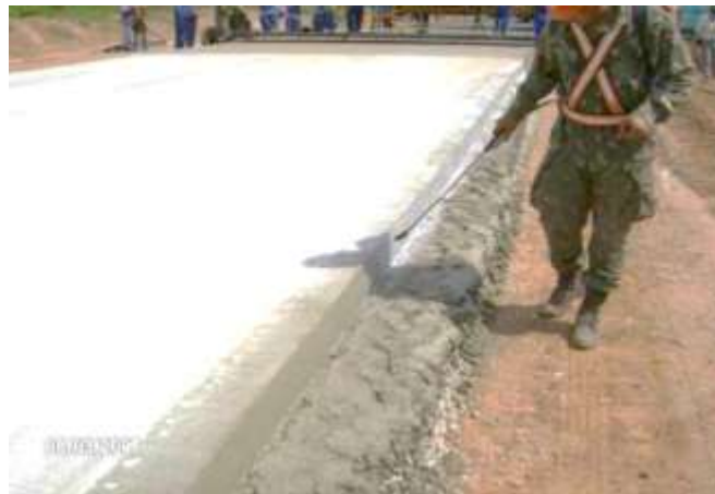
Figura 123 - Processo de proteção das faces laterais das placas de concreto com cura química
