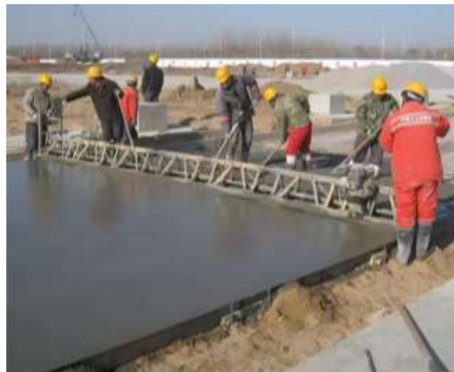
Figura 100 - Adensamento e nivelamento do concreto com treliça vibratória
