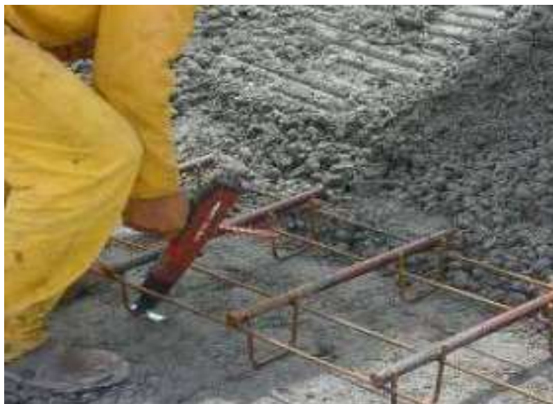
Figura 77 - Fixação do espaçador treliçado ao solo
