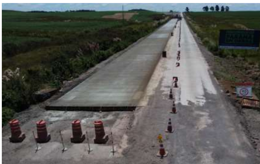
Figura 14 - Restauração em concreto ( whitetopping ) da PRC-280
