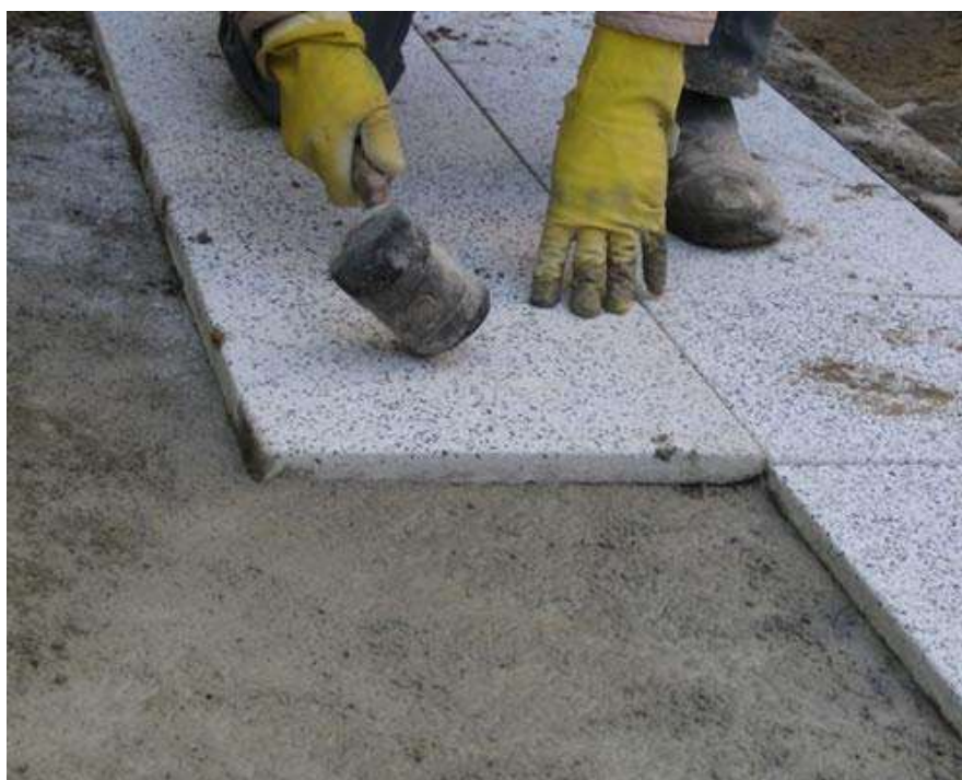
Figura 10 - Assentamento de placas de concreto pré-moldadas em calçadas
