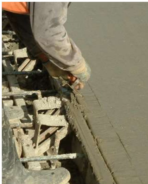
Figura 110 - Aplicação da desempenadeira metálica de borda e cabo curto para
