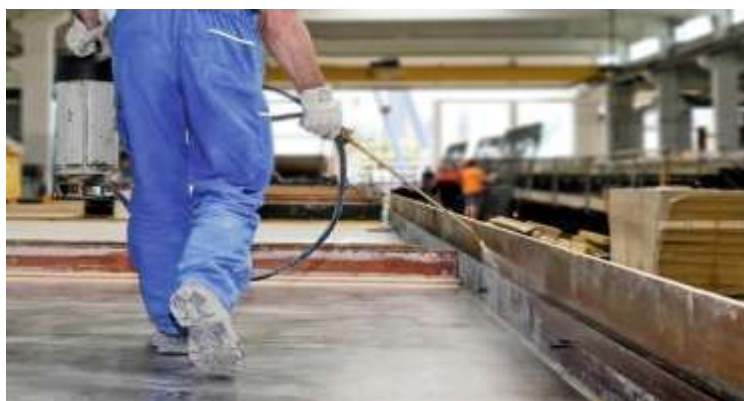
Figura 64 - Aplicação de desmoldante por aspersão
