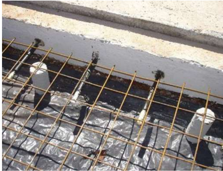
Figura 87 - Tela soldada colocada sobre as barras de transferência ao
