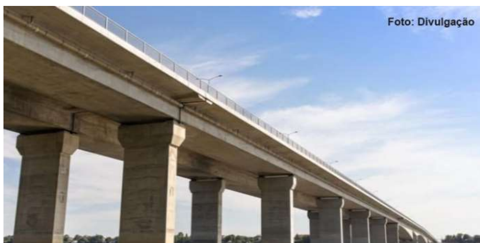
Figura 15 - Ponte na qual foi utilizado o pavimento sobre-laje
