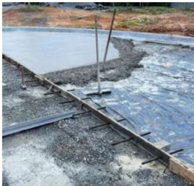
Figura 73 - Juntas de construção com fôrmas de contenção dividindo as duas pistas
