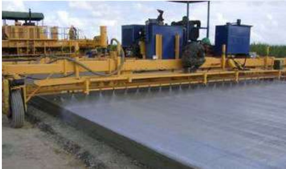
Figura 119 - Aplicação do composto químico com a própria máquina pavimentadora.
