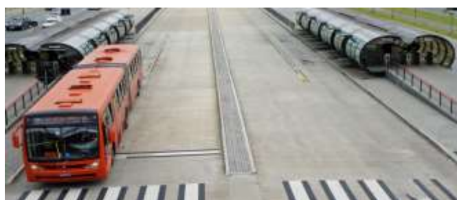
Figura 28 - Emprego de pavimento de concreto em corredor de ônibus.
