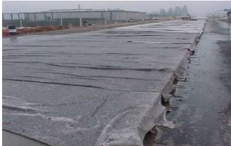
Figura 121 - Execução de cura úmida com manta geotêxtil
