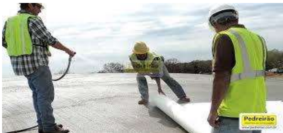
Figura 122 - Aplicação de composto químico e cobertura com lona plástica
