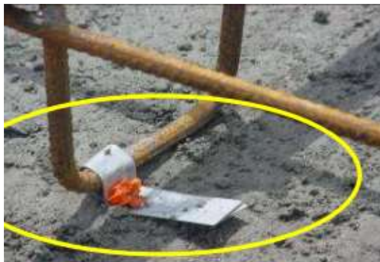
Figura 78 - Espaçador treliçado fixado ao solo
