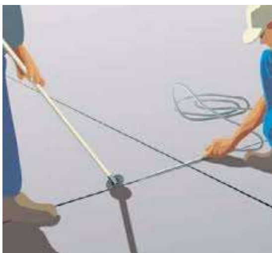
Figura 132 - Colocação de corpo de apoio no fundo do reservatório do selante
