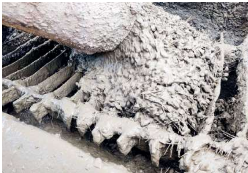
Figura 94 - Aspecto do concreto reforçado com fibras no momento de seu lançamento
