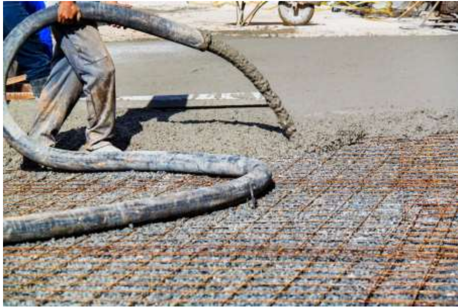
Figura 93 - Lançamento de concreto com bomba estacionária
