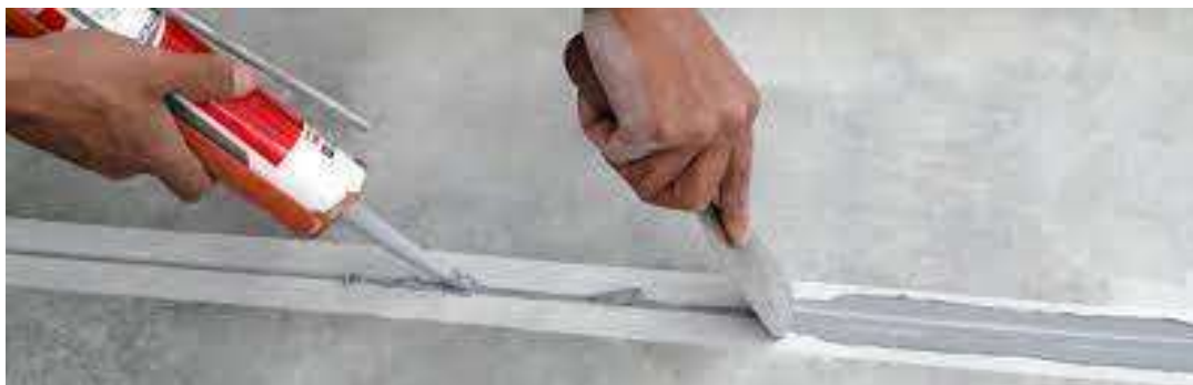
Figura 135 - Retirada do excesso de selante com espátula
