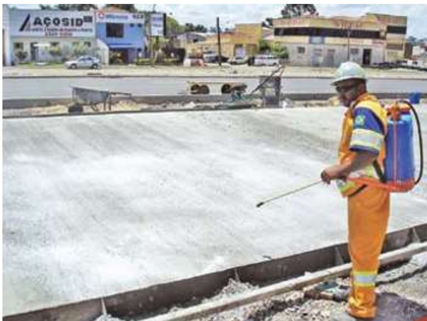
Figura 118 - Aplicação do composto químico manualmente
