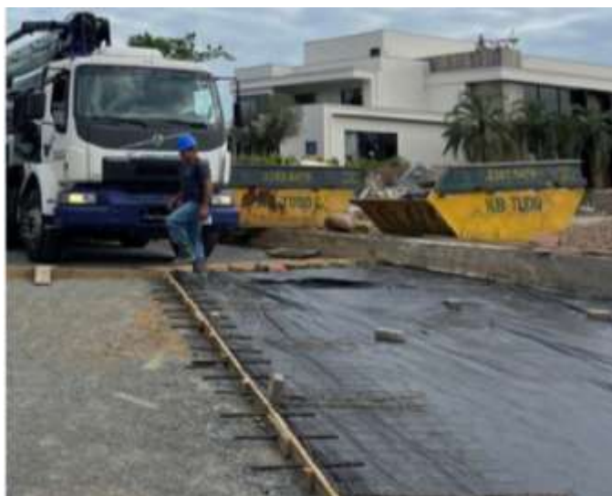
Figura 63 - Sub-base coberta com lona antes da concretagem
