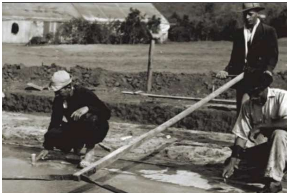
Figura 6 - Obras de construção da Faixa de Gravataí no RS, em 1933
