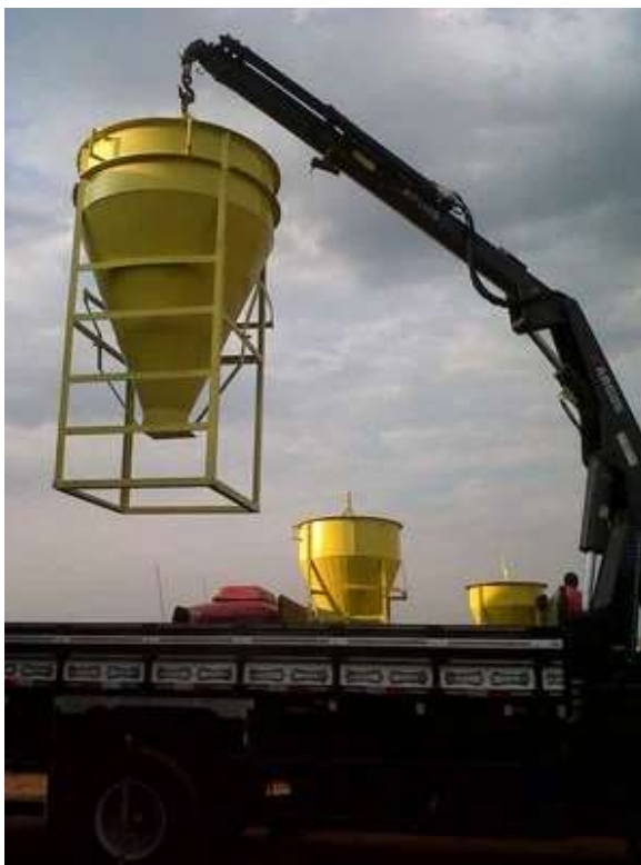
Figura 38 - Caçamba para distribuição de concreto
