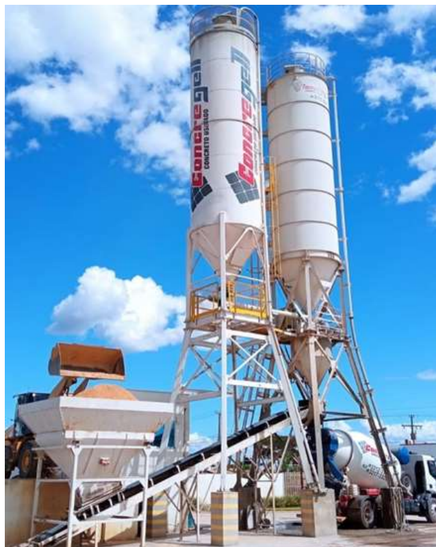
Figura 67 - Concreto pré-misturado fora da obra
