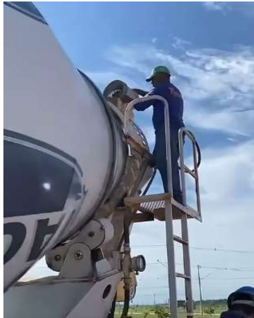
Figura 69 - Adição de macrofibras no caminhão betoneira
