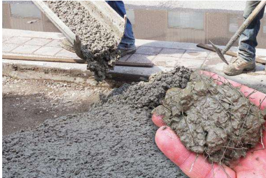
Figura 95 - Detalhe do Concreto Reforçado com Fibras ao ser lançado na sub-base
