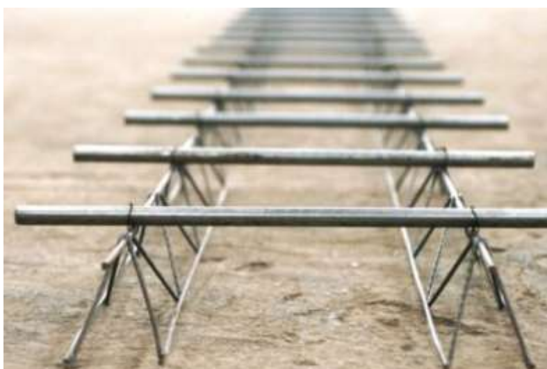
Figura 76 - Espaçador treliçado para distribuição uniforme das barras de ligação
