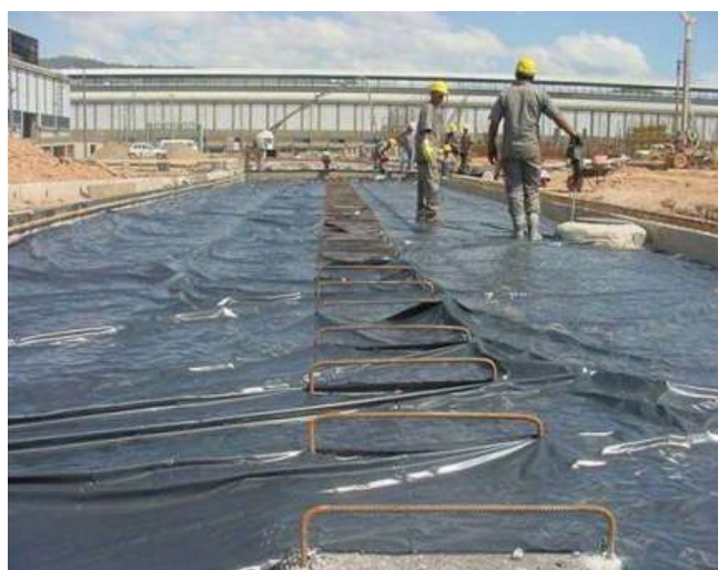
Figura 74 -Barras de ligação "chumbadas" no centro do pavimento antes da concretagem.
