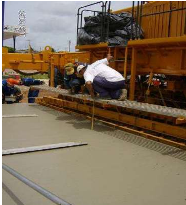
Figura 106 - Medida da placa de concreto em um ponto no centro da placa
