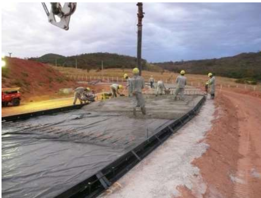
Figura 11 - Execução de pavimento de concreto moldado in loco
