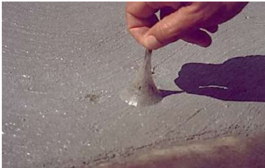
Figura 120 - Detalhe do produto de cura química bem aplicado
