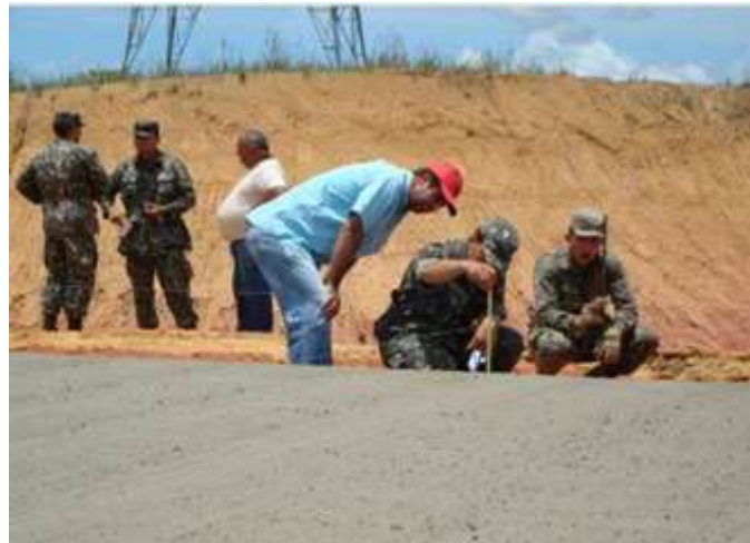
Figura 107 - Medida da placa de concreto na lateral, junto à fôrma
