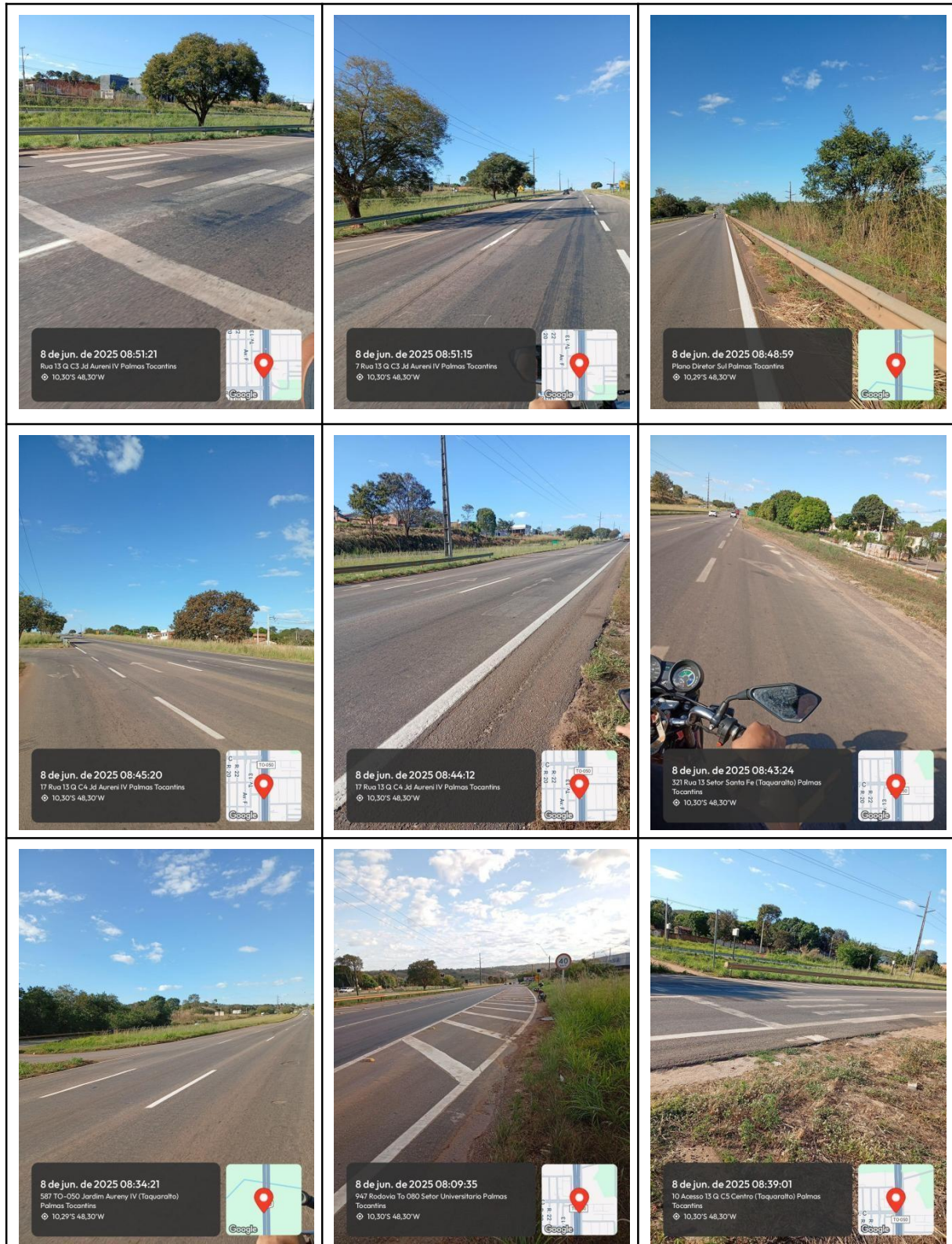
Figura 8: Situações observadas na via, sinalização horizontal
