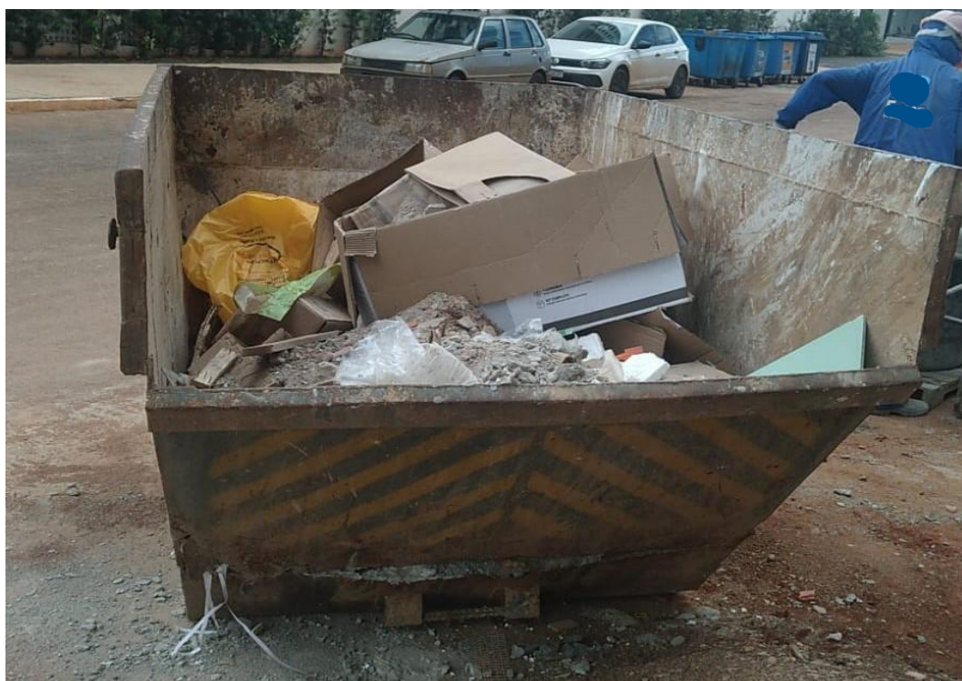
Figura 4 - Contêiner em obra residencial na Orla de Palmas.
