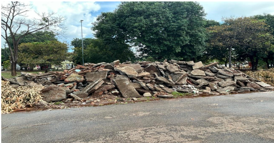
Figura 2 - Resíduos de Construção e Demolição na Quadra 108 Norte.
