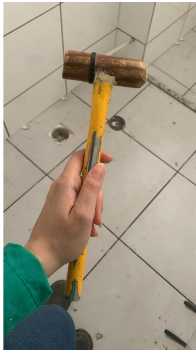
Figura 6 - Martelo utilizado para verificação de som cavo.
