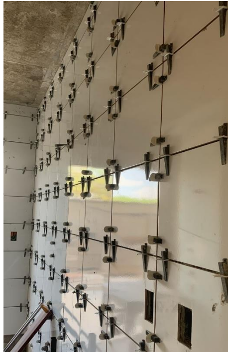
Figura 17 - Alinhamento das juntas com uso de espaçadores e cunhas.
