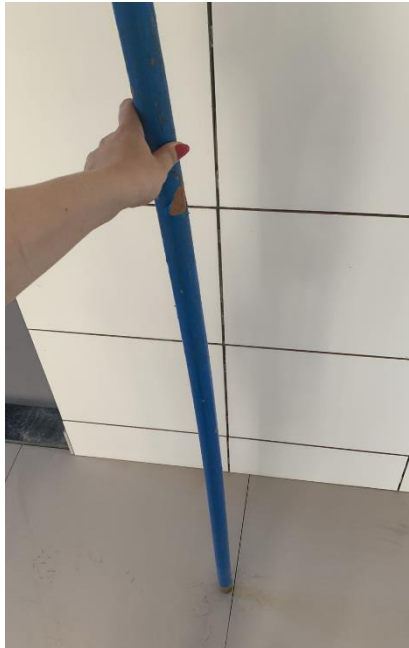
Figura 5 - Cabo utilizado para verificação de som cavo.
