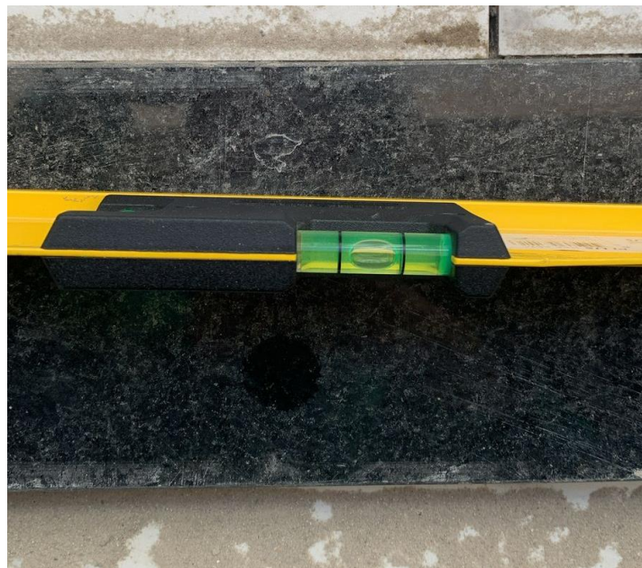
Figura 12 - Conferência de nivelamento de soleiras.
