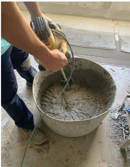
Figura 9 - Preparação da Argamassa Colante.
