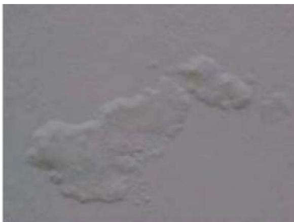
Figura 12 – Exemplo de empolamento
