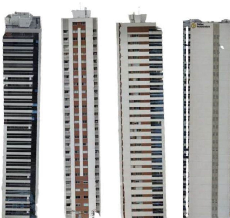
Figura 38 – Croquis de ortomosaicos das fachadas oeste, leste, norte e sul do edifício B
