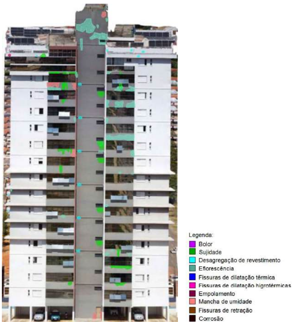
Figura 52 – Mapeamento das manifestações patológicas incidentes na fachada norte do Edifício D, com auxílio do Auto-Cad
