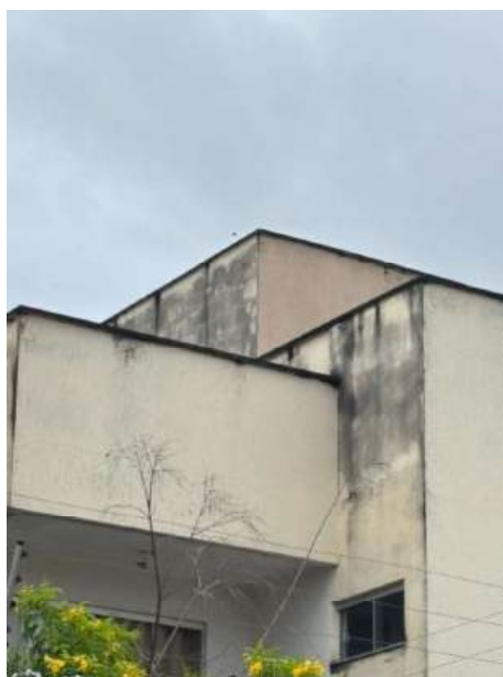
Figura 10 – Bolor incidente em uma fachada
