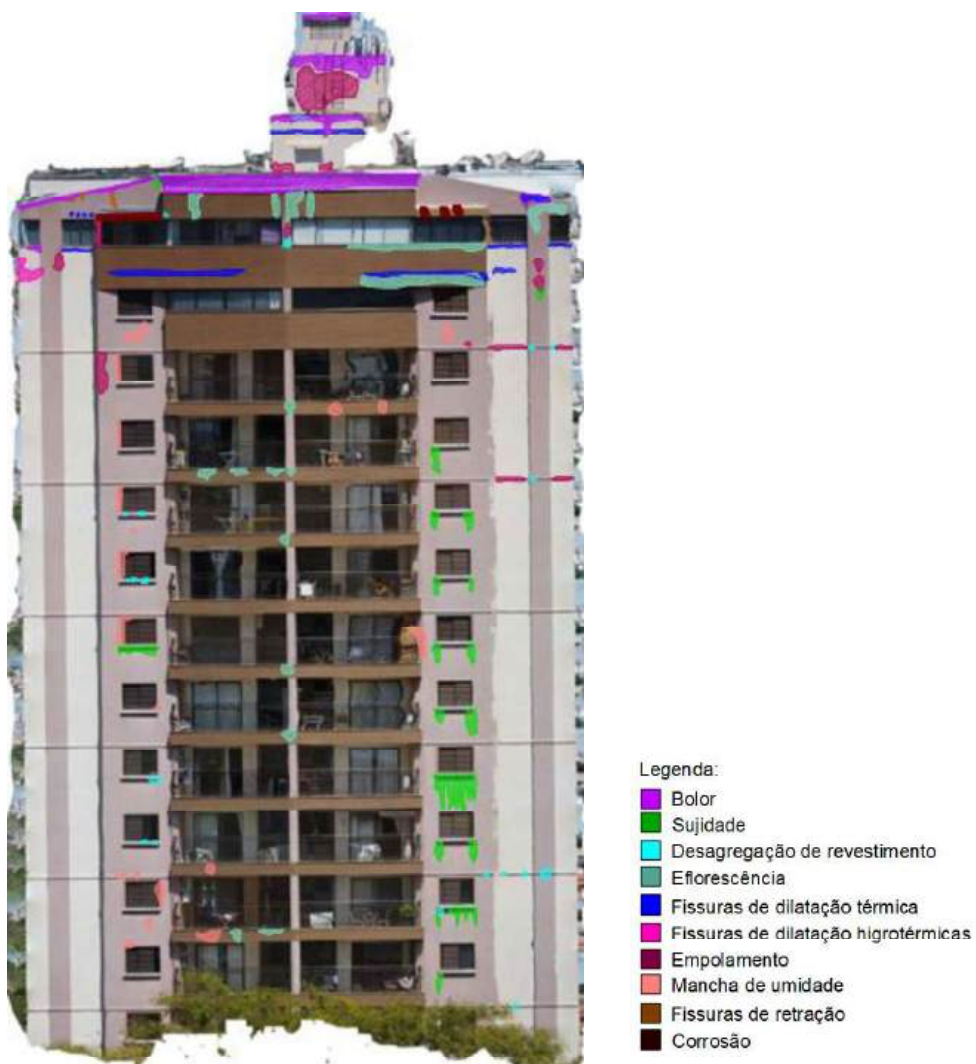
Figura 42 – Mapeamento das manifestações patológicas incidentes na fachada norte do Edifício A, com auxílio do Auto-Cad
