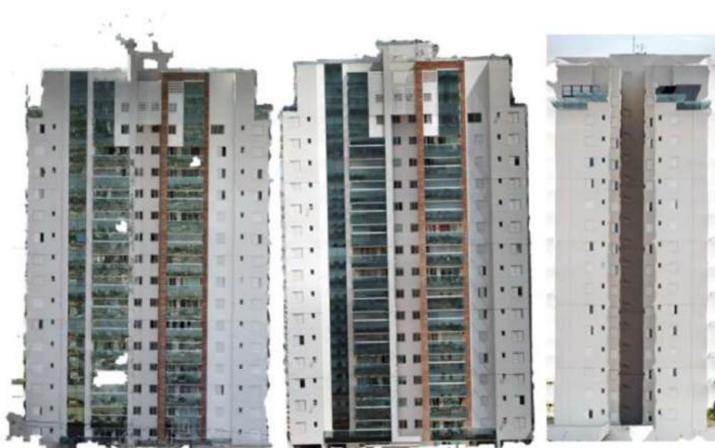
Figura 39 – Croquis de ortomosaicos das fachadas sul, norte e leste do edifício C
