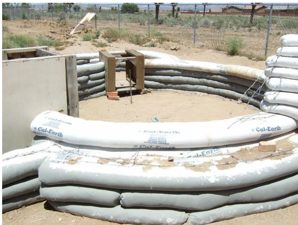
Figura 6 - Técnica do superadobe com sacos cheios de terra
