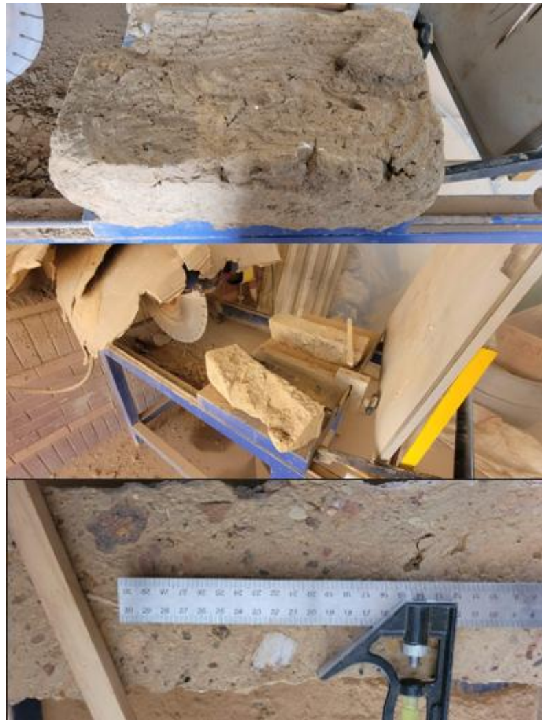
Figura 19 – Regularização dos blocos
