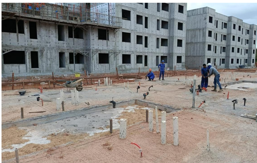
Figura 12 – Radier pronto para início da parede de concreto
