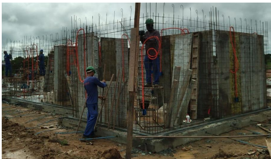
Figura 1 – Início da montagem da fôrma de parede
