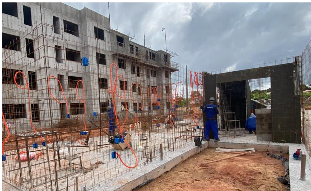
Figura 20 – Início de montagem de ciclo pela escada
