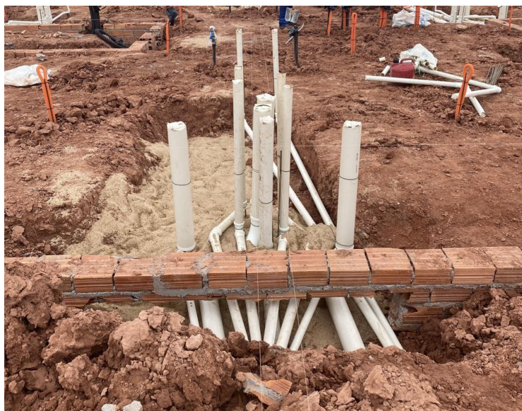
Figura 10 – Instalações hidrossanitárias do radier
