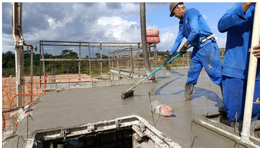
Figura 28 – Finalização de concretagem na laje
