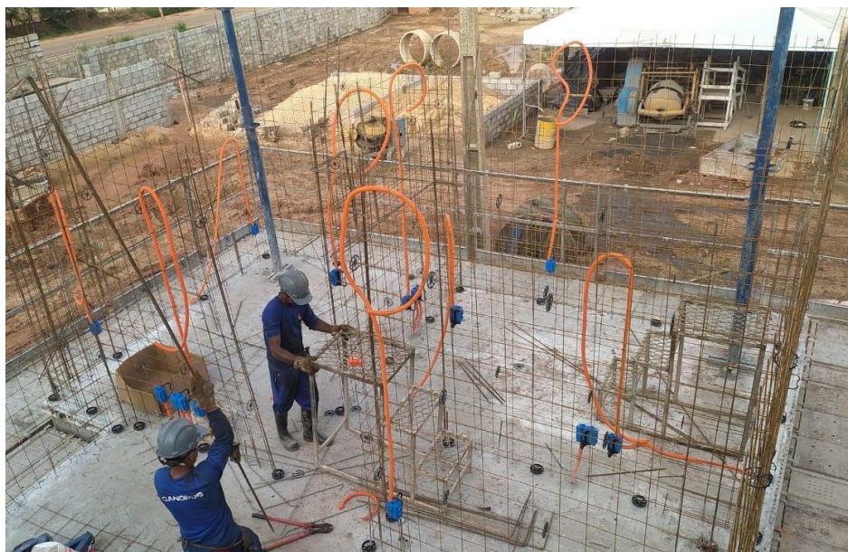
Figura 19 – Visualização dos espaçadores centralizadores de parede
