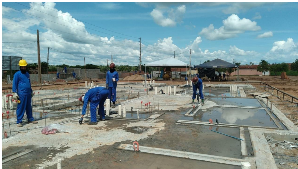
Figura 13 – Radier com mestras niveladas para receber a fôrma
