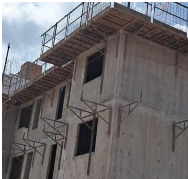
Figura 31 – Posição da mão-francesa da plataforma de proteção
