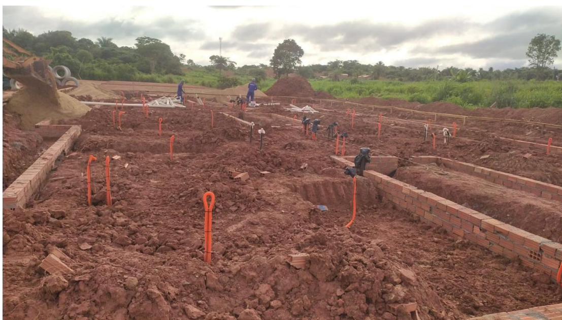
Figura 9 – Instalações de Dados, Voz, Imagem e Elétrica do radier
