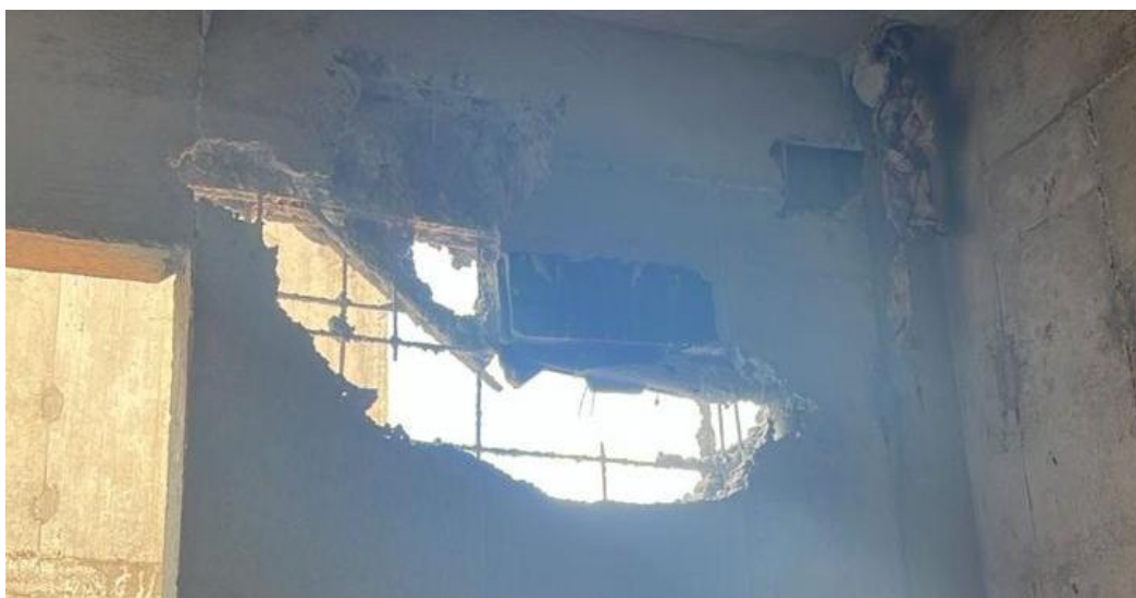
Figura 33 – Nicho de concretagem
