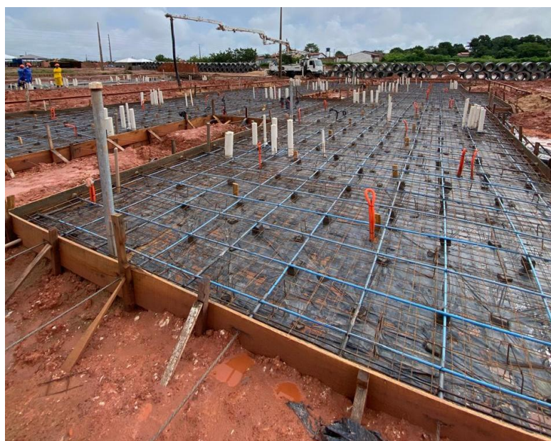
Figura 11 – Radier pronto para concretar
