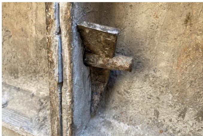
Figura 23 – Pino e cunha travando as placas da fôrma
