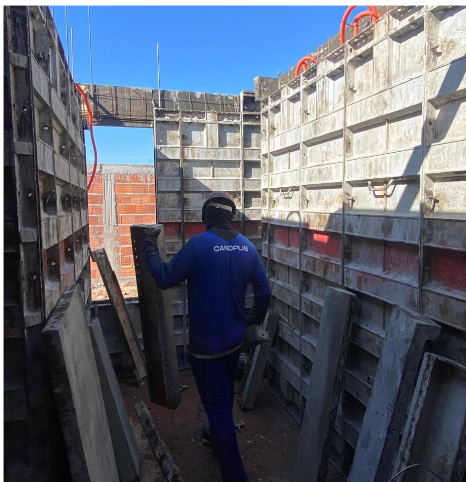
Figura 22 – Montagem de fôrma de parede
