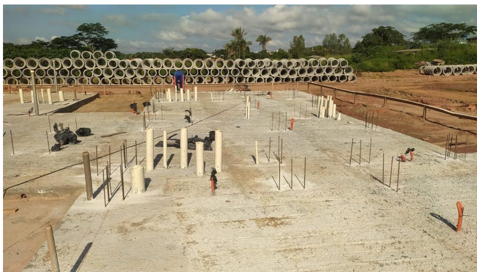
Figura 15 – Arranques de radier
