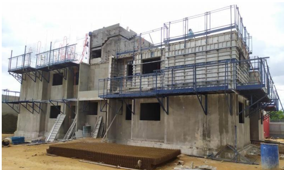
Figura 4 – Execução da fôrma com utilização de plataforma e proteção de periferia.
