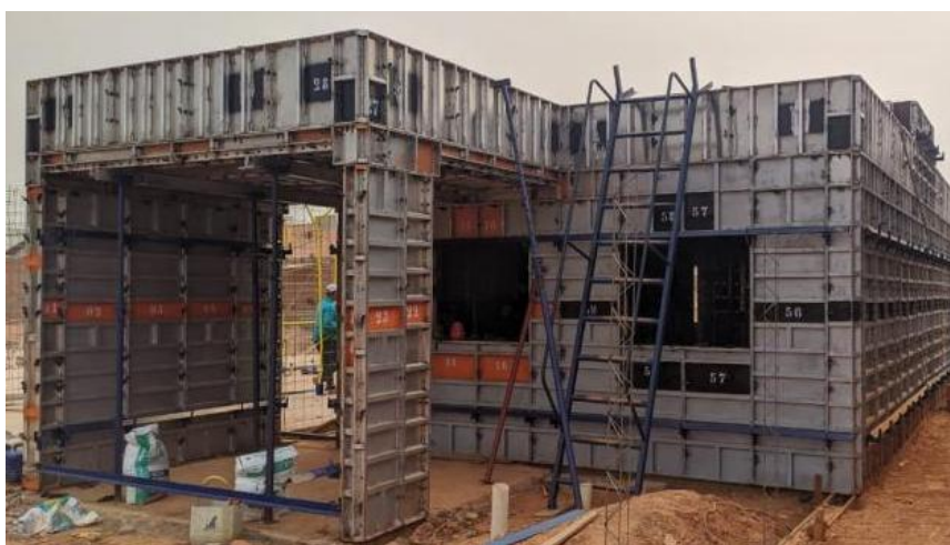
Figura 3 – Fôrma de alumínio para parede de concreto fechada
