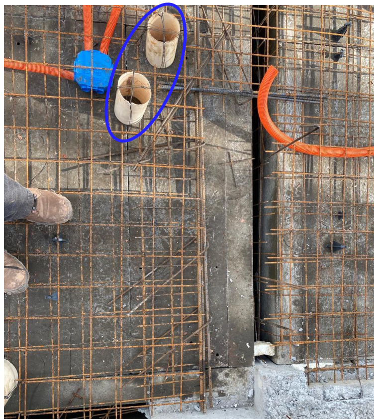
Figura 25 – Reforço estrutural em vão de shaft e passantes de banheiro
