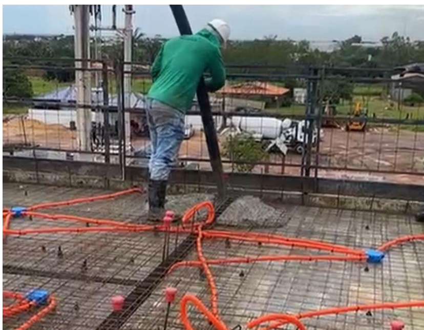
Figura 27 – Início de concretagem pelas paredes
