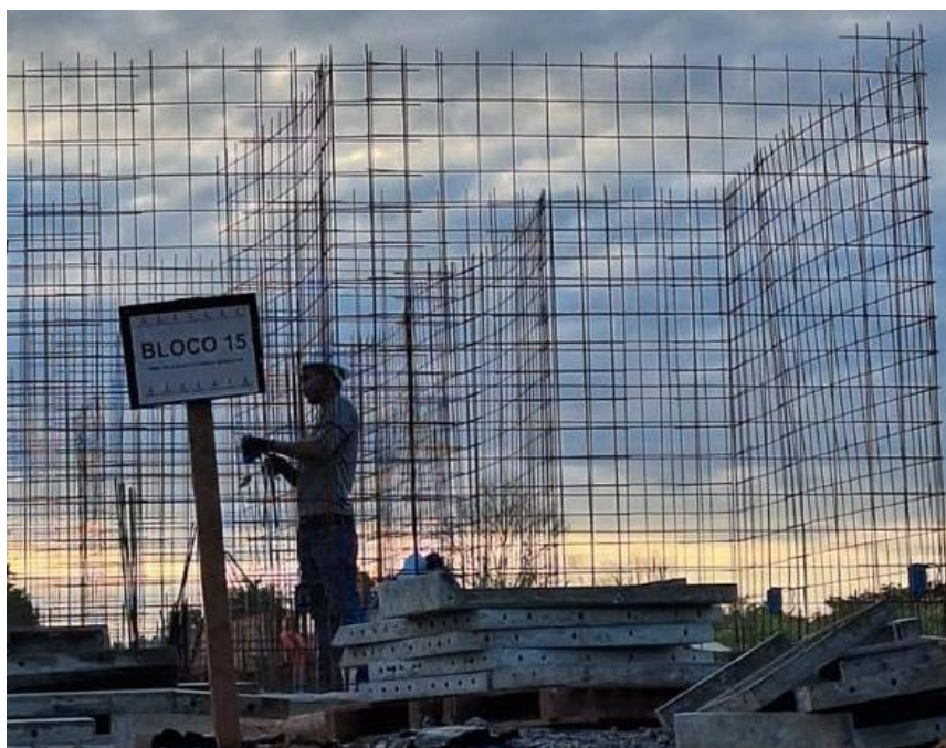
Figura 16 – Montagem da malha estrutural da parede
