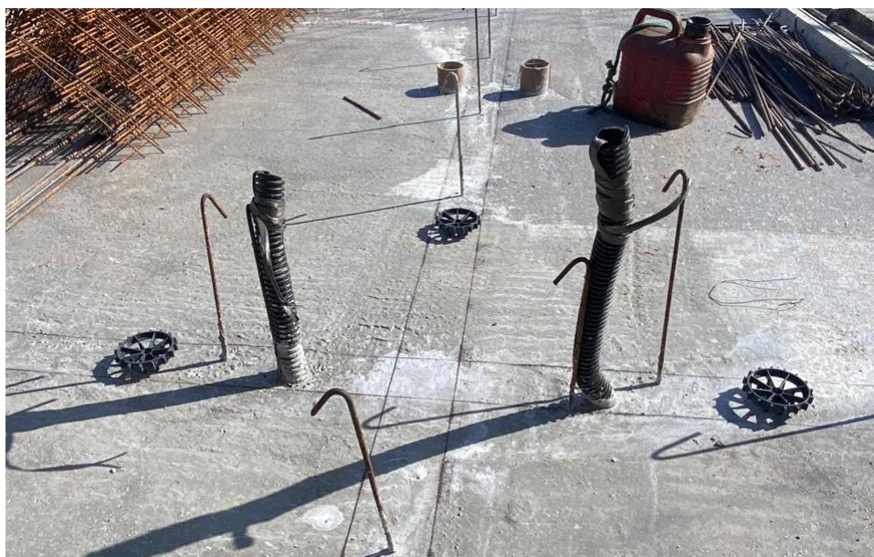
Figura 14 – Marcação de parede com espaçador de piso para fôrma
