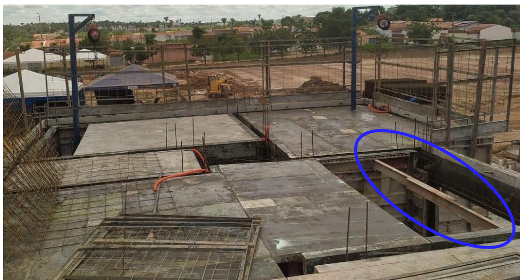
Figura 24 – Montagem de teto/laje
