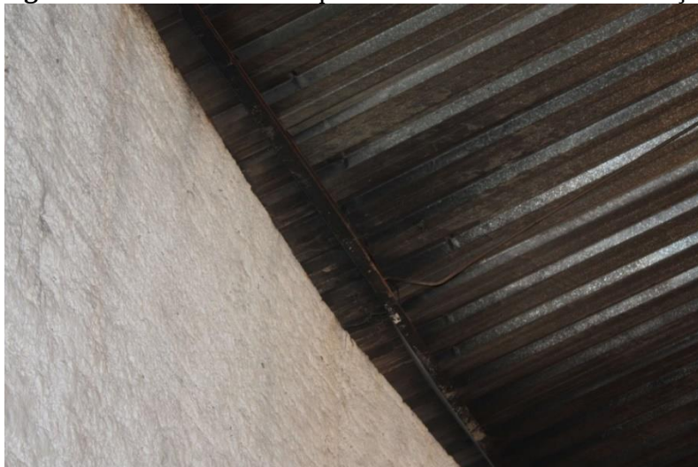
Figura 120 – Detalhe do arqueamento da alvenaria de vedação
