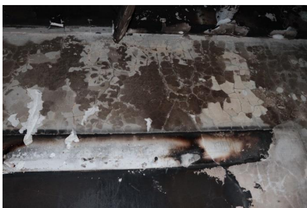
Figura 56 – Expansão higrotérmica no revestimento de gesso corrido dos painéis
