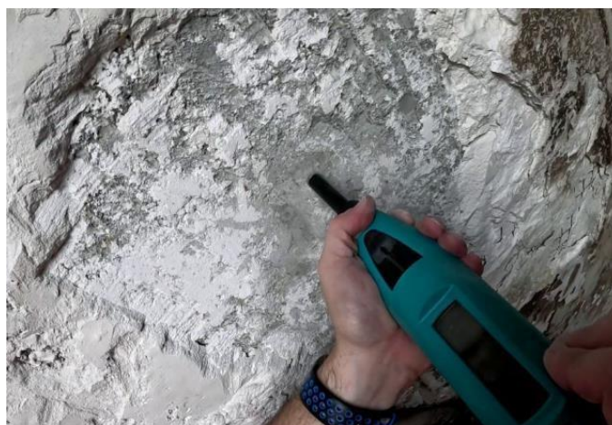
Figura 33 – Determinação da dureza superficial do concreto com esclerômetro de reflexão
