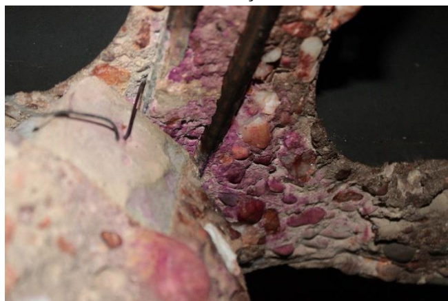
Figura 36 – Ensaio de determinação da frente de carbonatação
