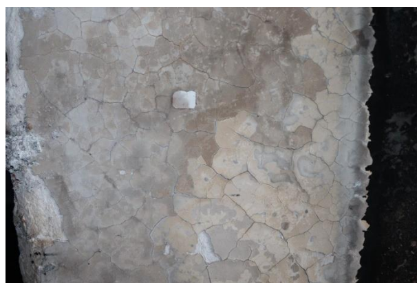
Figura 57 – Expansão higrotérmica no revestimento de gesso corrido dos painéis
