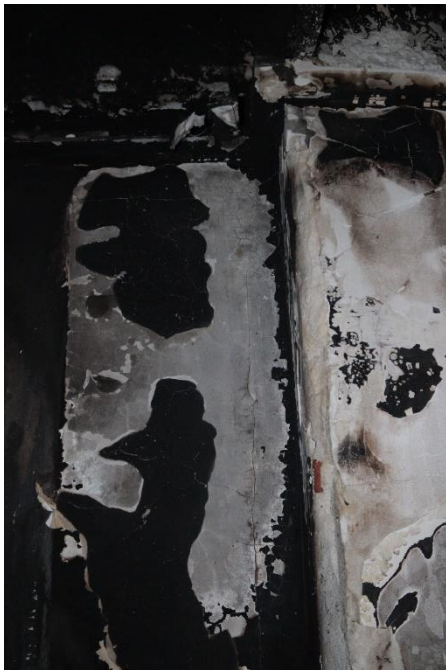
Figura 47 – Fissuras de mapeamento entre alvenaria e o pilar de concreto
