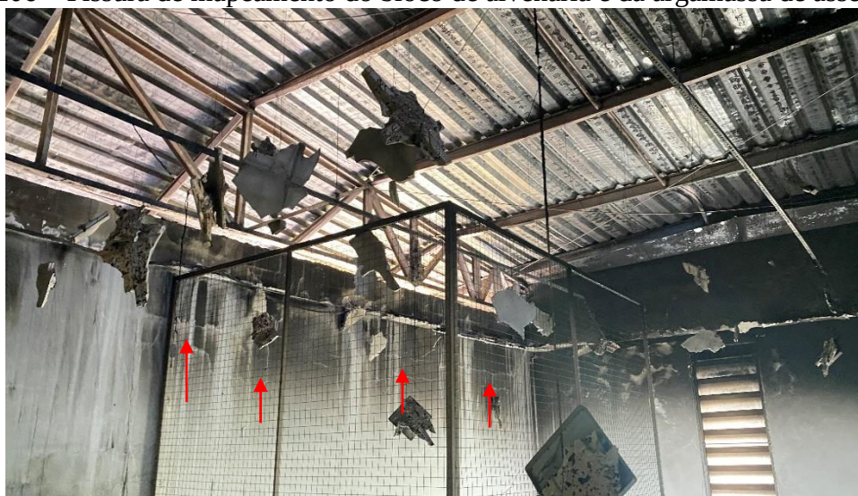
Figura 106 – Fissura de mapeamento do bloco de alvenaria e da argamassa de assentamento
