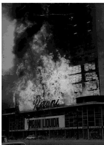
Figura 03 – O incêndio no edifício Andraus, em 1972
