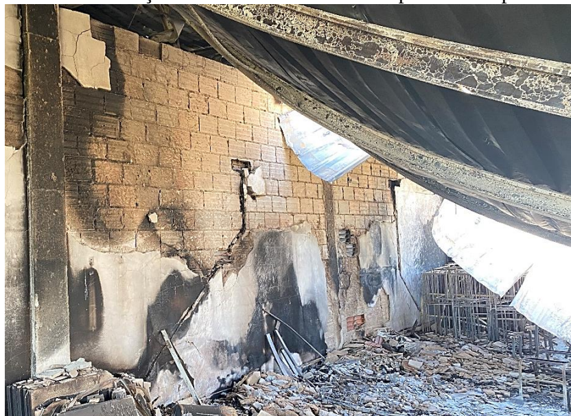
Figura 113 – Instalações de ar condicionado comprometidas pelo incêndio
