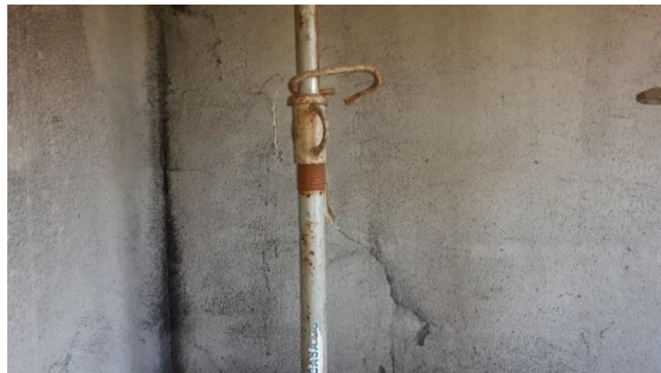
Figura 74 – Fissuras de mapeamento entre blocos e argamassa de assentamento
