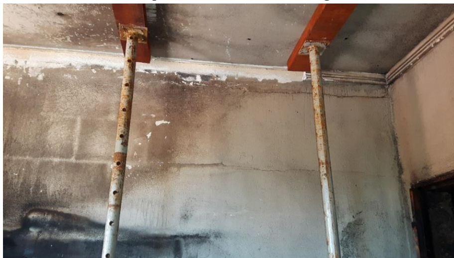
Figura 76 – Fissuras de mapeamento entre blocos e argamassa de assentamento
