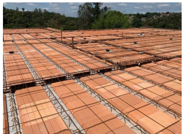
Figura 17 – Laje treliçada de bloco cerâmico
