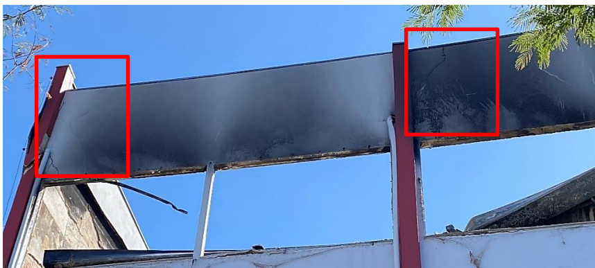
Figura 98 – Fissura e trincas na alvenaria da platibanda
