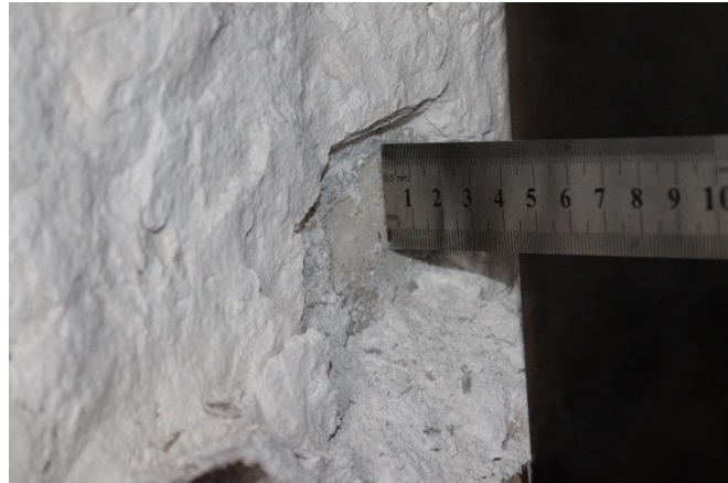
Figura 31 – Espessura do revestimento de gesso corrido
