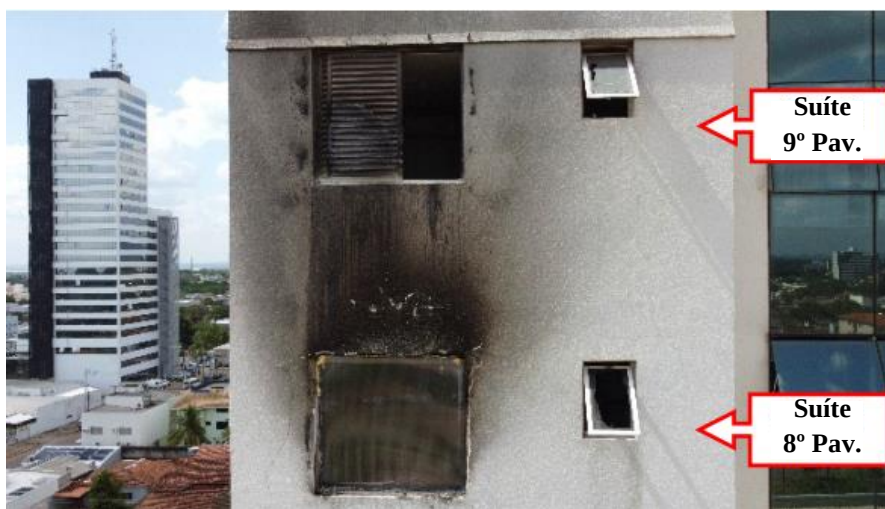
Figura 55 – Fissuras e degradação do revestimento da fachada
