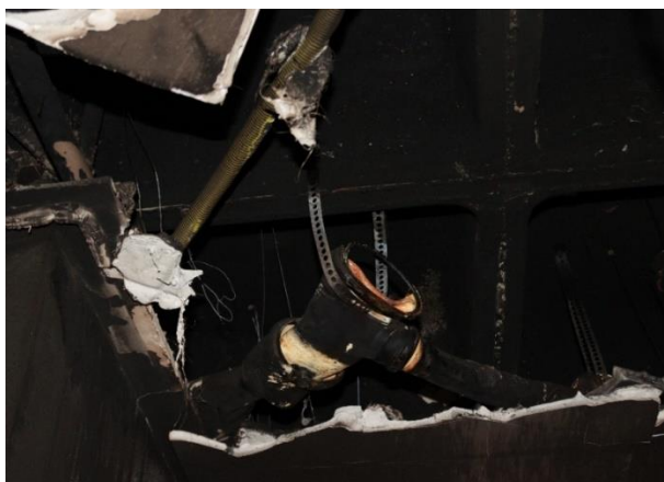
Figura 70 – Comprometimento das instalações sanitárias fixadas na laje
