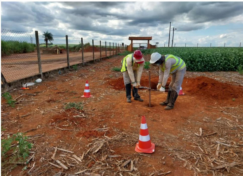
Figura 3.9 - Retirada de amostra deformada
