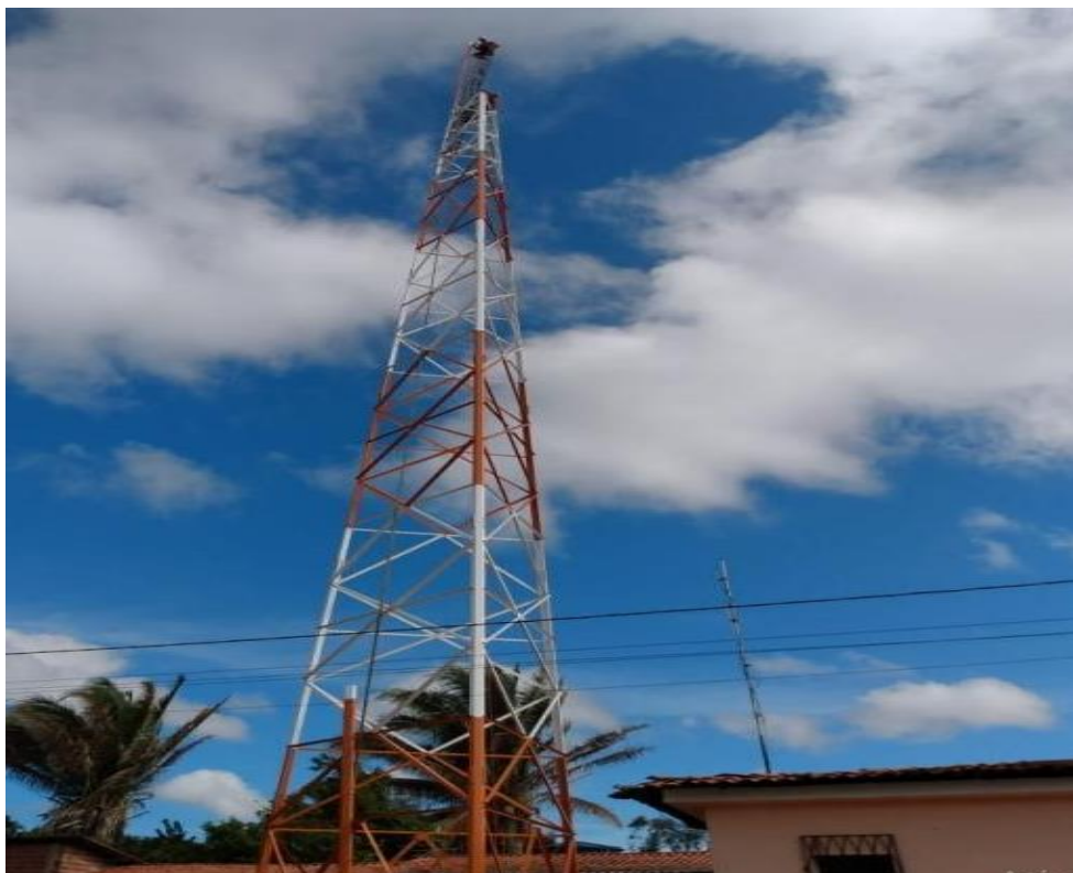
Figura 3.1 - Torre telefonia treliçada
