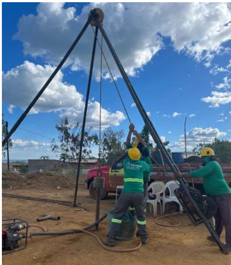
Figura 13 - Ensaio de sondagem à percussão
