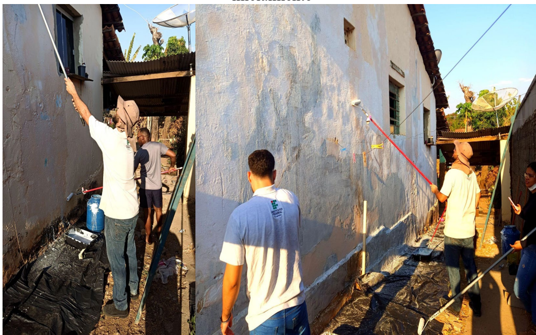
Figura 29 - Realização da primeira demão, percebe-se a cal sendo translúcida na parede inicialmente
