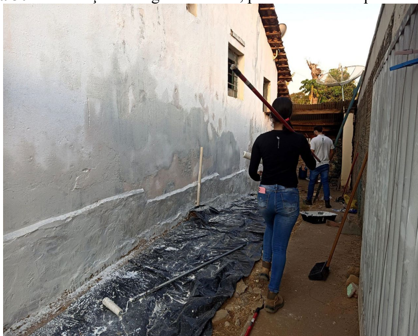
Figura 30 - Realização da segunda demão, percebe-se a cal aparecendo mais
