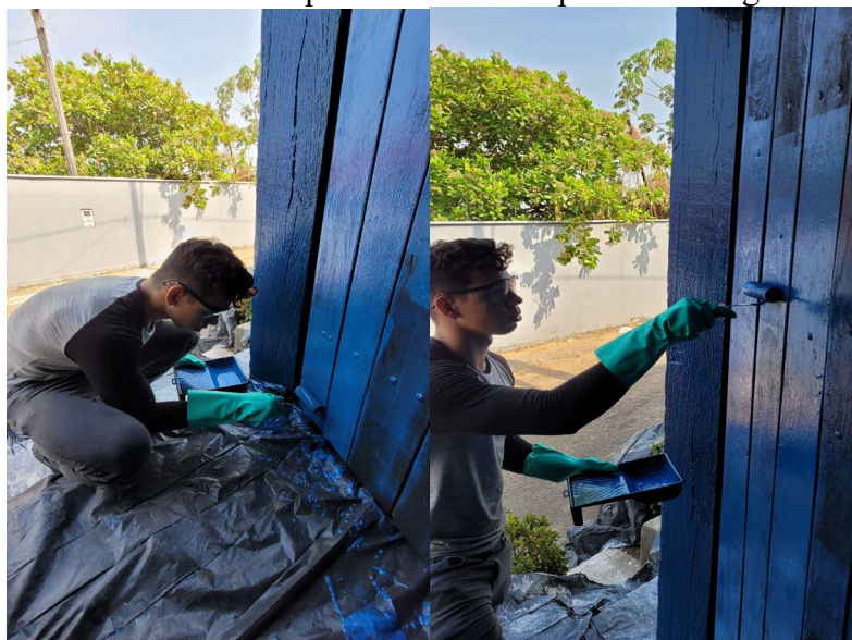
Figura 34 - Pintura de esquadrias realizado pelo IFTO segunda demão
