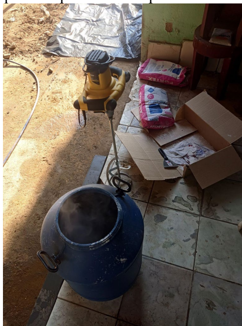
Figura 26 - Preparativo para mistura apenas com cal hidratada e água
