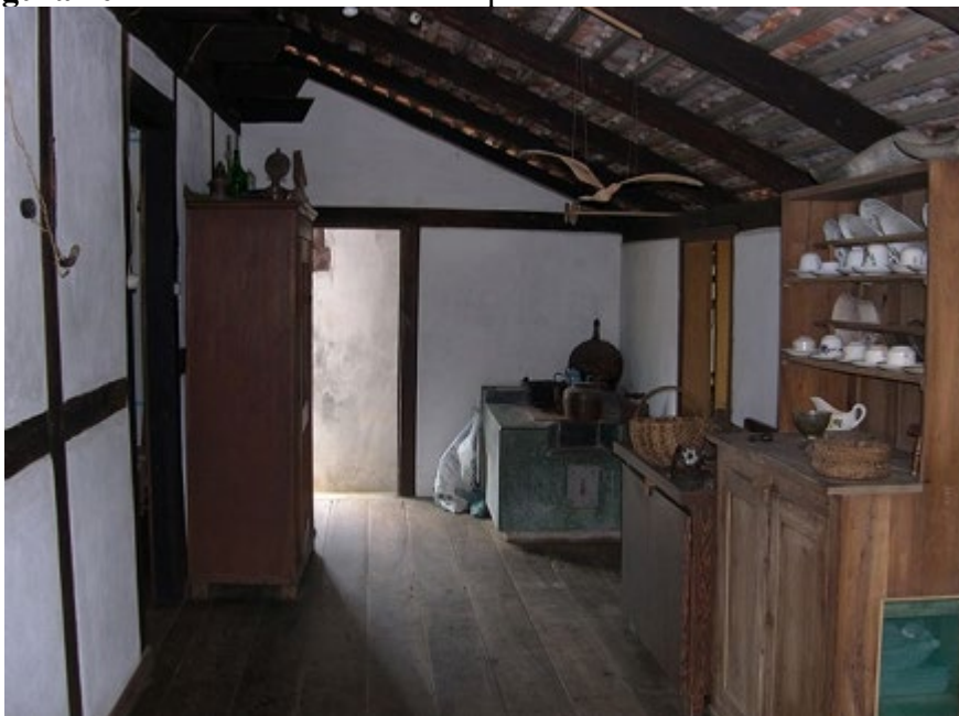
Figura 20 - Casa Lumke demonstra piso de madeira e estrutura enxaimel
