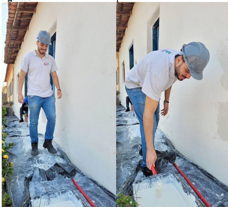
Figura 31 - Última camada e a pintura branca da cal se destaca
