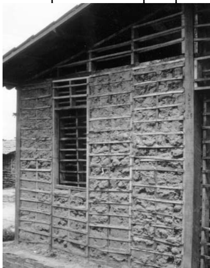
Figura 2 - Sistema pré-fabricado para pau a pique, Brasil
