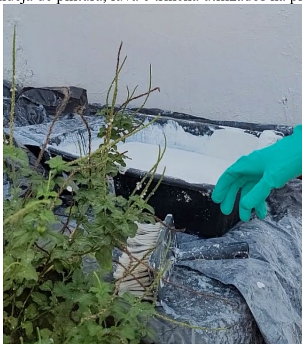
Figura 24- Bandeja de pintura, luva e trincha utilizados na pintura pelo IFTO
