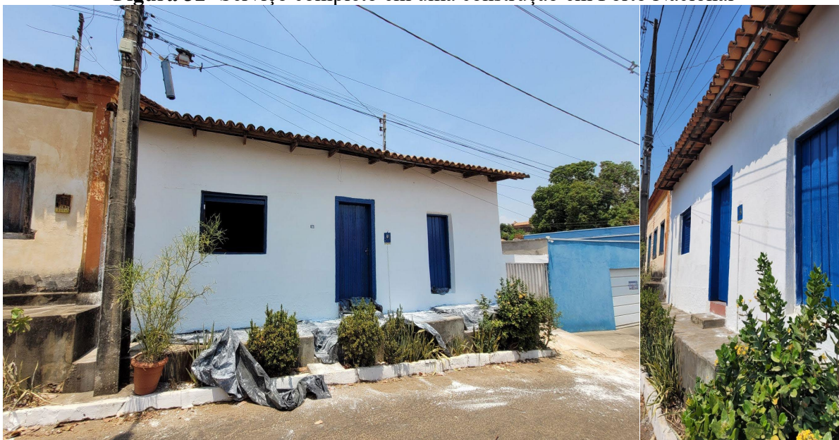
Figura 32- Serviço completo em uma construção em Porto Nacional
