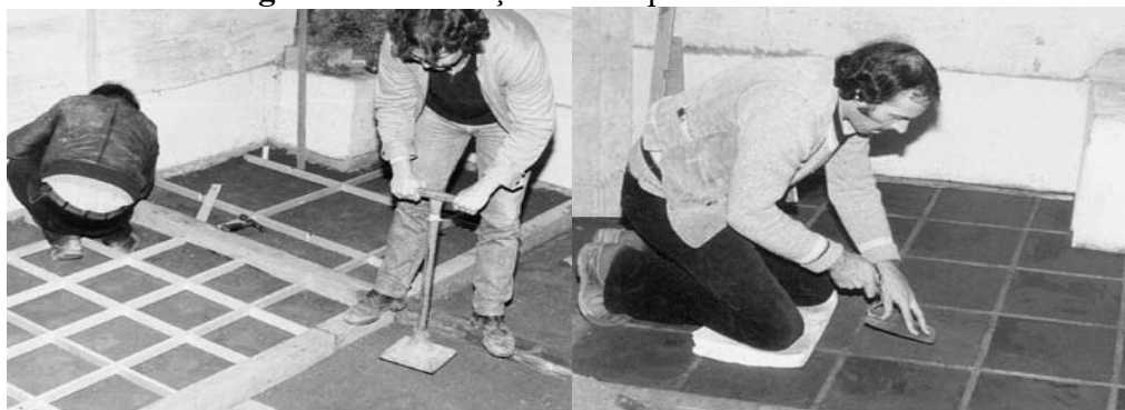
Figura 16 - Execução de um piso de terra batida
