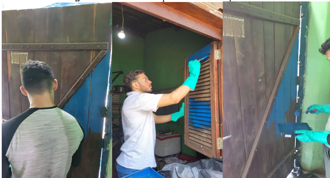
Figura 33 - Pintura de esquadrias realizado pelo IFTO
