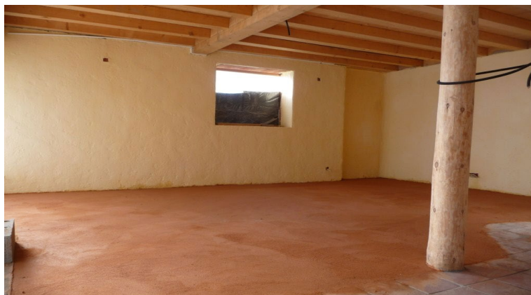
Figura 14 - Exemplificação de terra batida após o tratamento
