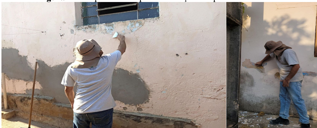
Figura 12 - Reparo com espátula remoção das partes deterioradas
