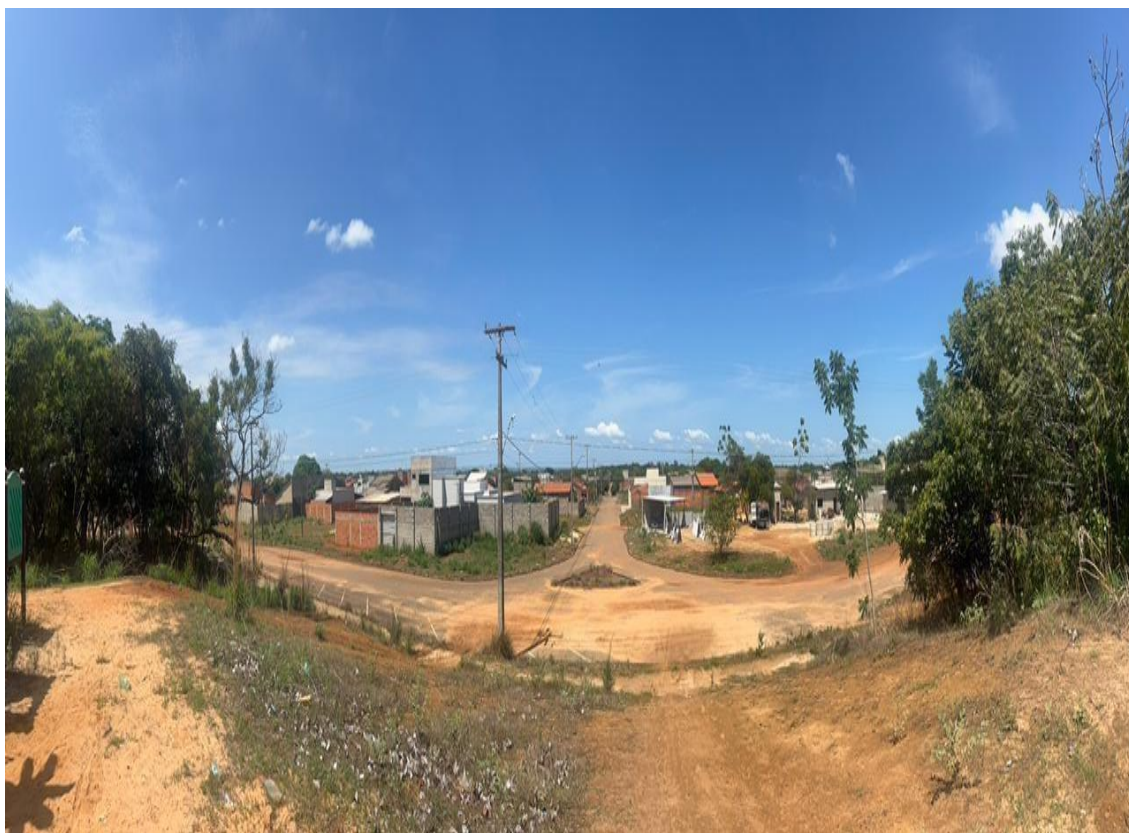
Figura 3.13 – Vista da área a jusante da barragem, evidenciando ocupação urbana próxima.
