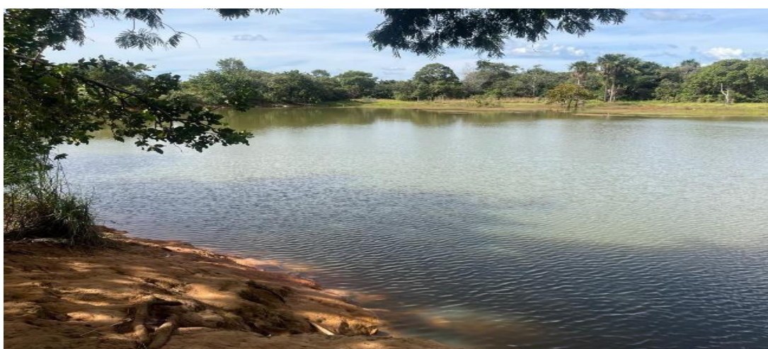
Figura 3.1 – Vista lateral do reservatório no período chuvoso (março/2025)
