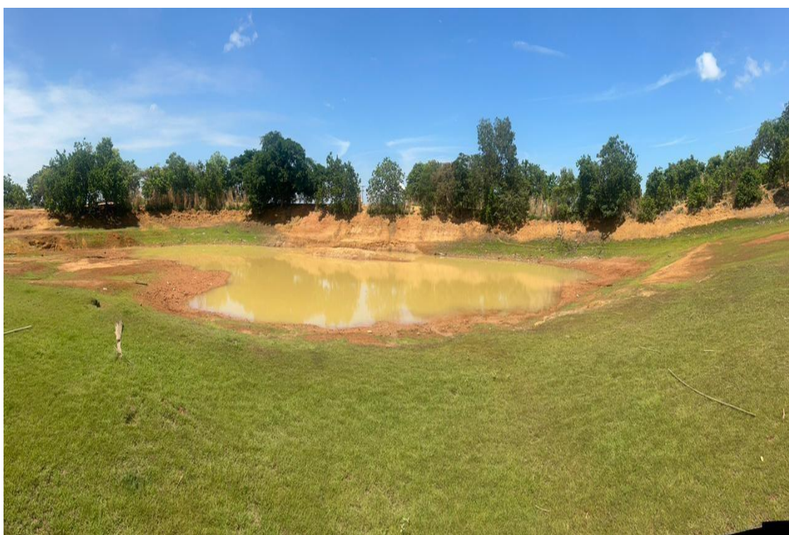
Figura 3.6 – Vista geral do reservatório durante a estiagem (novembro/2025)
