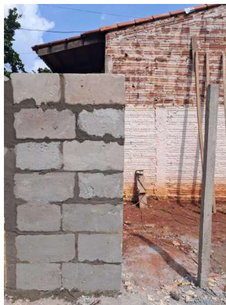
Figura 23 - Alvenaria pronta
