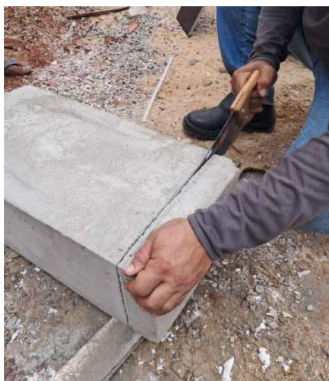
Figura 20- Corte dos blocos
