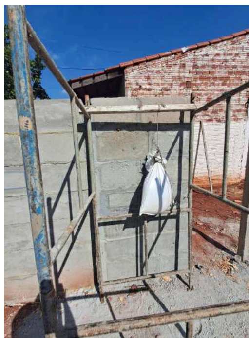
Figura 25 - Estrutura de impacto utilizada
