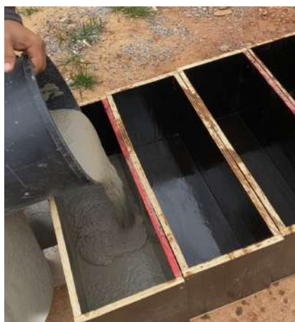
Figura 15 - Concreto celular despejado nas fôrmas
