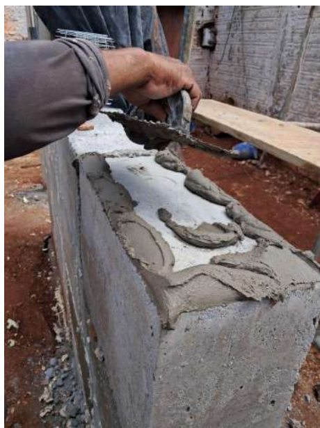
Figura 22- Assentamento dos blocos
