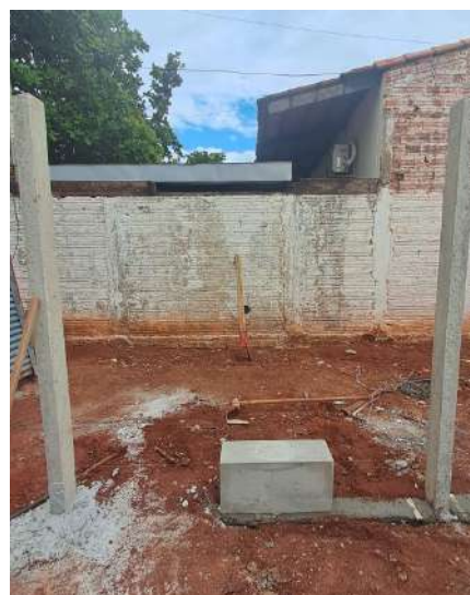
Figura 21- Posicionamento dos blocos
