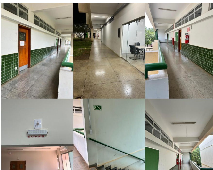
Figura 34 – Sinalização dos blocos 16 e 17
