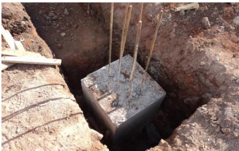
Figura 5 – Bloco de Fundação
