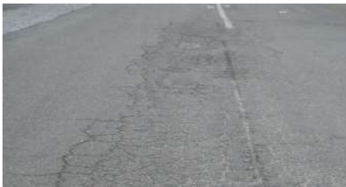
Figura 3. Degradação do tipo rodeira
