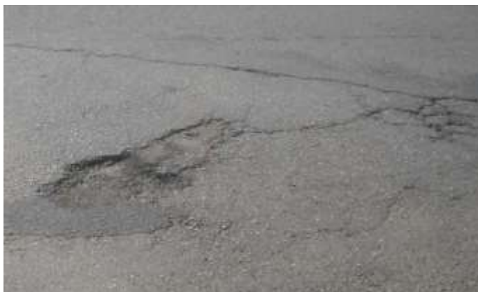
Figura 5. Degradação do tipo pelada
