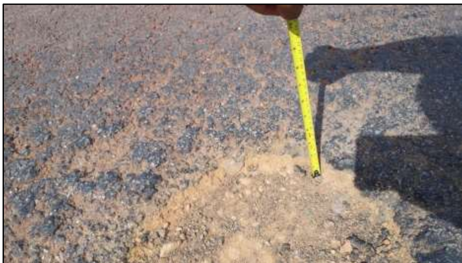
Figura 21. Realização da inspeção na camada de TSD
