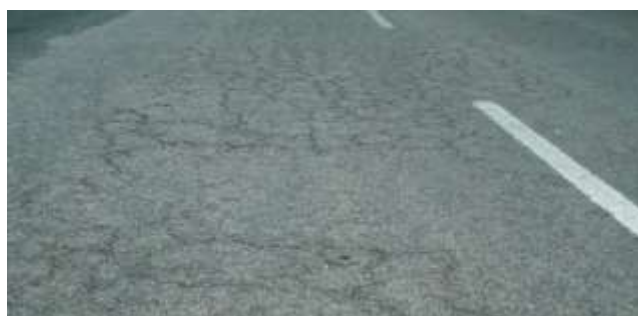
Figura 4. Degradação do tipo pele de crocodilo
