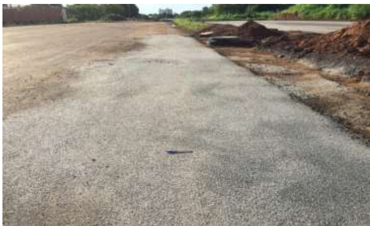
Figura 29 - Patologia 05: remendo.
