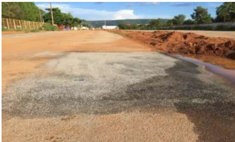
Figura 30 - Patologia 06: remendo.
