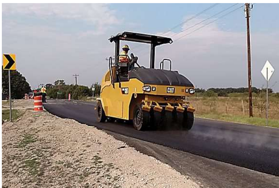
Figura 10 - Compactação do revestimento com rolo de pneu.
