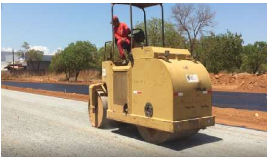
Figura 8 - Compactação da camada de agregado.
