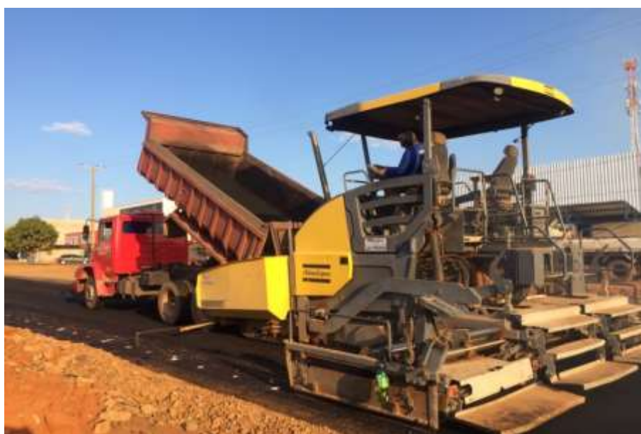
Figura 9 - Aplicação de CBUQ.
