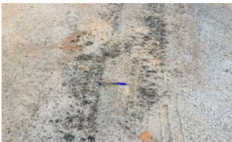
Figura 27 - Patologia 03: escorregamento.
