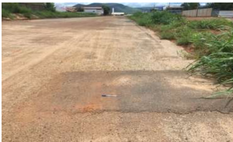
Figura 25 - Patologia 01: remendo.
