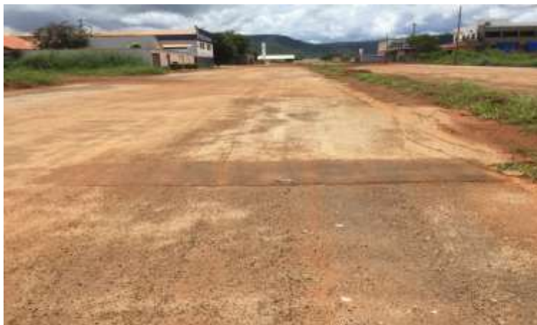
Figura 26 - Patologia 02: remendo.
