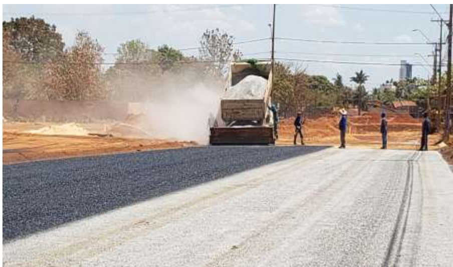
Figura 7 - Espalhamento da segunda camada de agregado.
