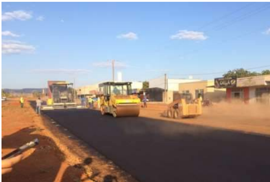
Figura 11 - Compactação do revestimento com rolo tandem liso.
