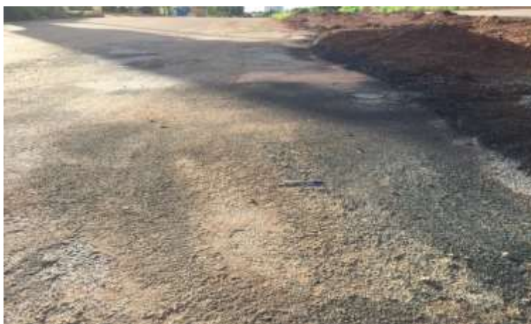
Figura 28 - Patologia 04: remendo.
