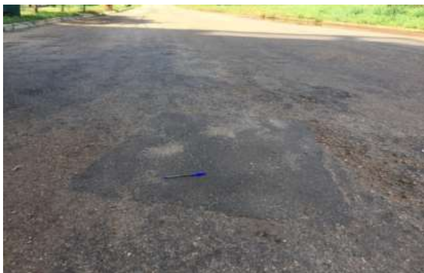
Figura 19 - Exemplo de remendo. Local: Avenida NS-08, Palmas-TO.
