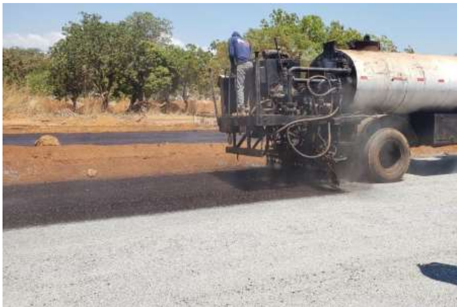
Figura 5 - Aplicação da segunda camada de ligante betuminoso.
